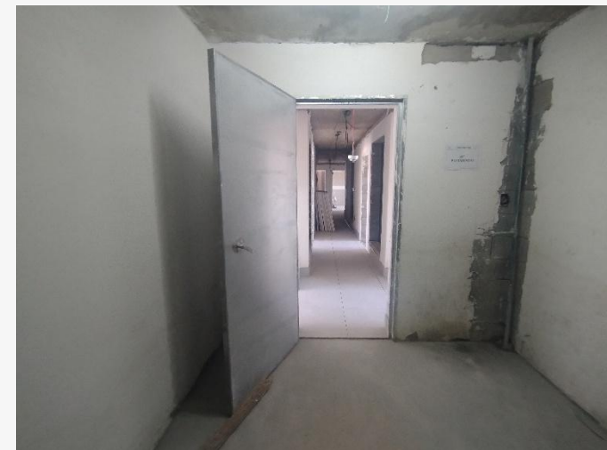
Porta Corta Fogo – 23° Pav.
