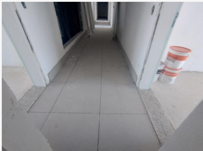
Rodapé Cerâmico – 17º Pav.
