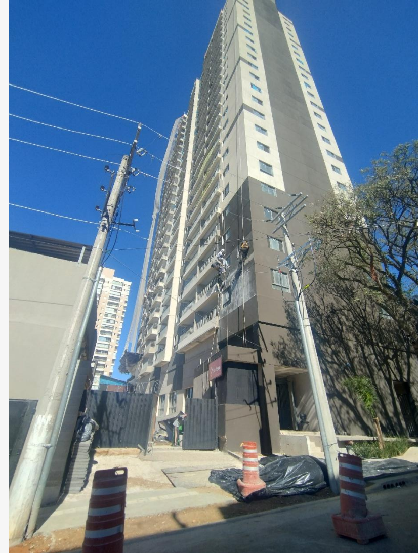
Vista Fachada Lateral
