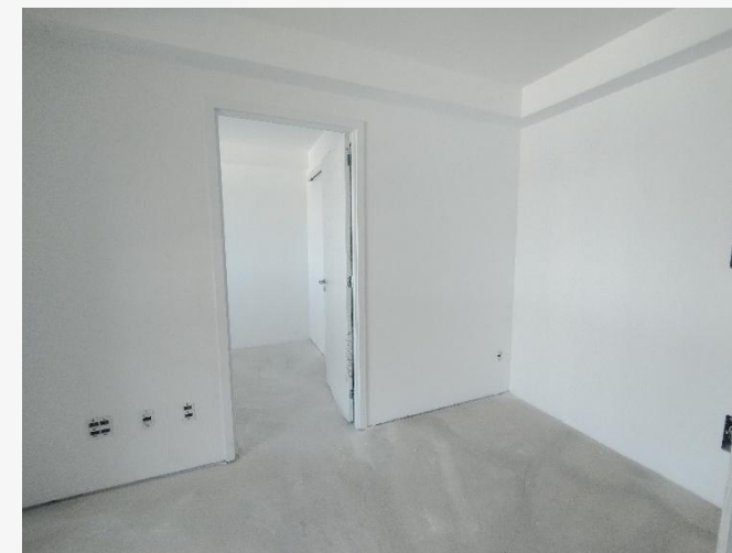
Pintura Interna – 03º Pav.
