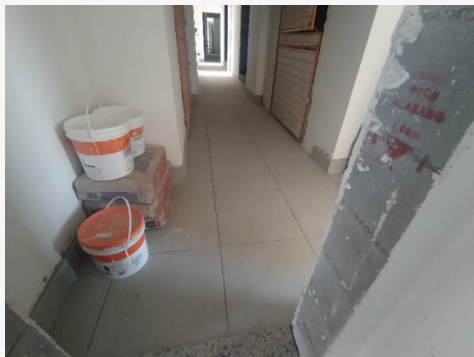
Piso Cerâmico – 19° Pav.
