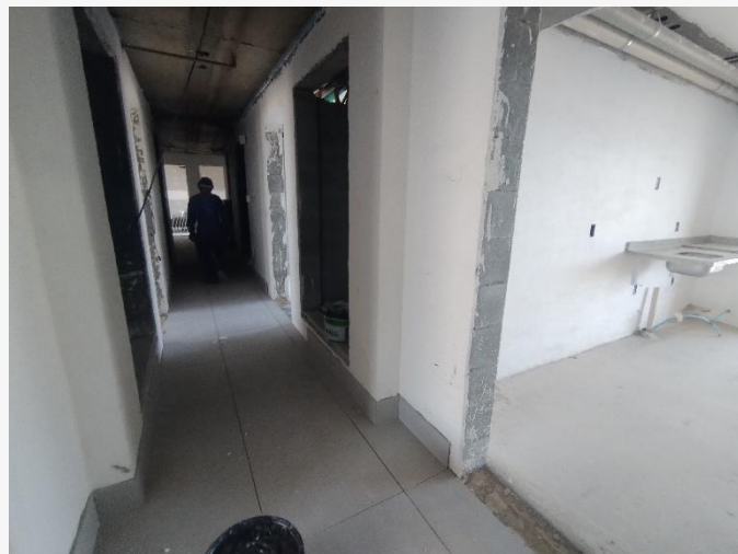
Piso Cerâmico – 25° Pav.
