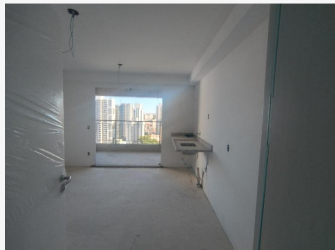
Pintura Interna – 16º Pav.
