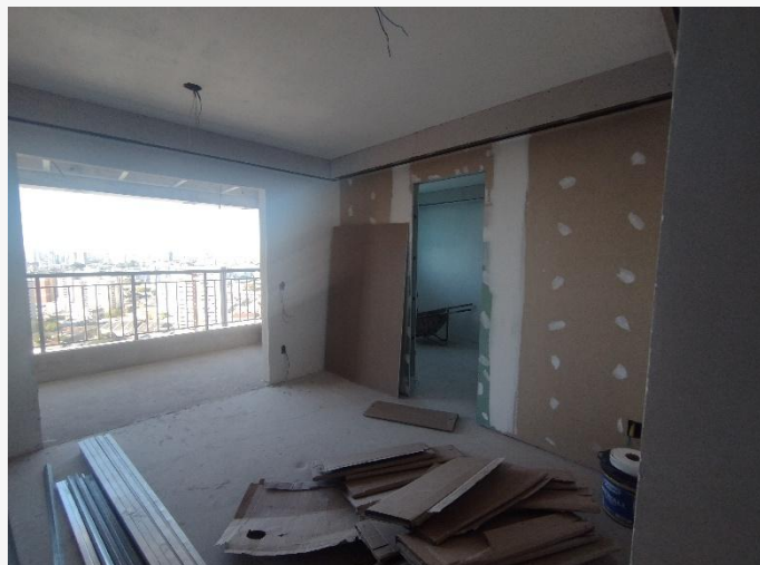
Alvenaria em Drywall – 22° Pav.
