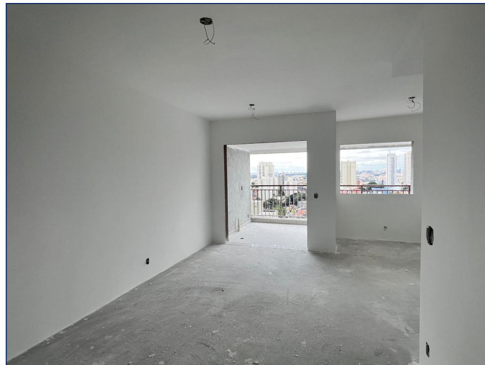
Foto 14 – pintura 1ª demão – 15º pavimento
