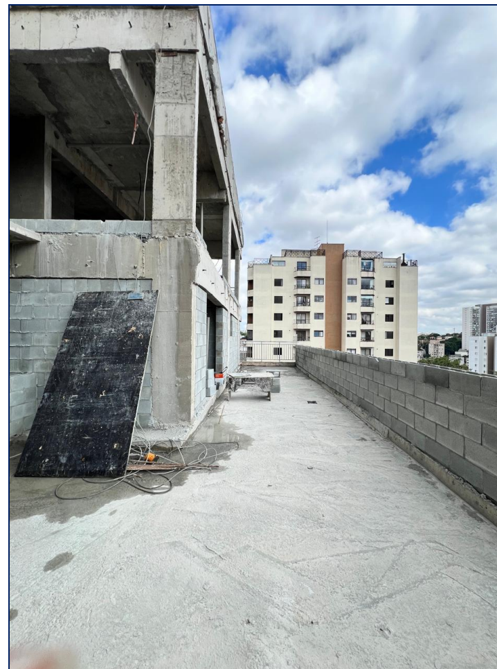
Foto 20 – Laje técnica NR
