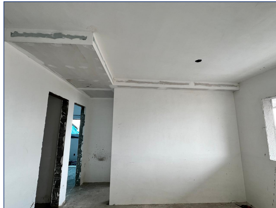
Foto 8 – Forros e sancas 20º pavimento
