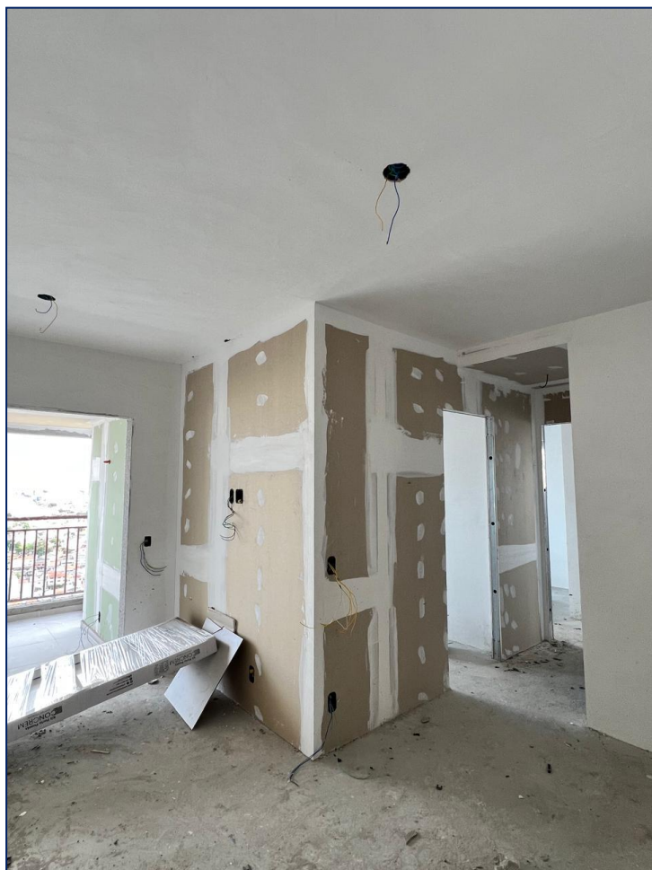
Foto 11 – Drywall 19º pavimento
