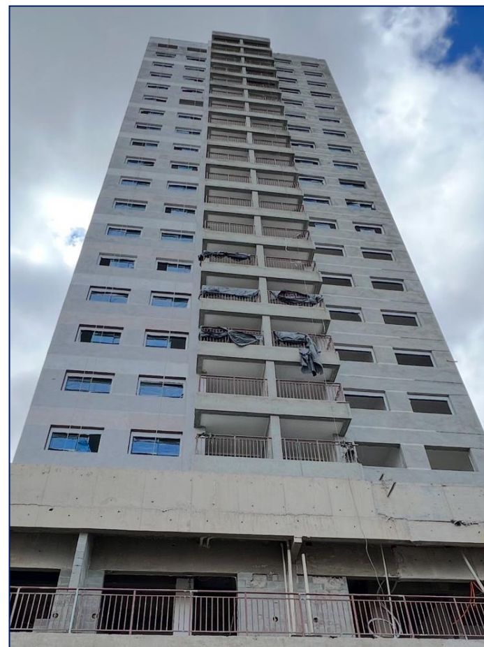
Foto 2 - Visão geral torre
