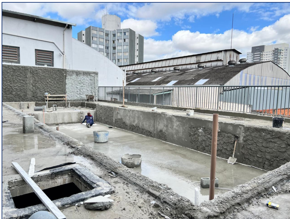
Foto 21 – Visão geral da piscina
