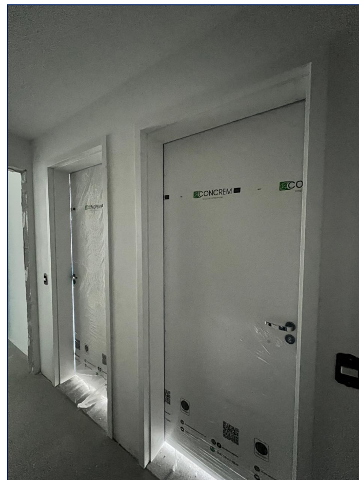
Foto 16 – Portas de entrada – 12º pavimento
