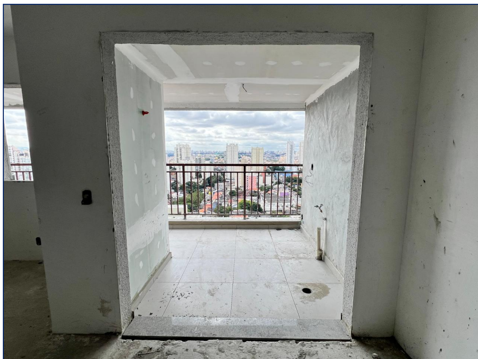
Foto 09 – Piso terraço - 20º pavimento
