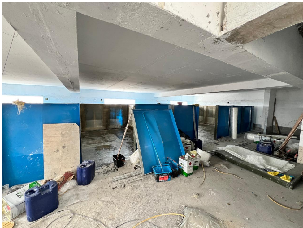
Foto 3 - Visão geral do barrilete e reservatórios em montagem
