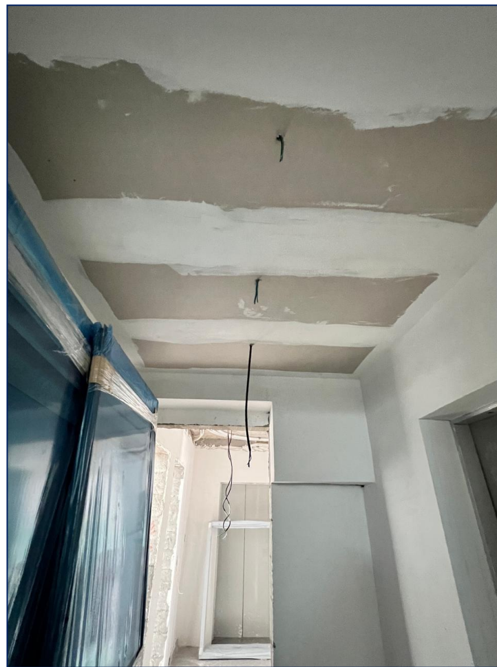
Foto 12 – Forro Hall – 17º pavimento
