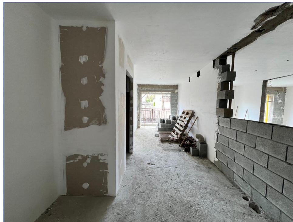
Foto 18 – Fechamento alvenaria 1º pavimento NR
