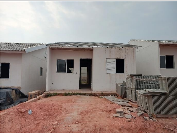
Telhados em execução
