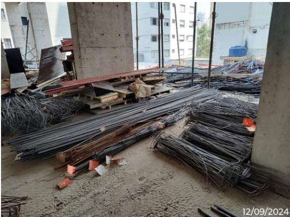
13 Térreo - Área de estoque de aço.
