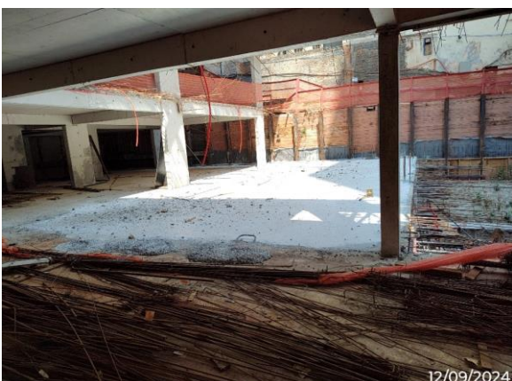
17 2ºSubsolo - Concretagem parcial de laje de periferia.
