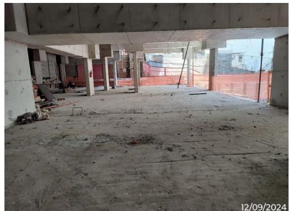
16 1ºSubsolo - futura área de vivência.
