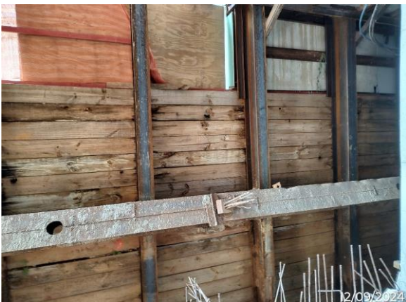
15 Cortina, ainda com vigas de travamento provisório.
