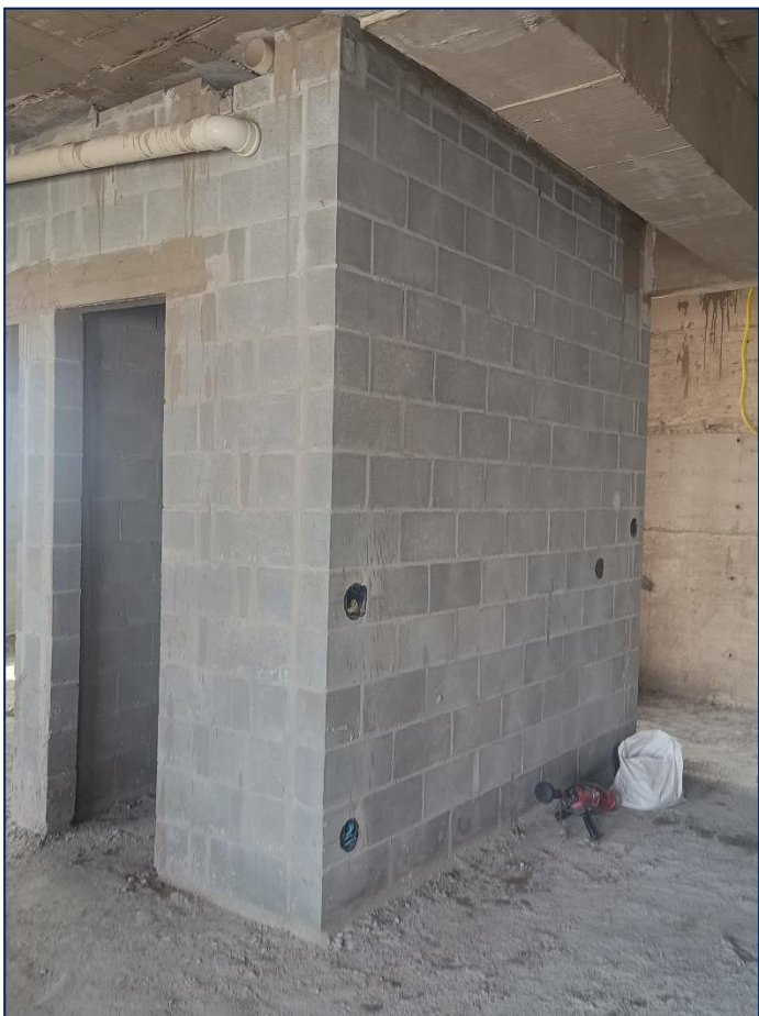
Foto 03 – Alvenaria – 21º pavimento
