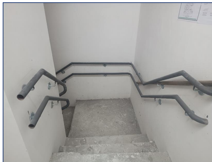
Foto 06 – Corrimão – 14º pavimento
