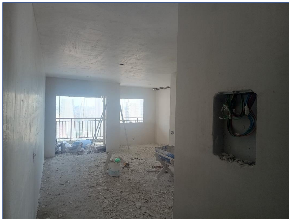
Foto 04 – Gesso – 17º pavimento
