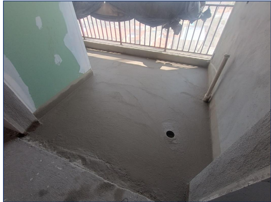
Foto 08 – Impermeabilização – terraço – 5º pav
