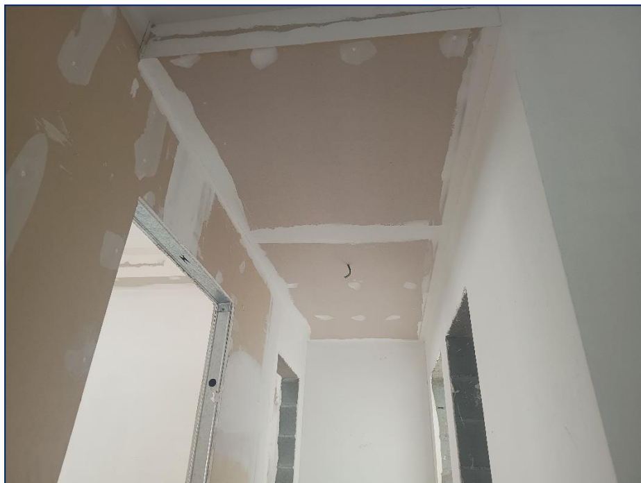
Foto 09 – Instalação de forro – 4º pav
