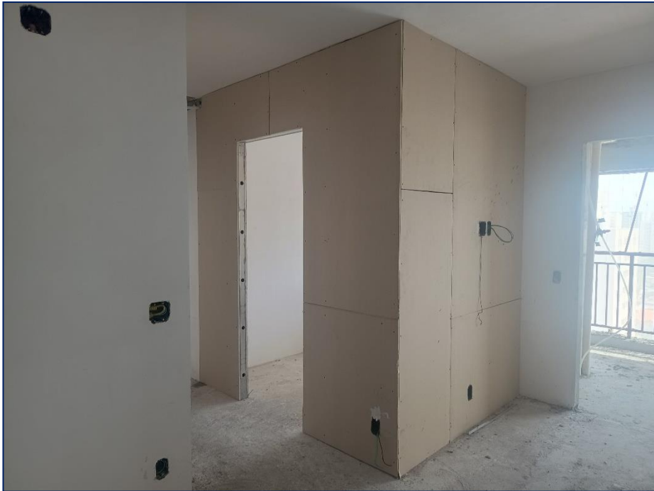
Foto 07 – Drywall – plaqueamento – 11º pav
