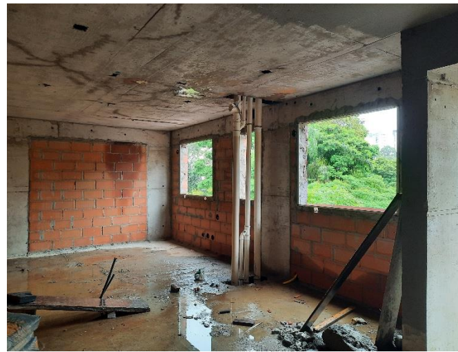
Alvenaria/ Vedação – 3º Pav
