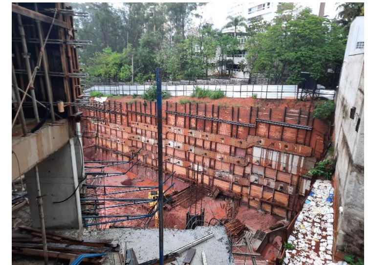
Vista da Obra
