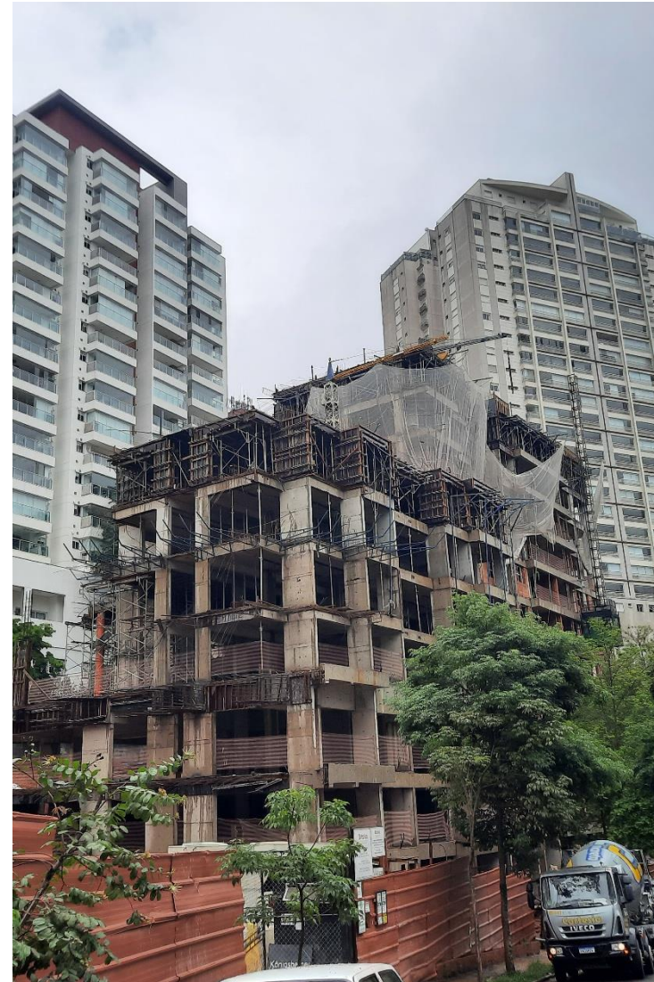
Vista da Fachada
