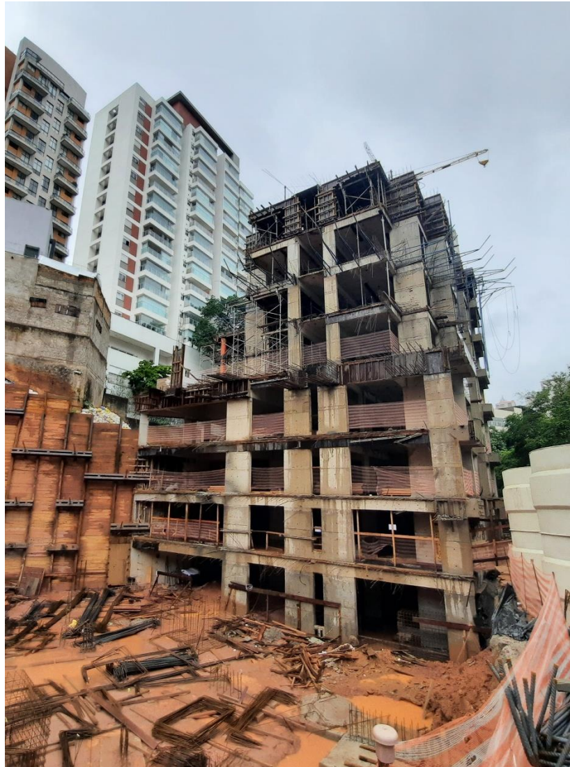
Vista da Fachada Lateral
