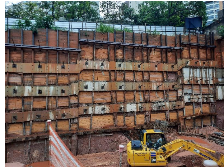
Cortina de Contenção
