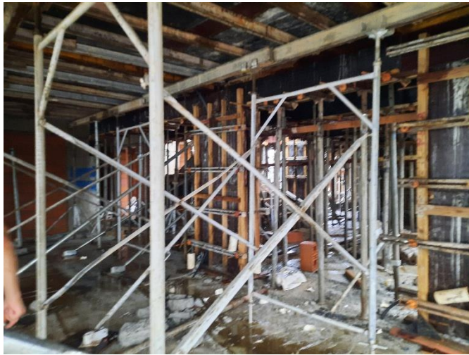
Escoramentos – 11º Pav T Safira
