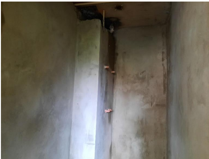
Reboco Interno – 4º Pav
