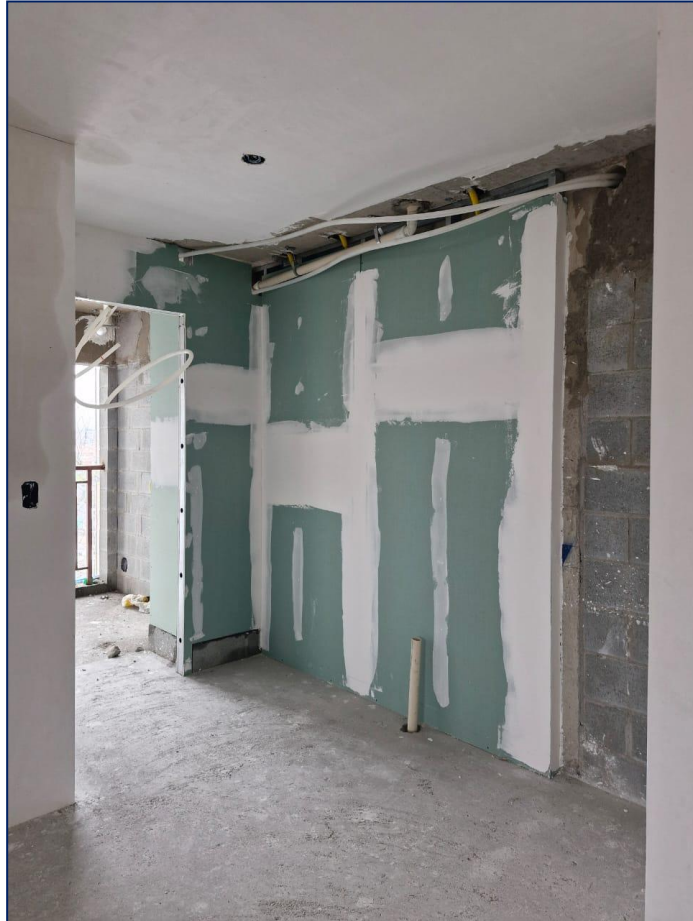
Foto 11 – Visão geral plaqueamento de Drywall de unidades privadas
