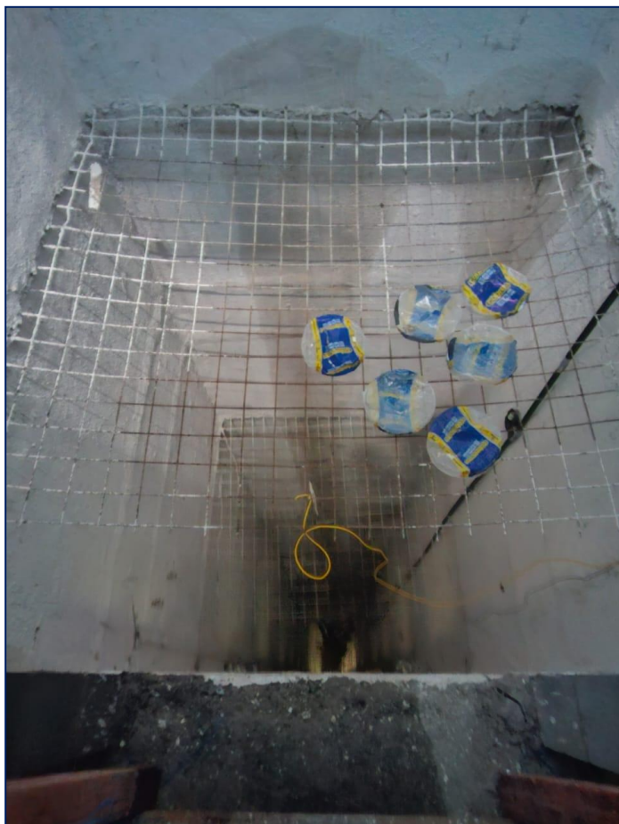
Foto 05 – Caiação de poço de elevador
