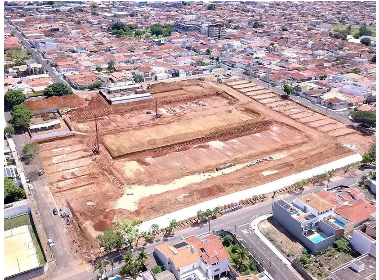
Vista do Empreendimento
