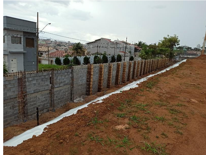
Muro de Divisa
