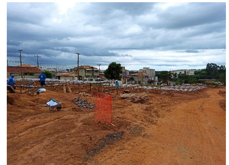
Vista da Obra
