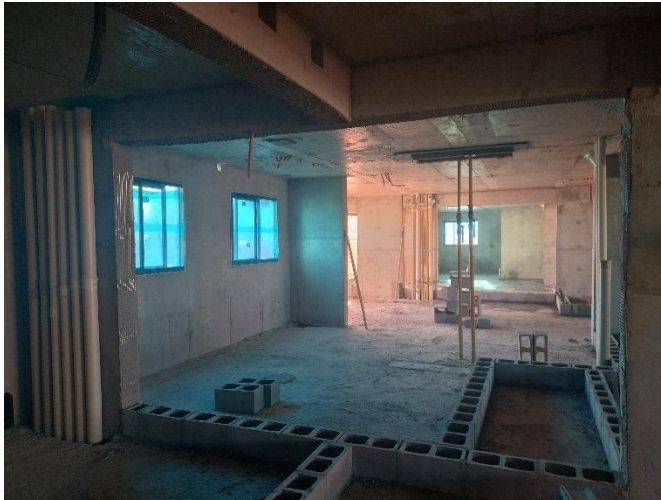
Marcação de Alvenaria – 6° pav
