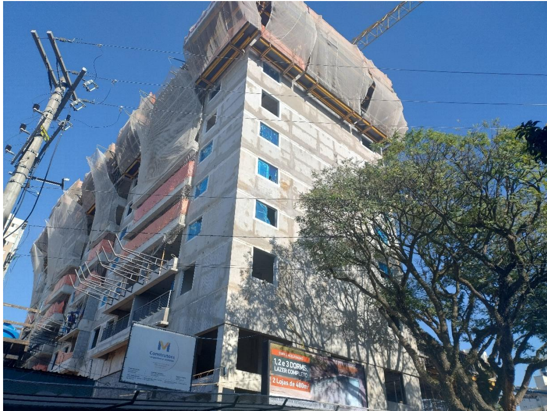
Vista Fachada Lateral
