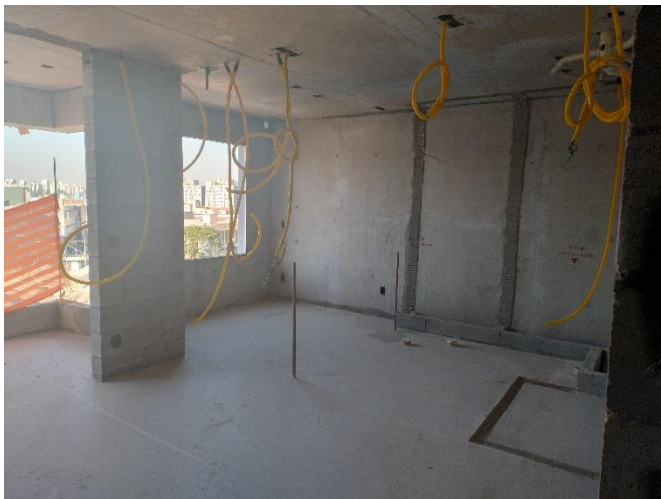
Embutidos em Alvenaria – 3° pav
