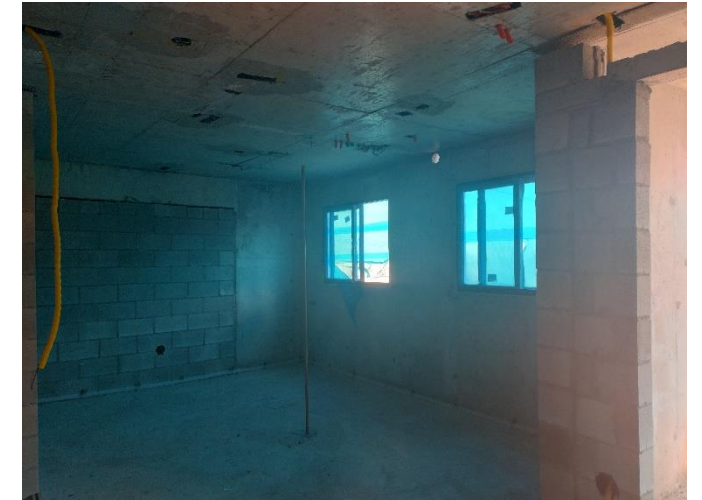
Janela de Alumínio – 4° Pav
