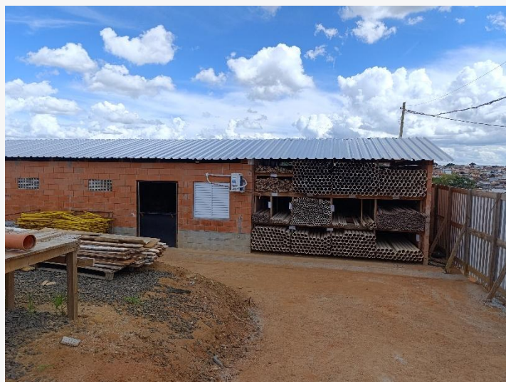
Estoque de Material (Tubos e Conexões)
