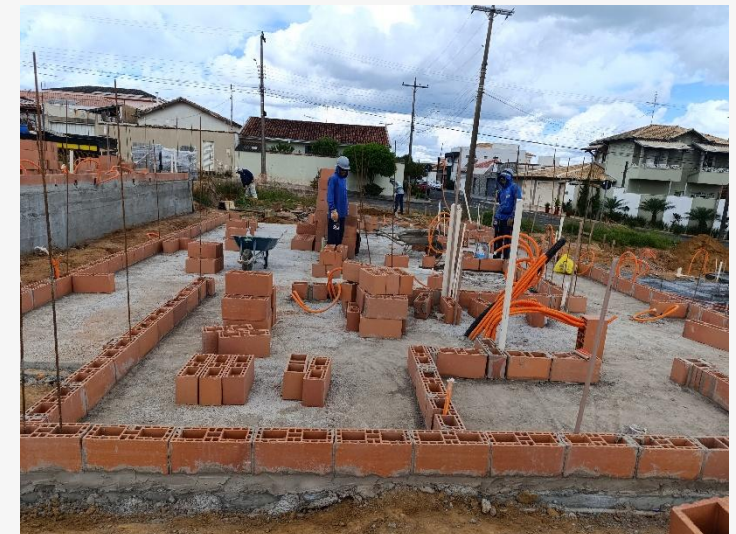
Marcação de Alvenaria
