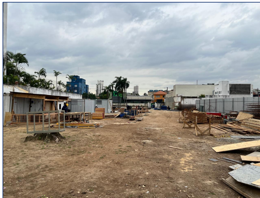
Foto 2 – Visão geral terreno
