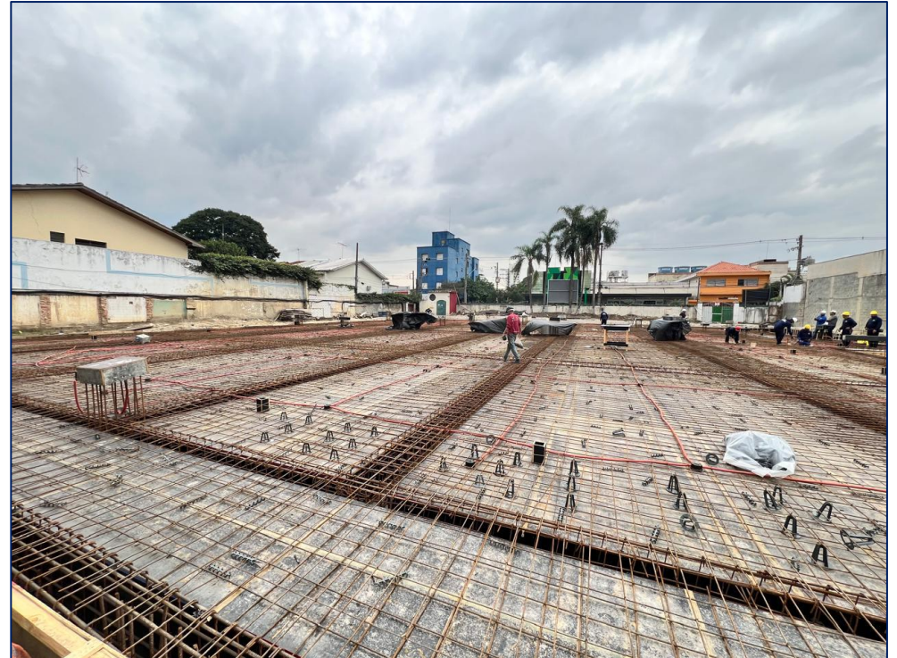
Foto 6 - Visão geral da laje
