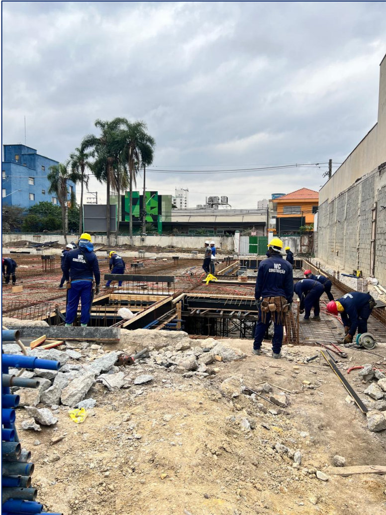
Foto 5 - Visão geral da laje – trecho poço do elevador e rampa
