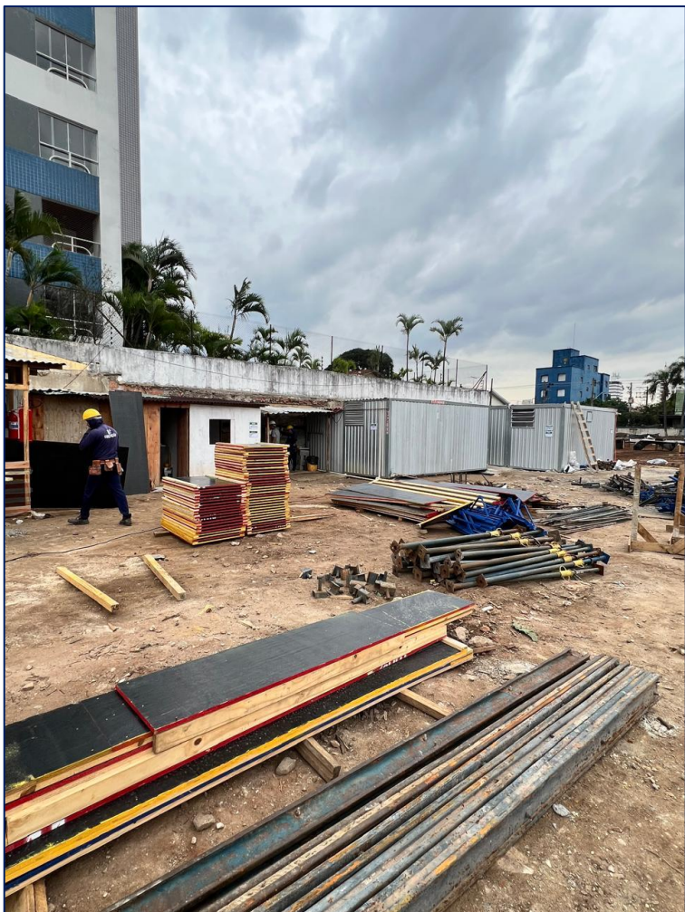
Foto 3 – Montagem de forma
