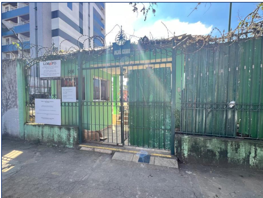
Foto 1 – Visão geral da obra
