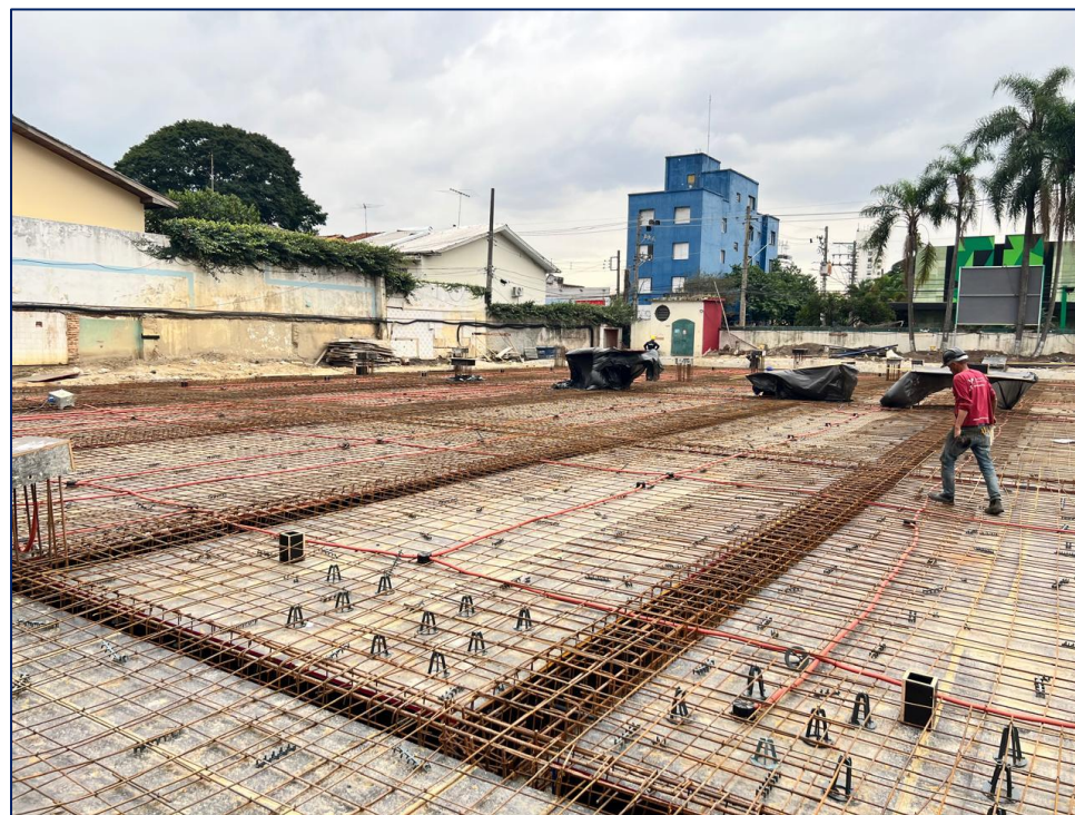
Foto 4 – Armação da laje do Térreo
