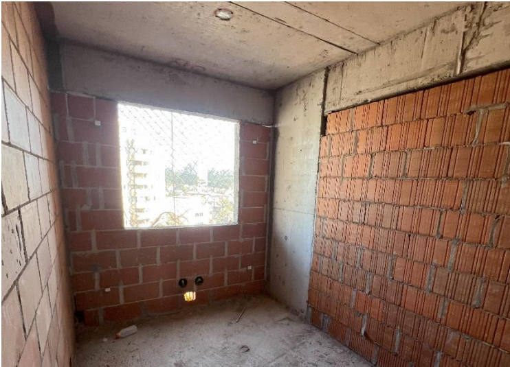
Alvenaria/ Vedação – 8º Pav
