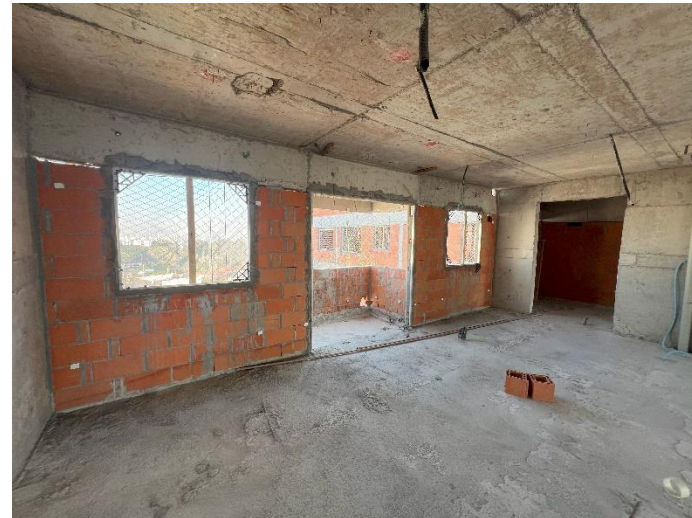
Alvenaria/ Vedação – 16º Pav
