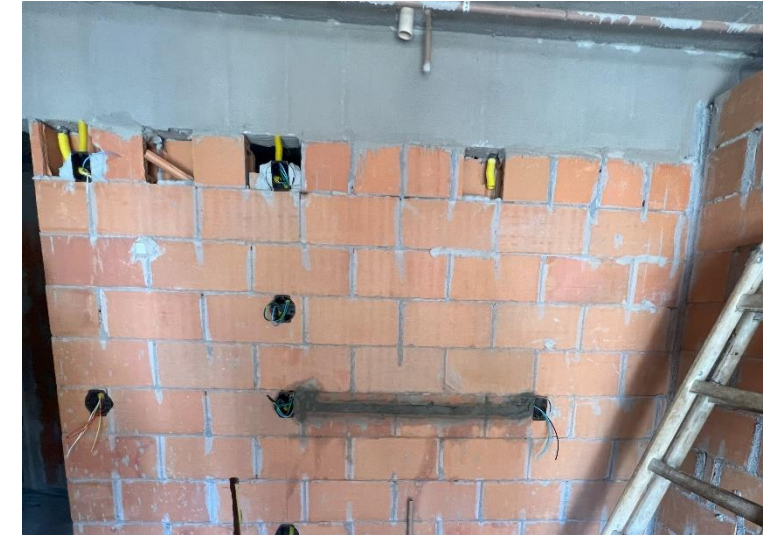
Cabos de Instalações – 6º Pav
