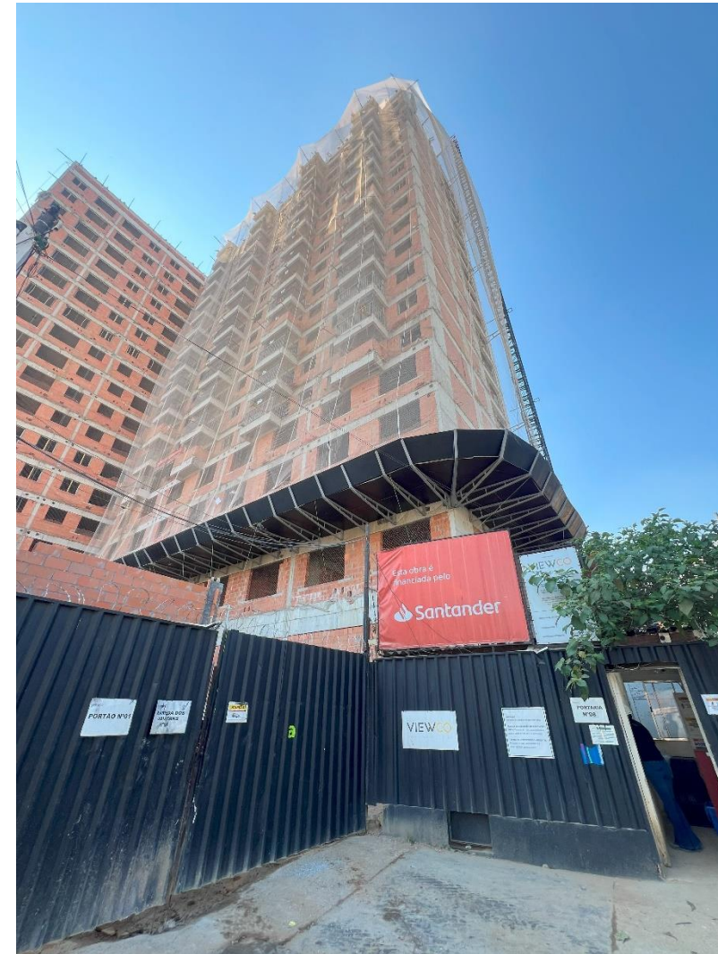
Vista da Fachada Lateral
