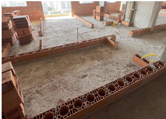
Marcação de Alvenaria – 13º Pav
