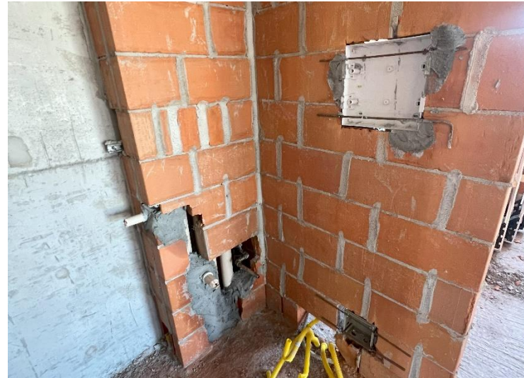
Fundo de Quadro – 7º Pav
