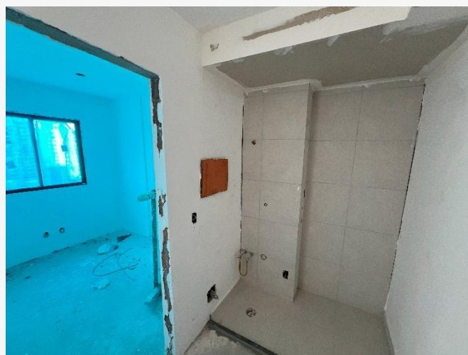
Revestimento Cerâmico – 12º Pav.
