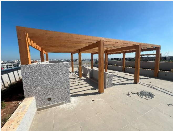
Pintura (Textura) – Cobertura
