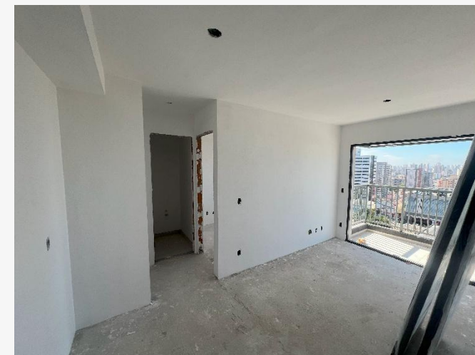
Pintura Interna – 15º Pav.
