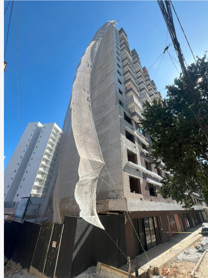
Vista Fachada Lateral
