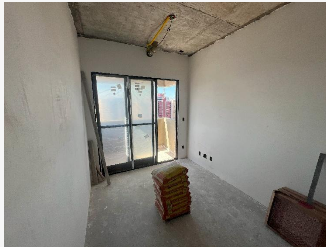
Esquadria de Alumínio – 17º Pav.
