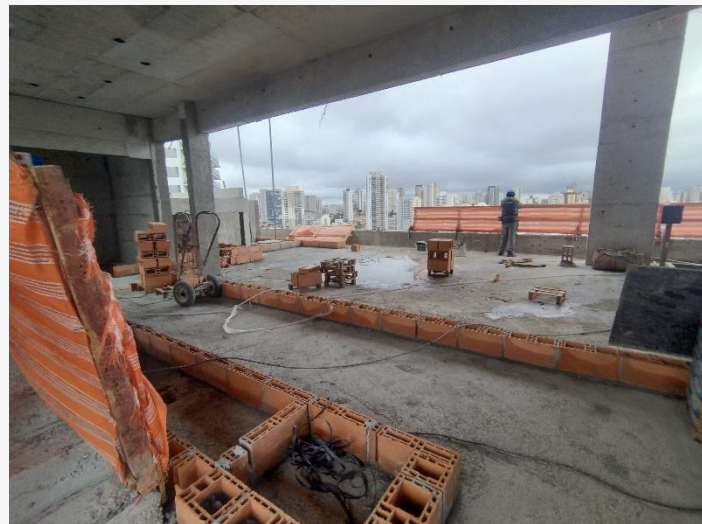
Marcação Alvenaria - 25º Pav.
