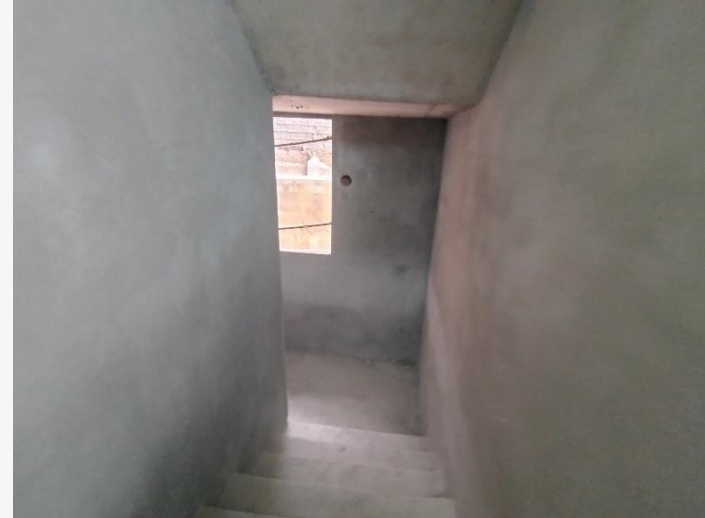
Reboco Interno – 02º Pav.
