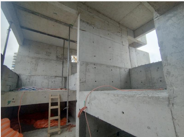
Vista Estrutura - Barrilete.
