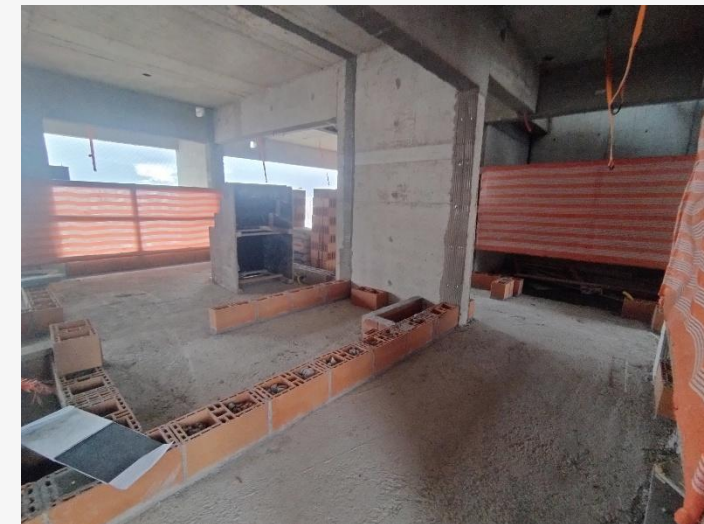
Marcação Alvenaria - 24º Pav.
