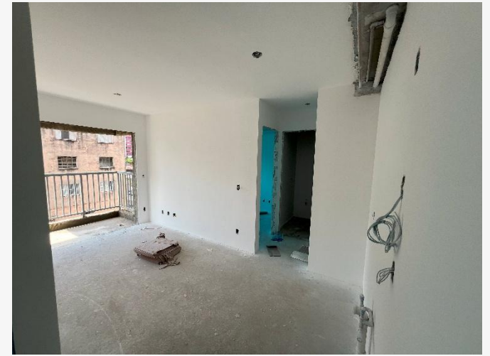
Pintura Interna – 6º Pav.
