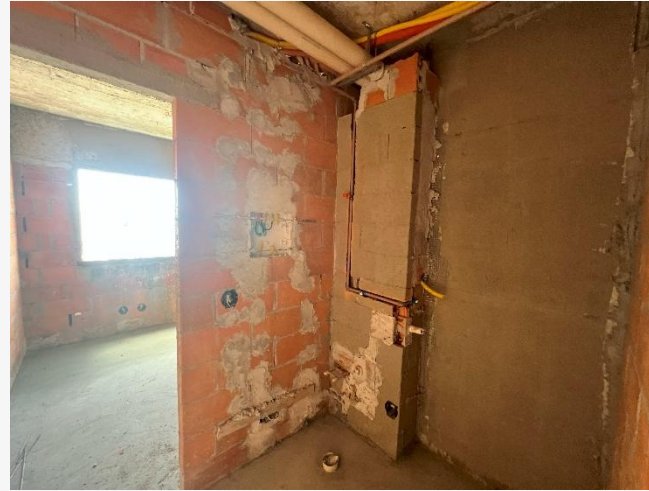
Distribuição Hidráulica – 17º Pav.
