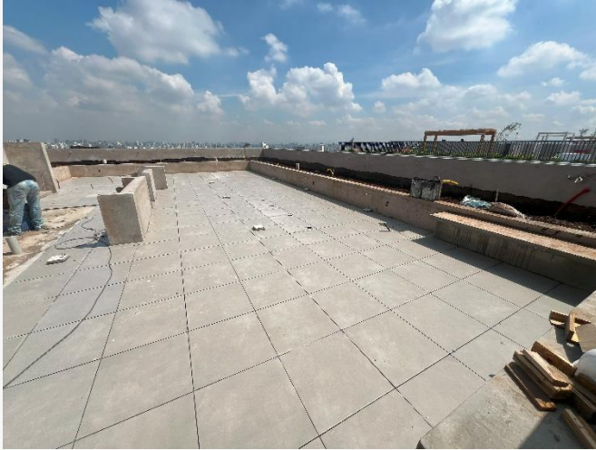
Revestimento Externo – Cobertura
