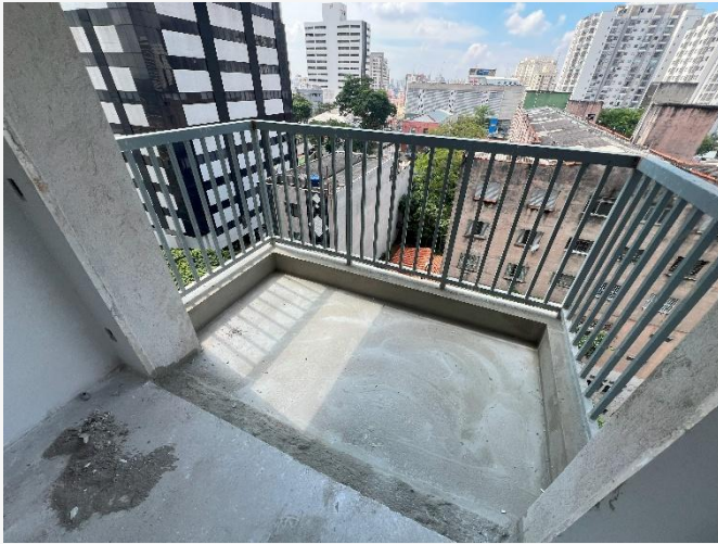
Impermeabilização – 9º Pav.
