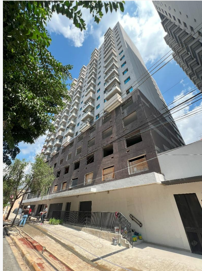
Vista Fachada Lateral
