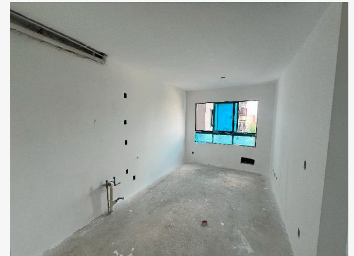
Janela de Alumínio – 10º Pav.
