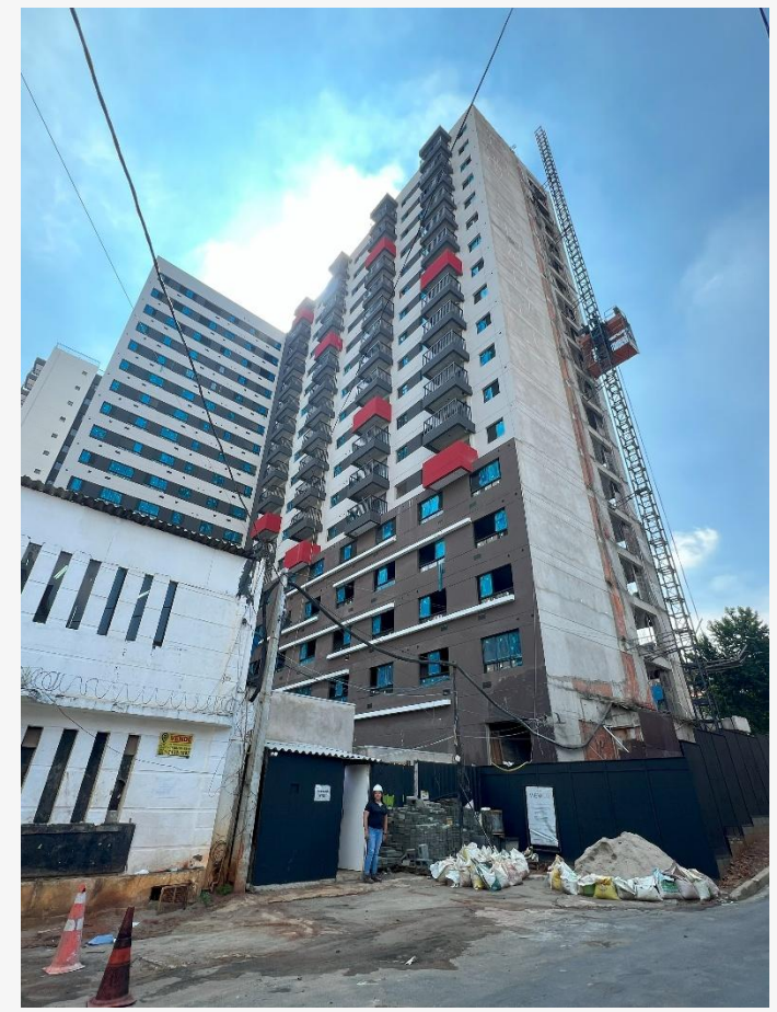
Vista Fachada Lateral
