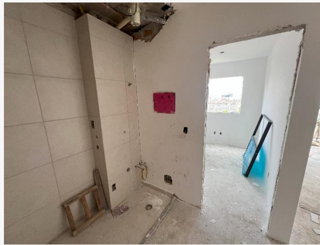
Revestimento Cerâmico – 11º Pav.
