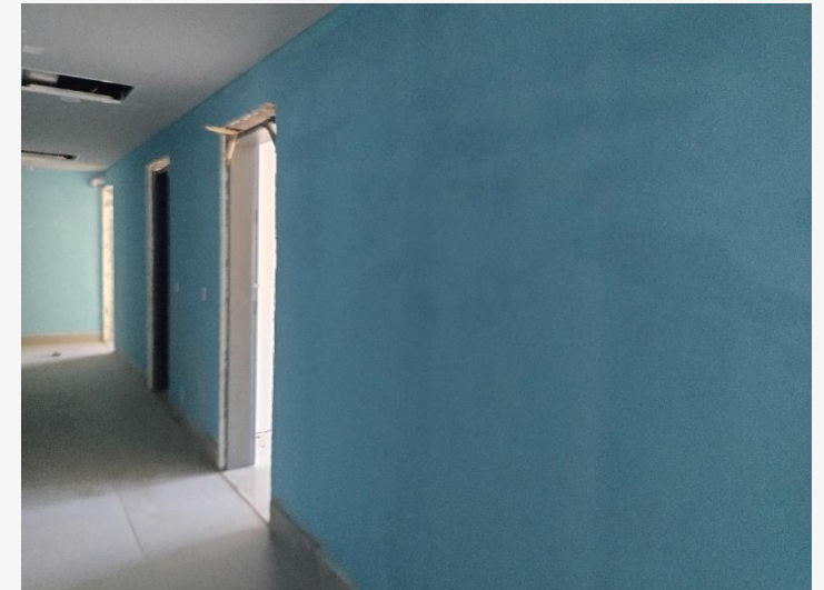
Pintura Interna – 16° Pav.
