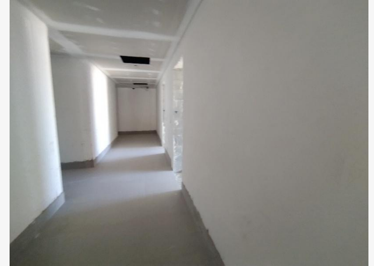
Pintura Interna – 23° Pav.
