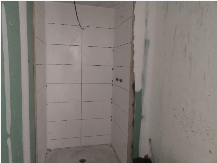
Revestimento Cerâmico – 22° Pav.
