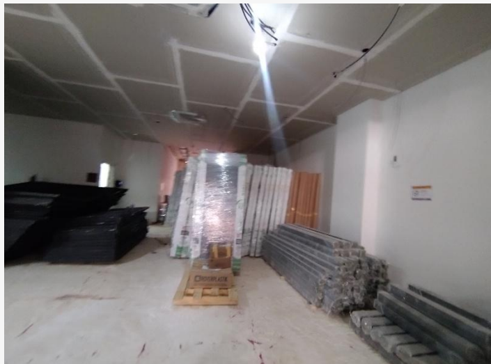
Gesso Acartonado – 06º Pav.
