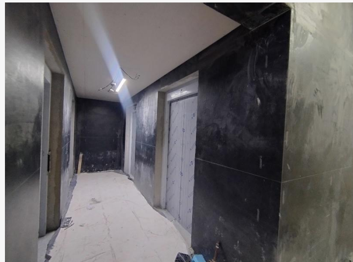
Revestimento Cerâmico – 6º Pav.
