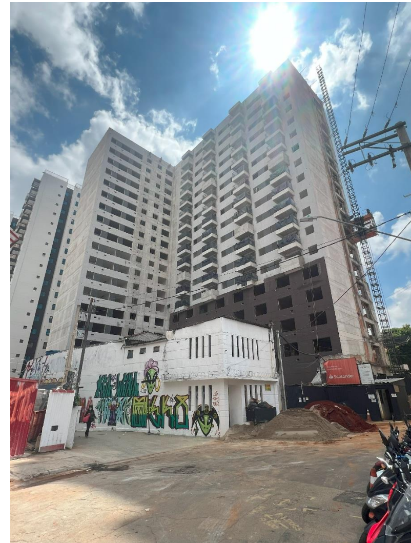
Pintura da Fachada – Foto dia 30/Out/2024
