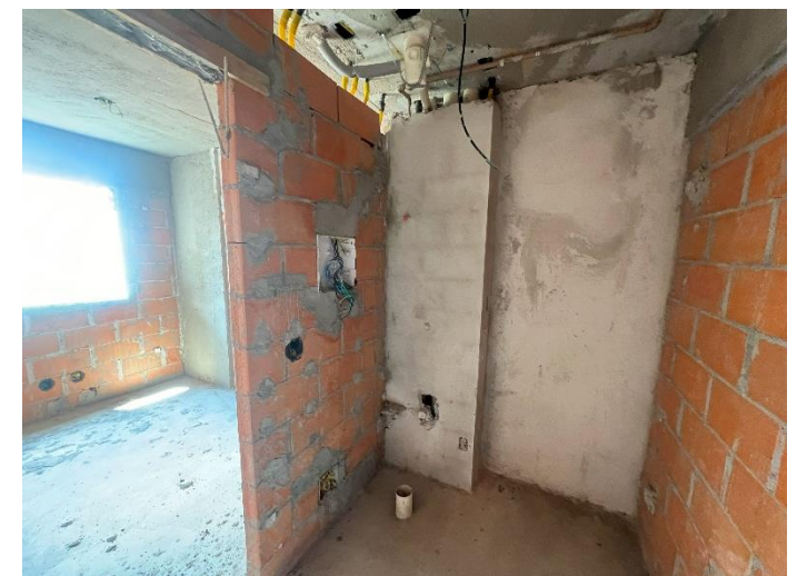
Reboco Interno – 11º Pav
