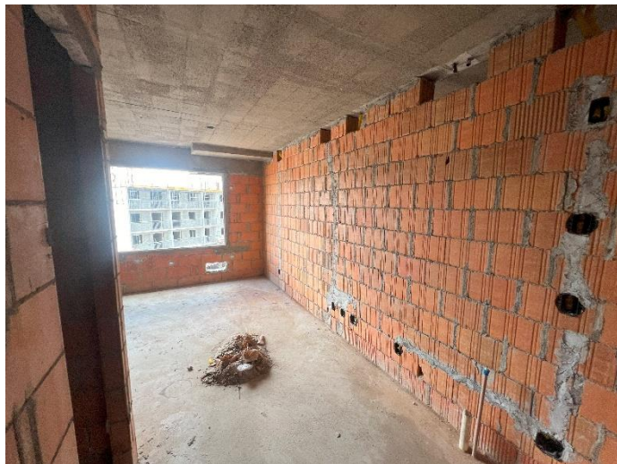
Embutido em Alvenaria – 4º Pav
