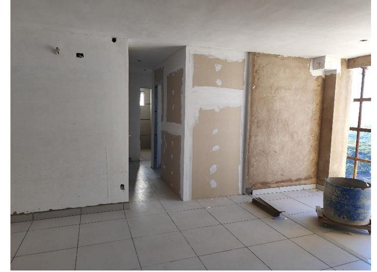
Parede Drywall – 11º pav
