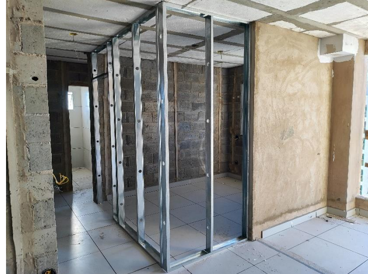
Parede Drywall - 12º pav
