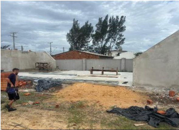
07 Execução - Quadra de Padel.
