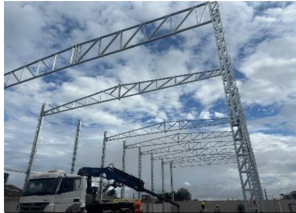
08 Execução da Estrutura Metálica - Quadra de Tênis.
