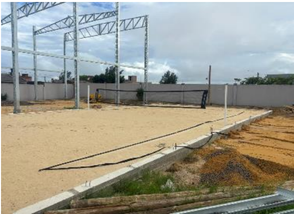
09 Execução da Quadra de Beach Tênis.
