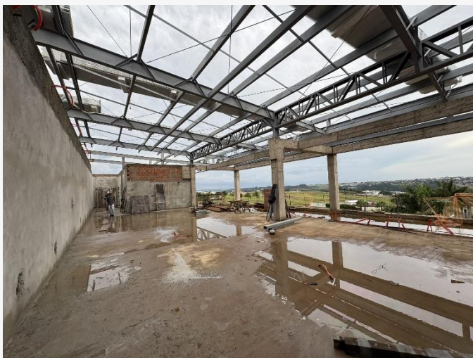
Estrutura Cobertura Metálica – 2º Pav.
