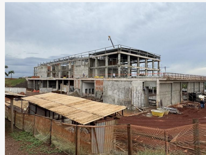
Vista da Obra
