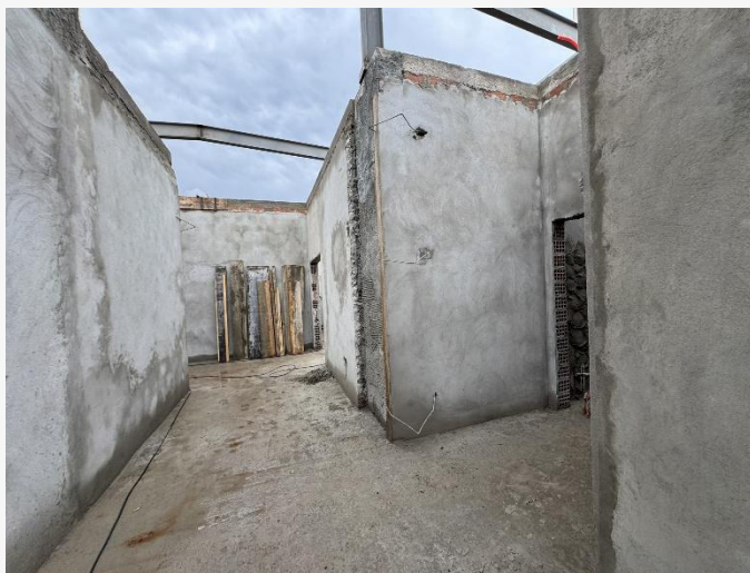
Emboço Interno – 2º Pav.
