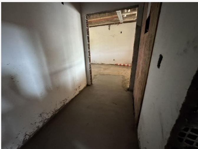
Contrapiso – 1º Pav.
