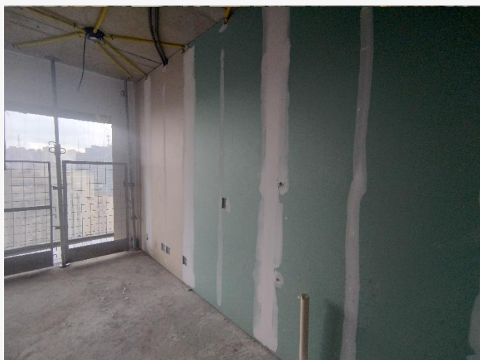
Alvenaria Drywall – 18º Pav
