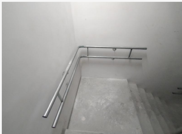
Instalação de Corrimão – 8º Pav
