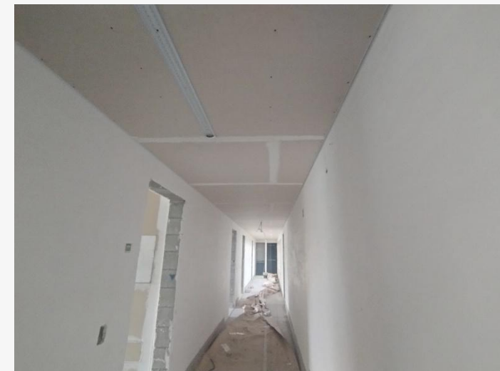
Forro de Gesso – 13º Pav
