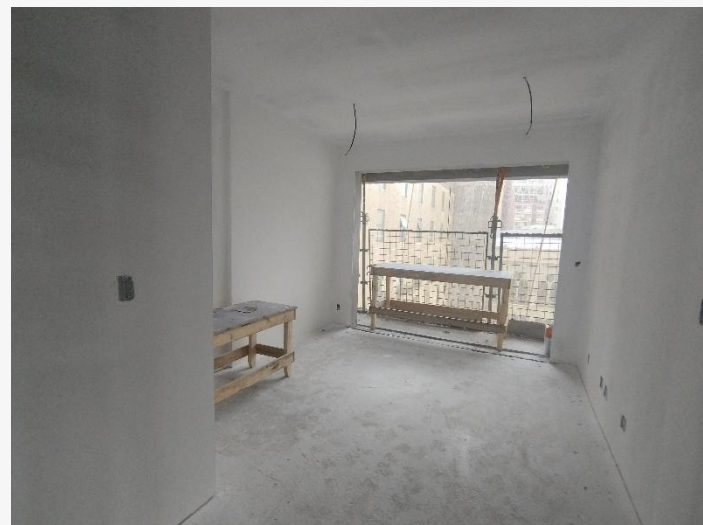
Pintura Interna – 6º Pav
