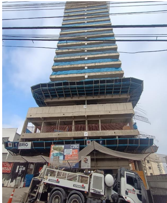
Foto 01 – vista geral frente da obra;
