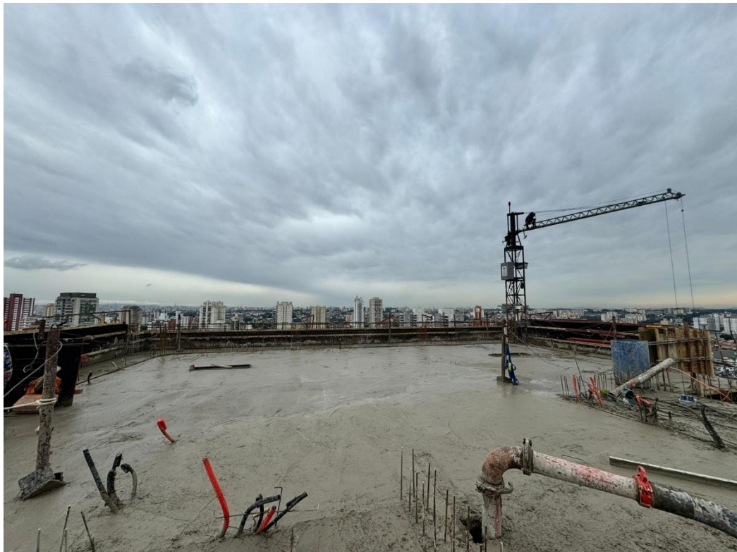
Foto 12 – concretagem 21º pav;
