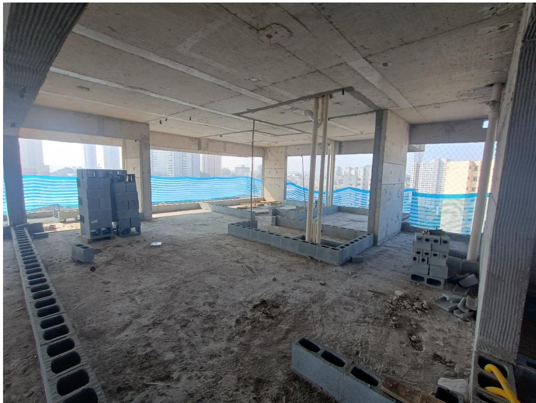
Foto 10 – 9º pavimento– marcação de alvenaria, prumada hidráulica e tubulação seca de elétrica;
