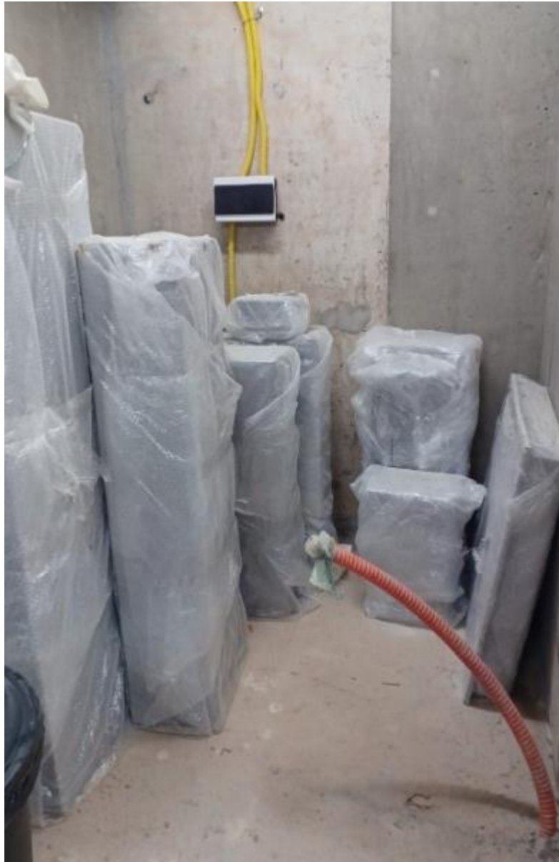
Foto 14 – materiais elétricos para montagem do centro de medição definitivo;
