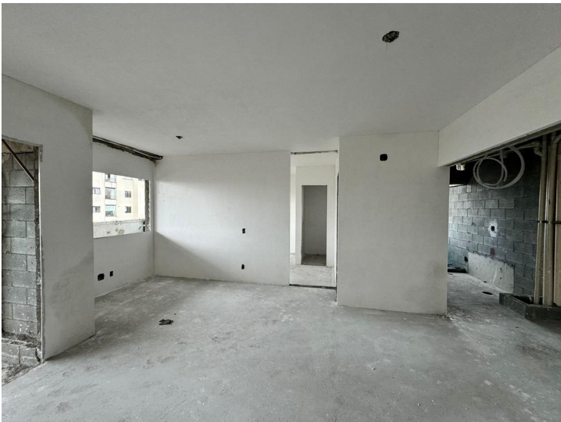
Foto 04 – 3º pavimento – gesso liso e contramarco fixado;
