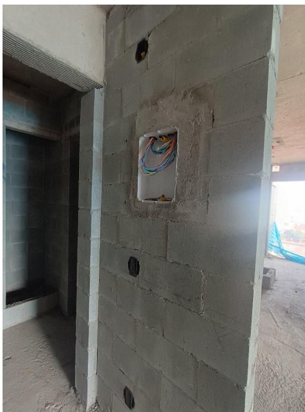
Foto 07 – 6º pavimento– visão geral caixinha ponto elétrico e caixa de distribuição unidade privativa;
