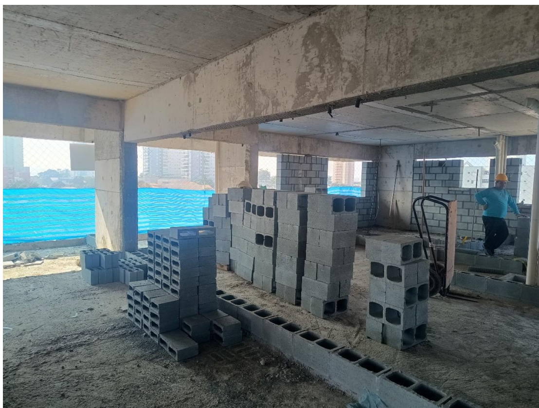
Foto 08 – 7º pavimento– Elevação alvenaria;
