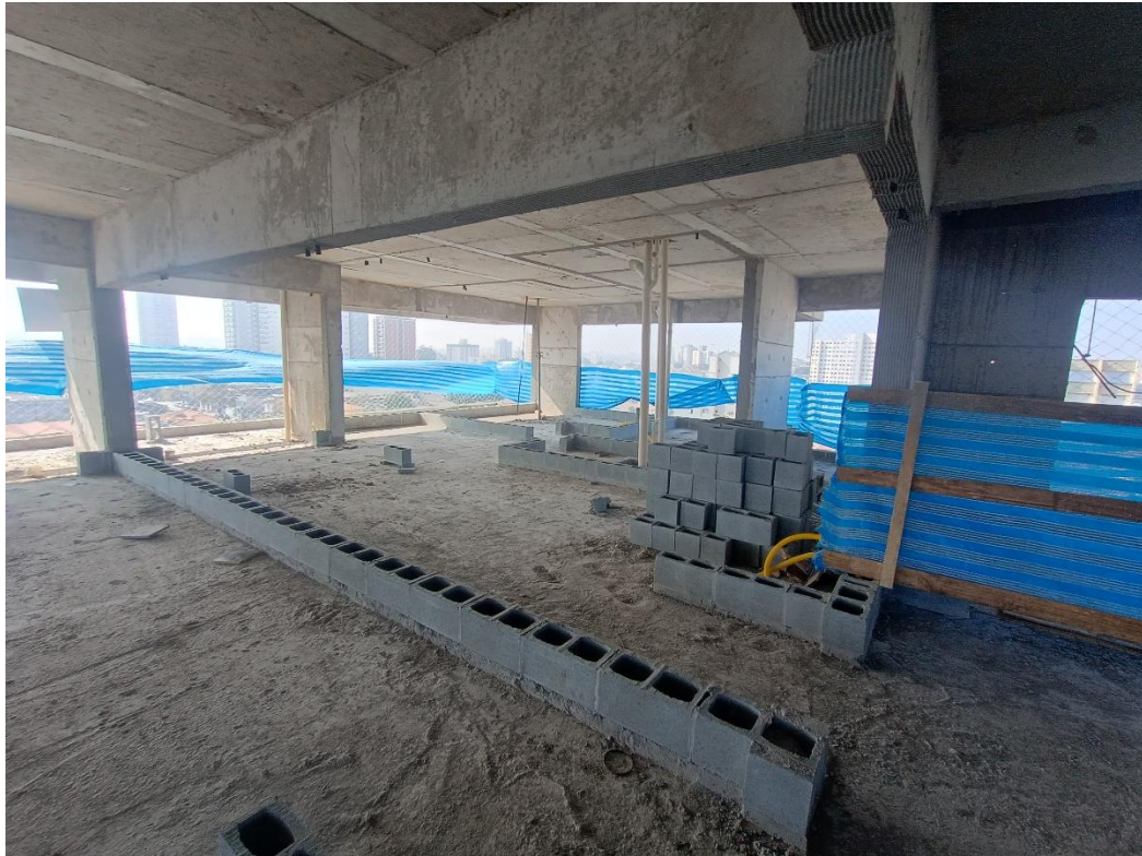
Foto 11 – 10º pavimento– marcação de alvenaria, prumada hidráulica e tubulação seca de elétrica;
