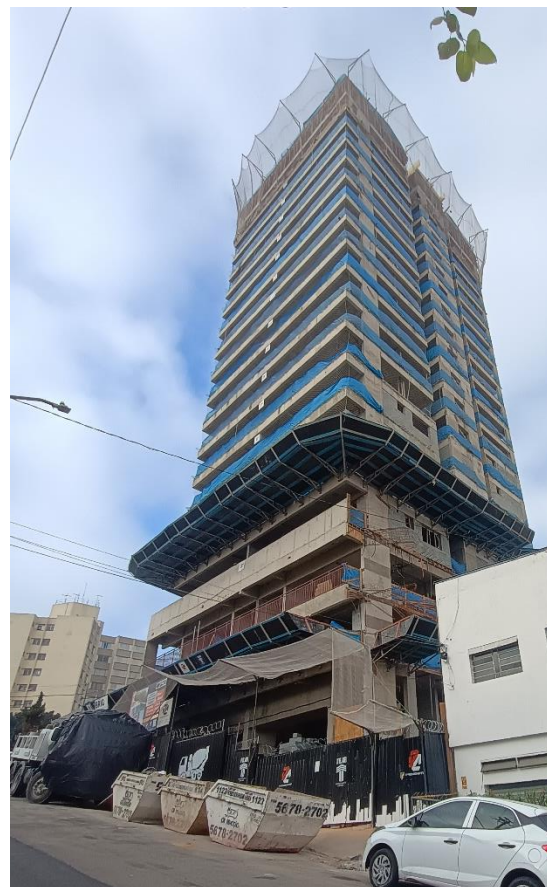
Foto 02 – visão fachada frontal e lateral direita;
