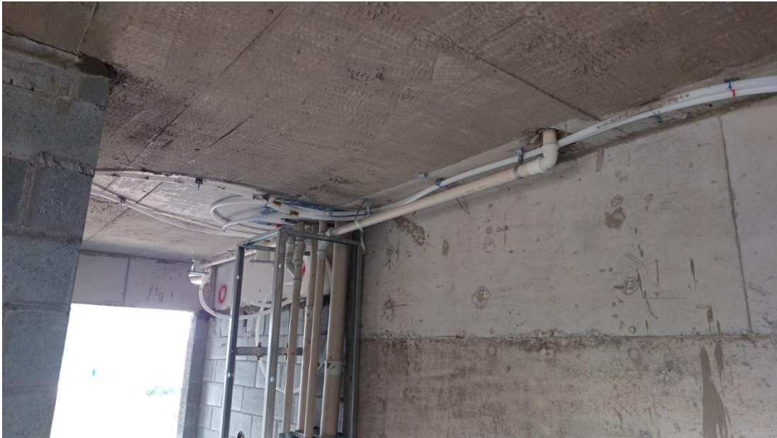
Foto 05 – 3º pavimento- tubulação e distribuição hidráulica;
