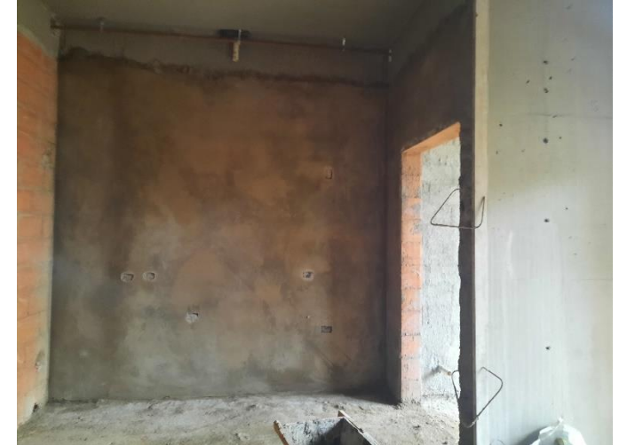
Reboco Interno – 2º Pav
