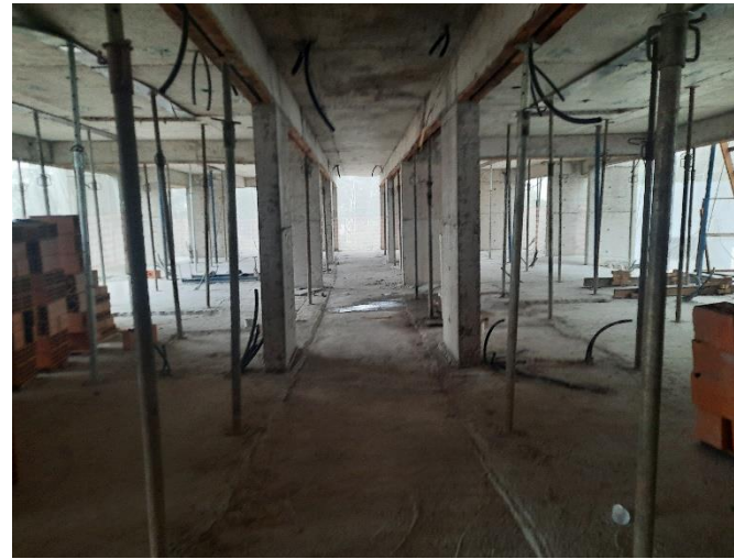
Vista Estrutura – 8º Pav TS
