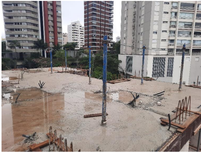
Concretagem de Laje – 10º Pav TS
