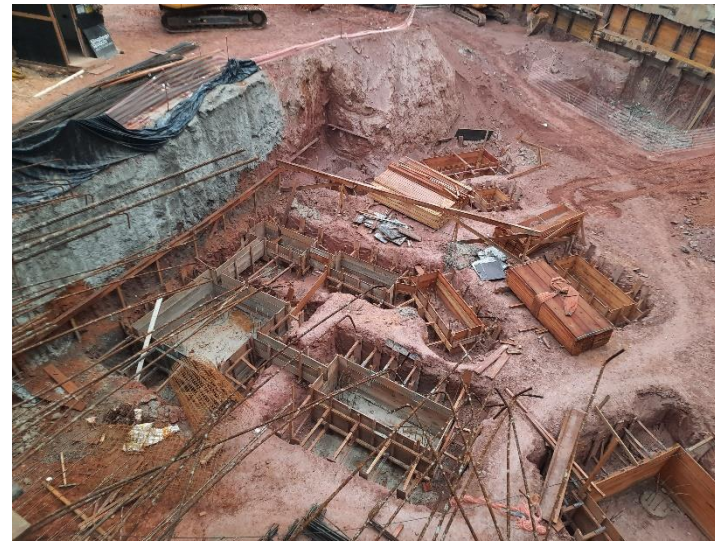
Blocos de Fundação – Torre Onix
