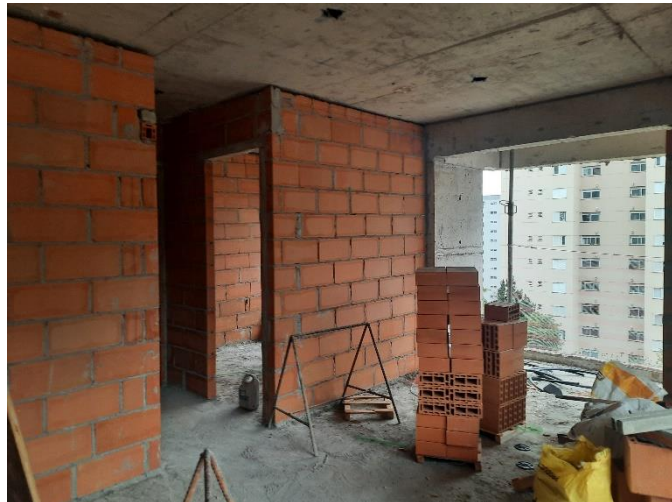
Alvenaria/ Vedação – 5º Pav
