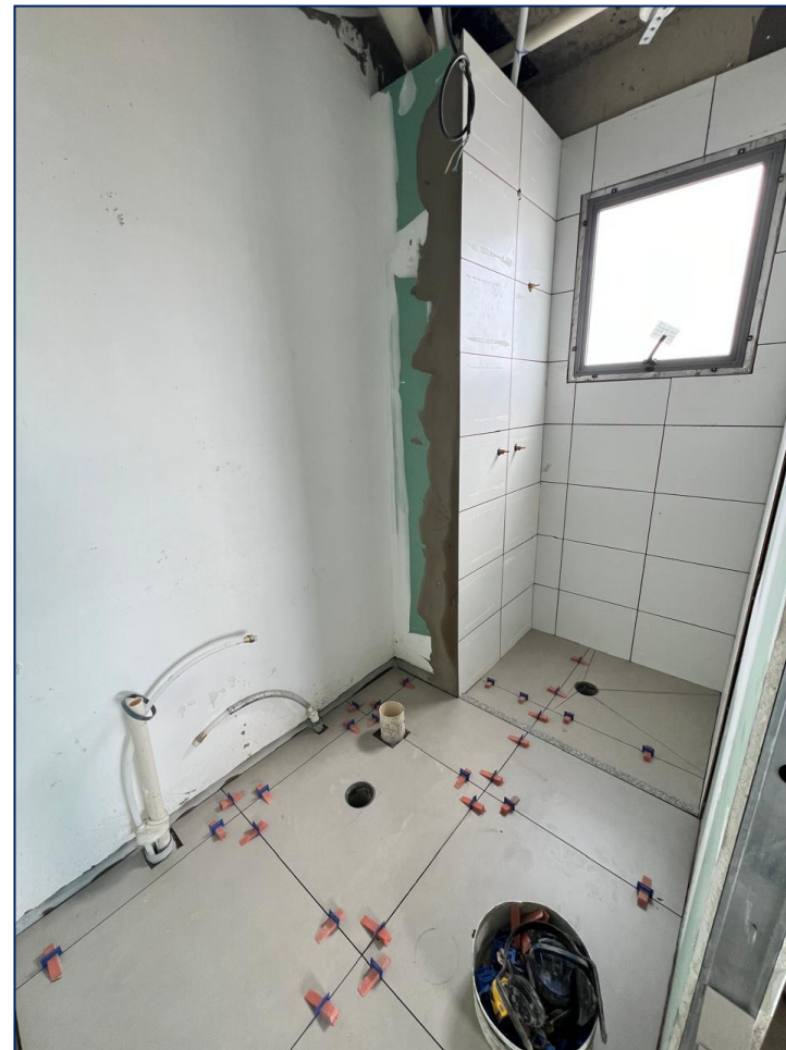
Foto 10 – Cerâmica banho - 17º pav
