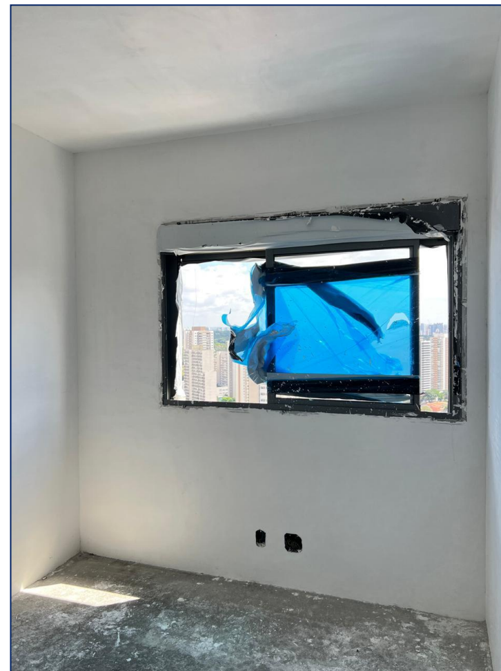
Foto 6 – Caixilhos - 20º pav
