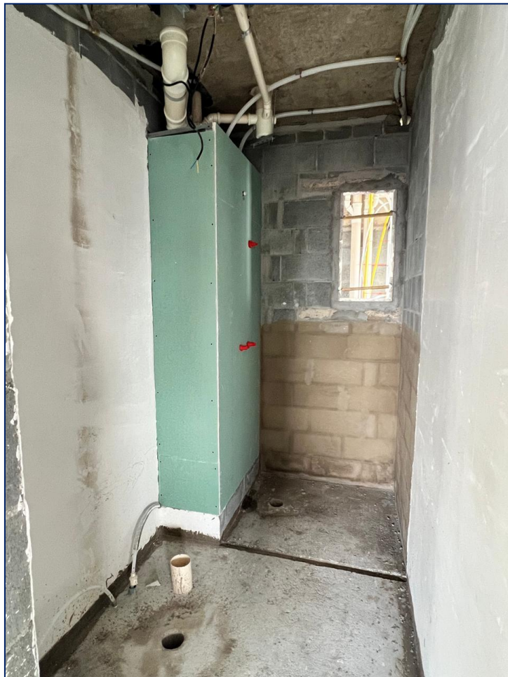
Foto 7 – Impermeabilização - 20º pav
