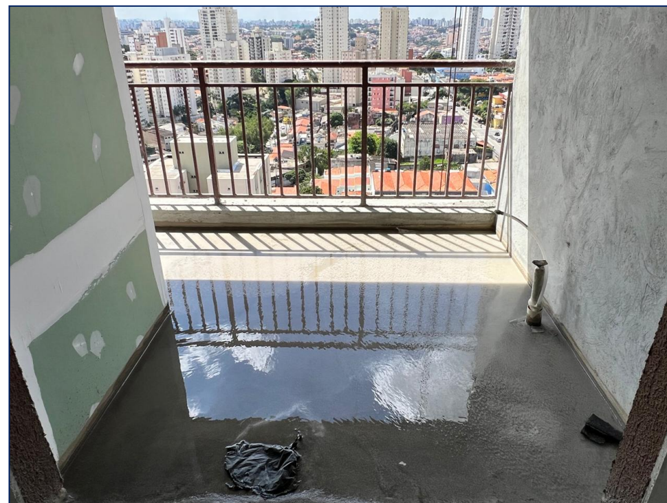
Foto 8 – Teste impermeabilização - 19º pav
