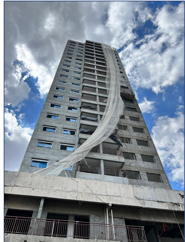
Foto 2 - Visão geral torre
