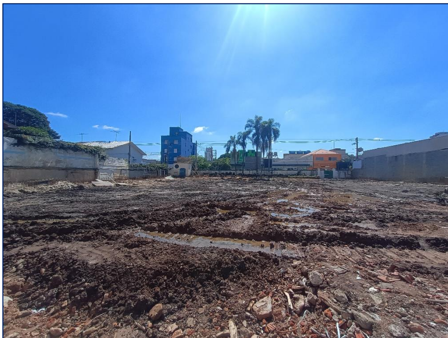
Foto 3 – Visão geral terreno – com parede de diafragma
