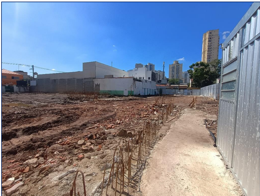
Foto 5 - Visão geral terreno
