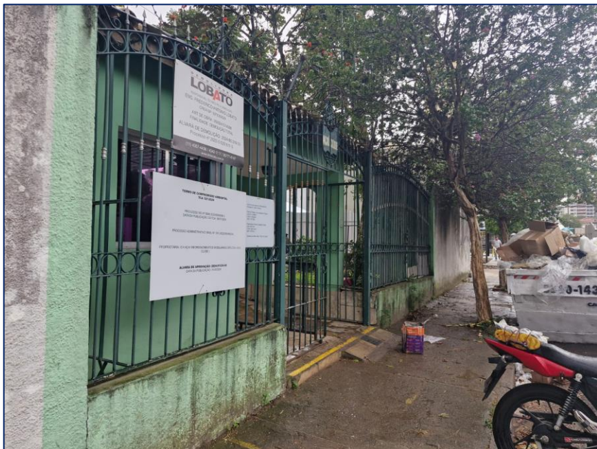
Foto 1 – Visão geral frente obra
