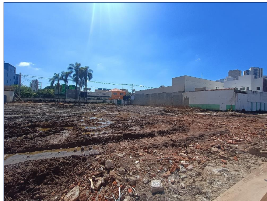
Foto 4 – Visão geral terreno – com parede de diafragma
