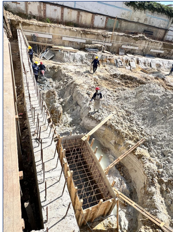
Foto 6 – Visão geral terreno – execução de fundação
