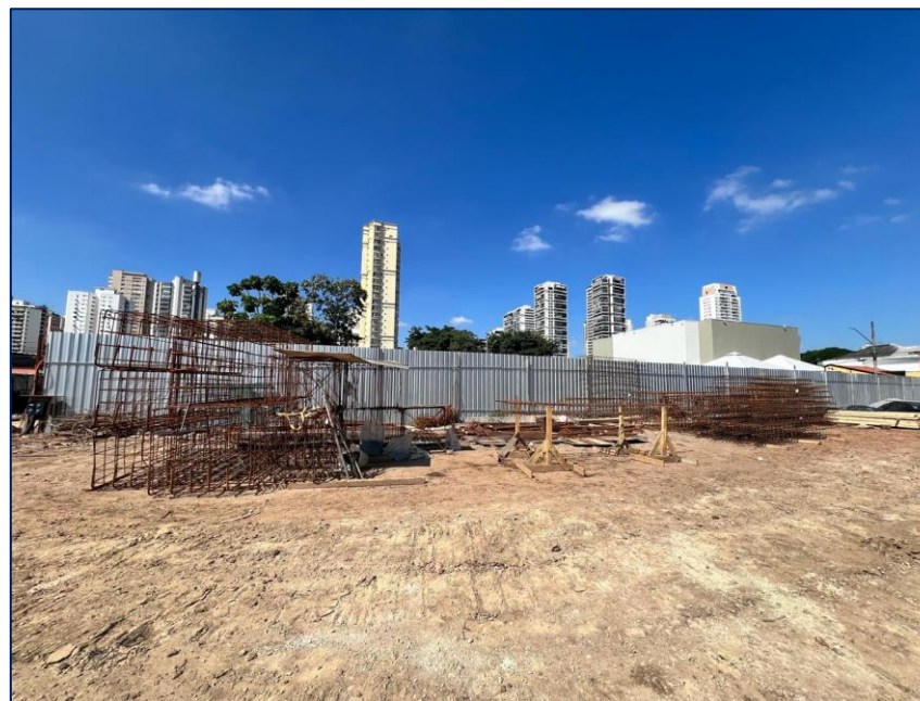
Foto 2 – Visão geral terreno
