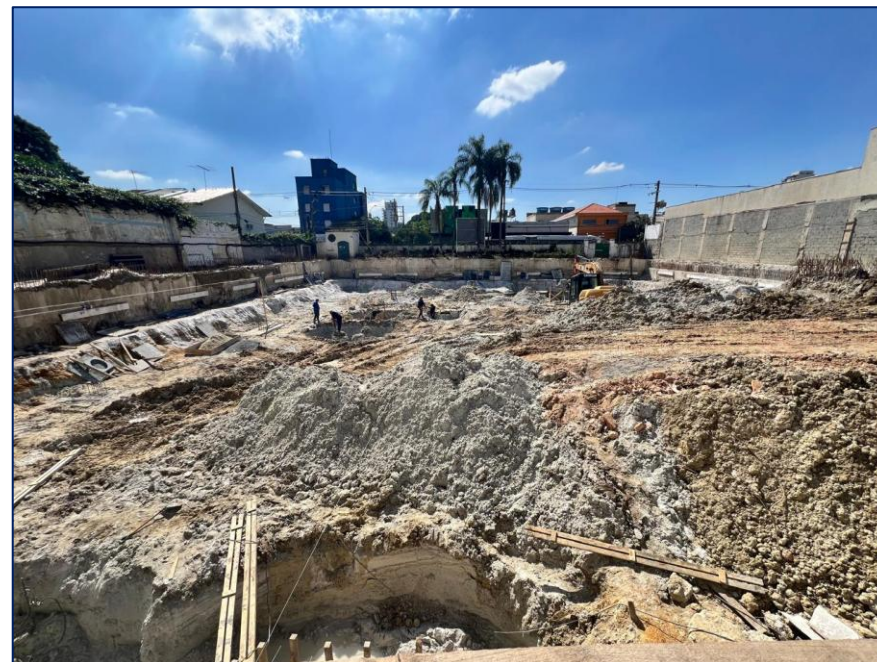
Foto 4 – Visão geral terreno – escavação
