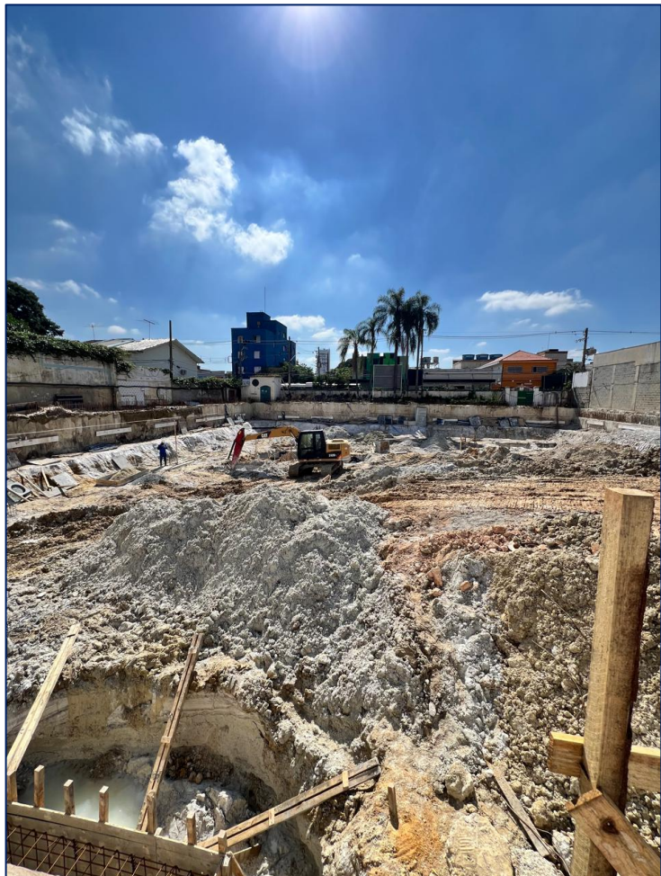
Foto 5 - Visão geral terreno – execução de fundação
