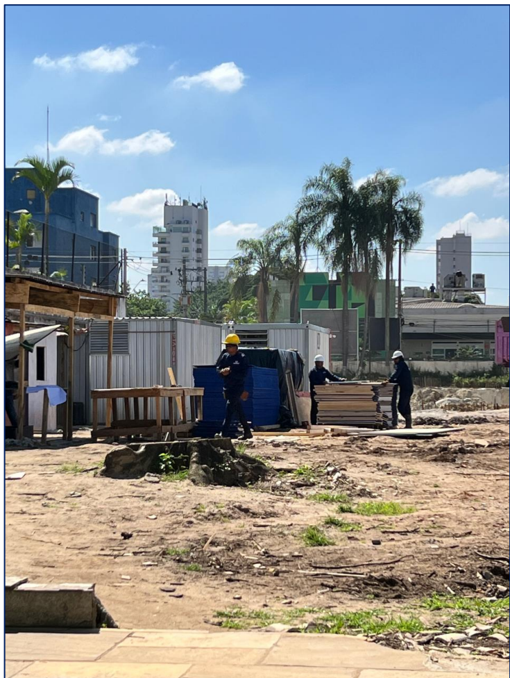
Foto 3 – Visão geral terreno
