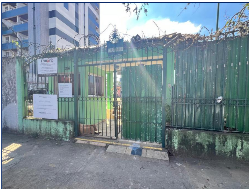
Foto 1 – Visão geral frente obra
