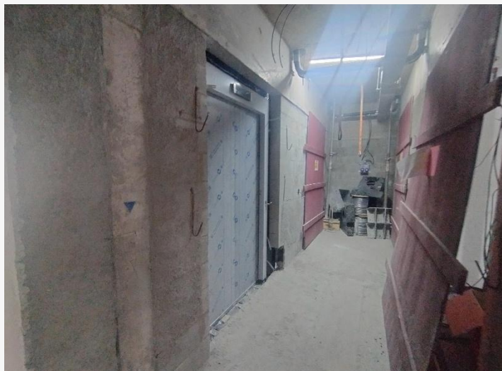
Instalação de Elevador – 24º Pav.
