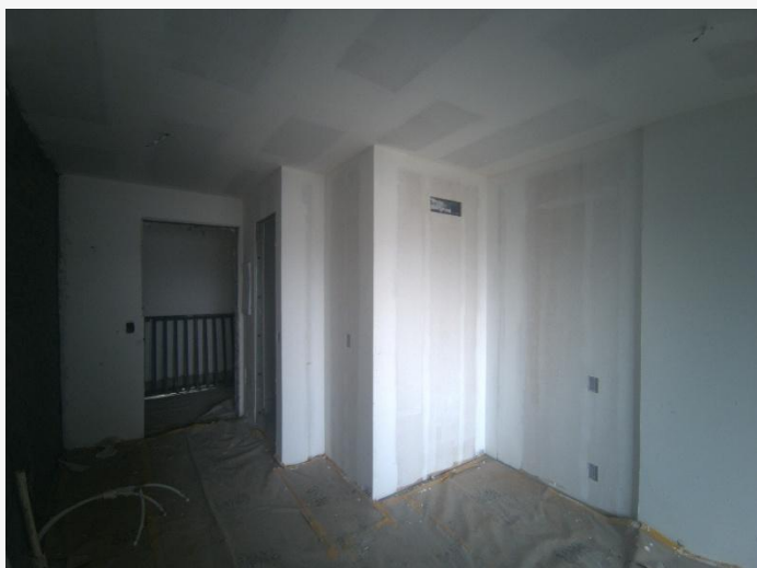
Pintura Interna – 16º Pav.
