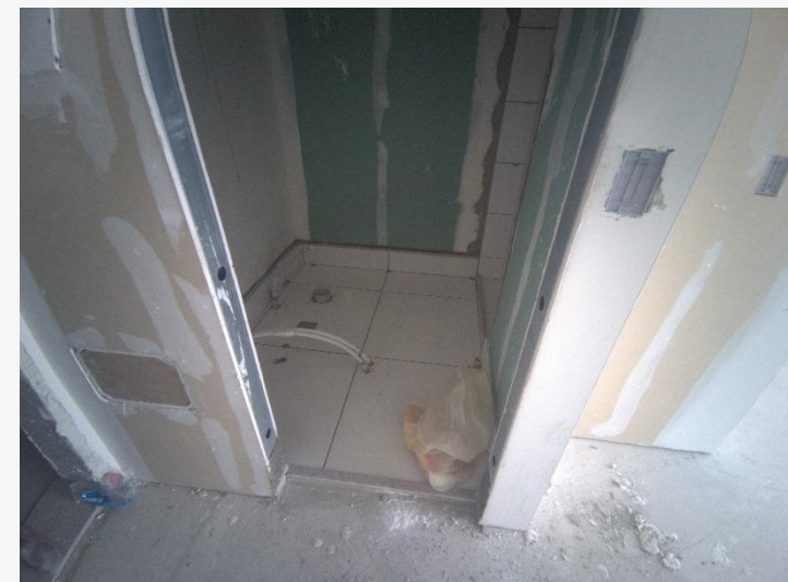
Piso Cerâmico – 19º Pav.
