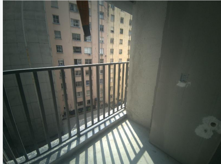
Gradil – 6º Pav.
