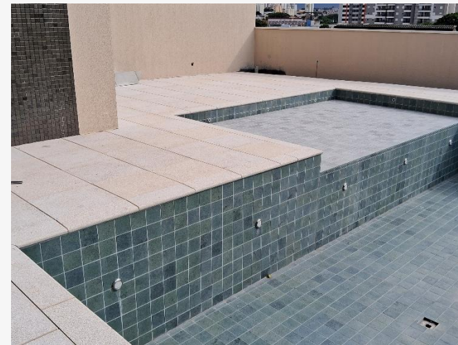
Revestimento da Piscina.
