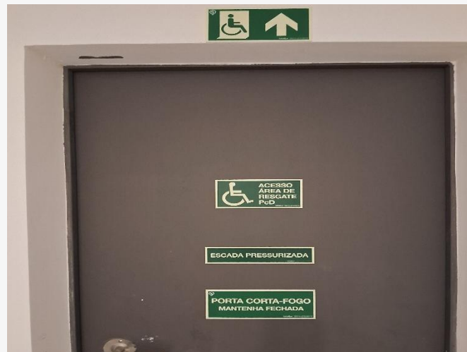
Sinalização – 24º Pav.
