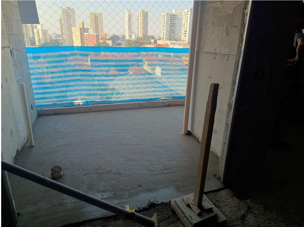
Foto 05 – 7º pavimento- contrapiso;
