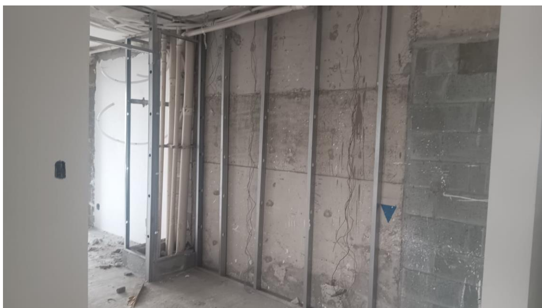
Foto 04 – 3º pavimento – guias drywall;
