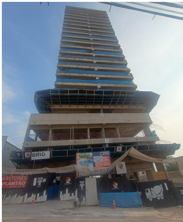
Foto 01 – vista geral frente da obra;
