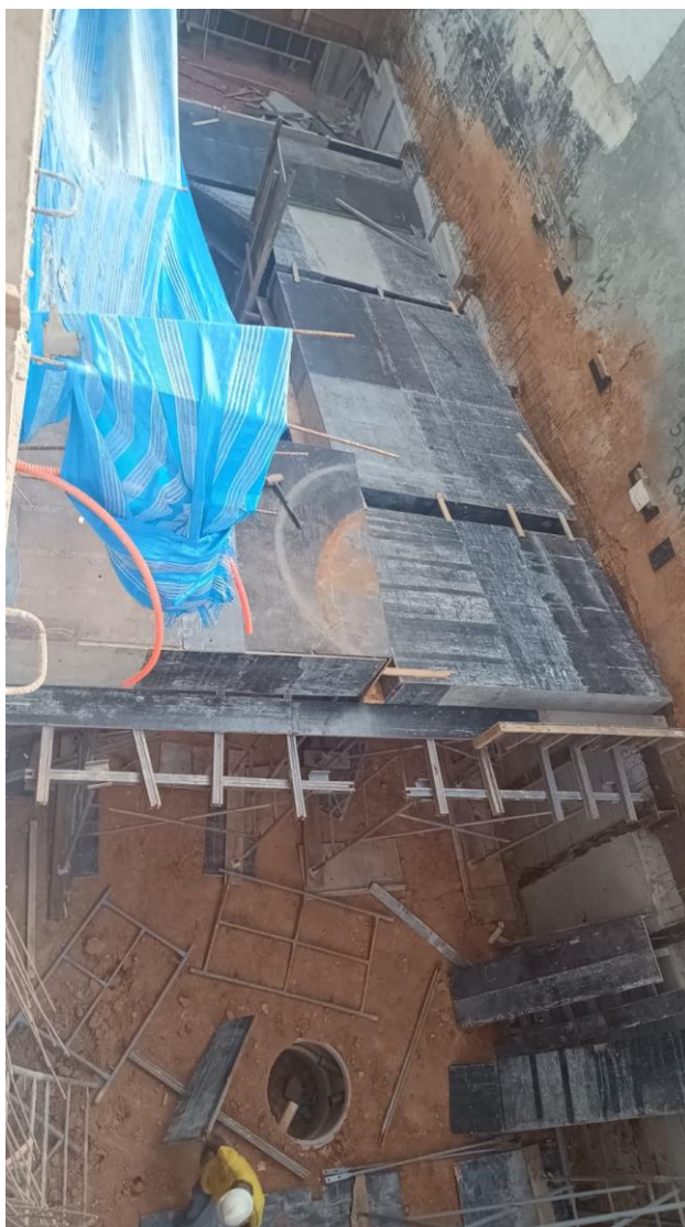
Foto 03 – Em execução forma para concretagem da rampa de acesso subsolo - periferia;
