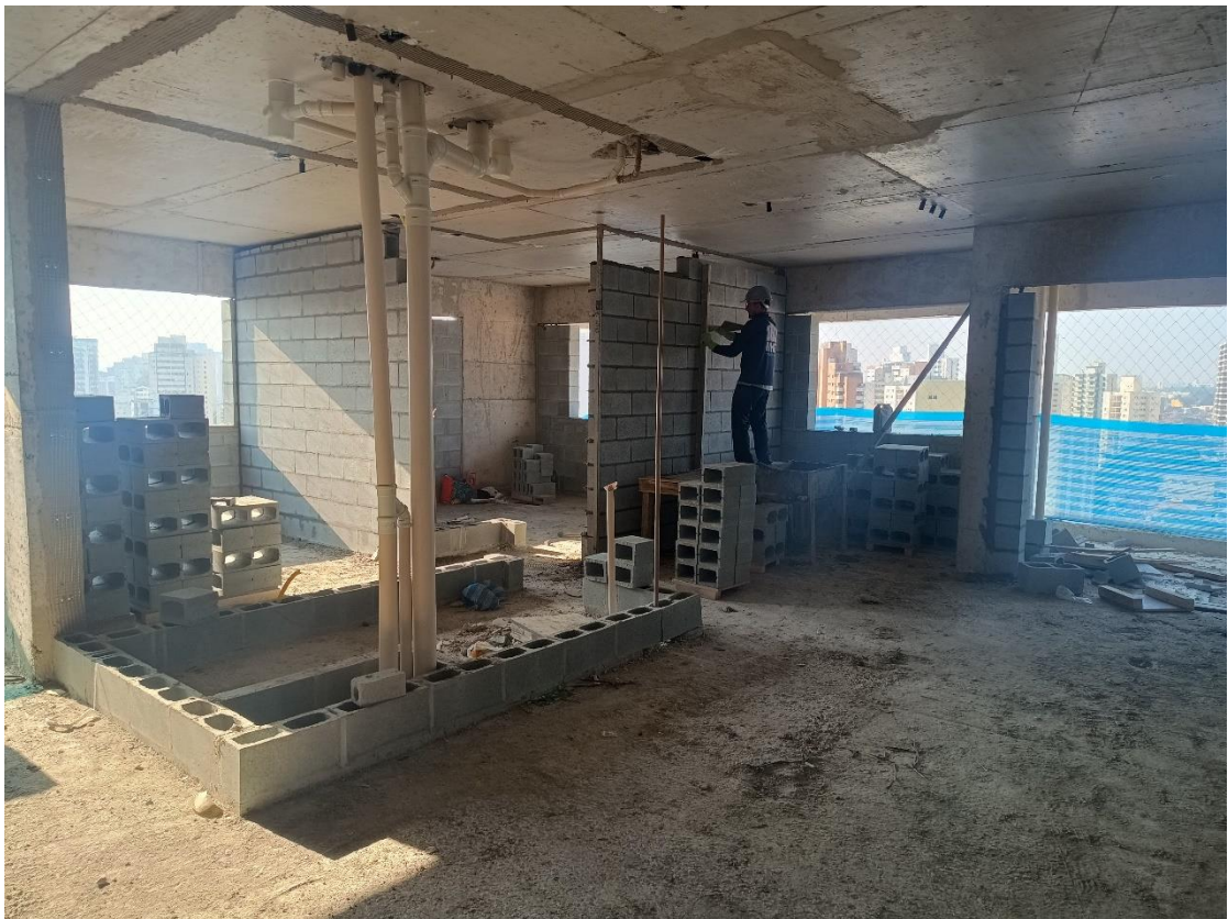
Foto 08 – 12º pavimento– Elevação alvenaria;
