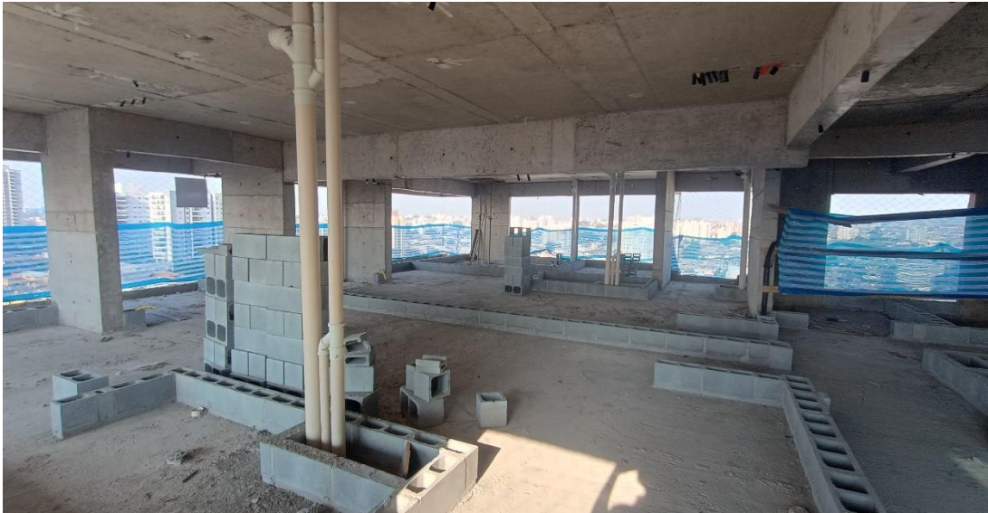
Foto 09 – 14º pavimento– Elevação de alvenaria, tubulação seca de elétrica e prumada hidráulica;
