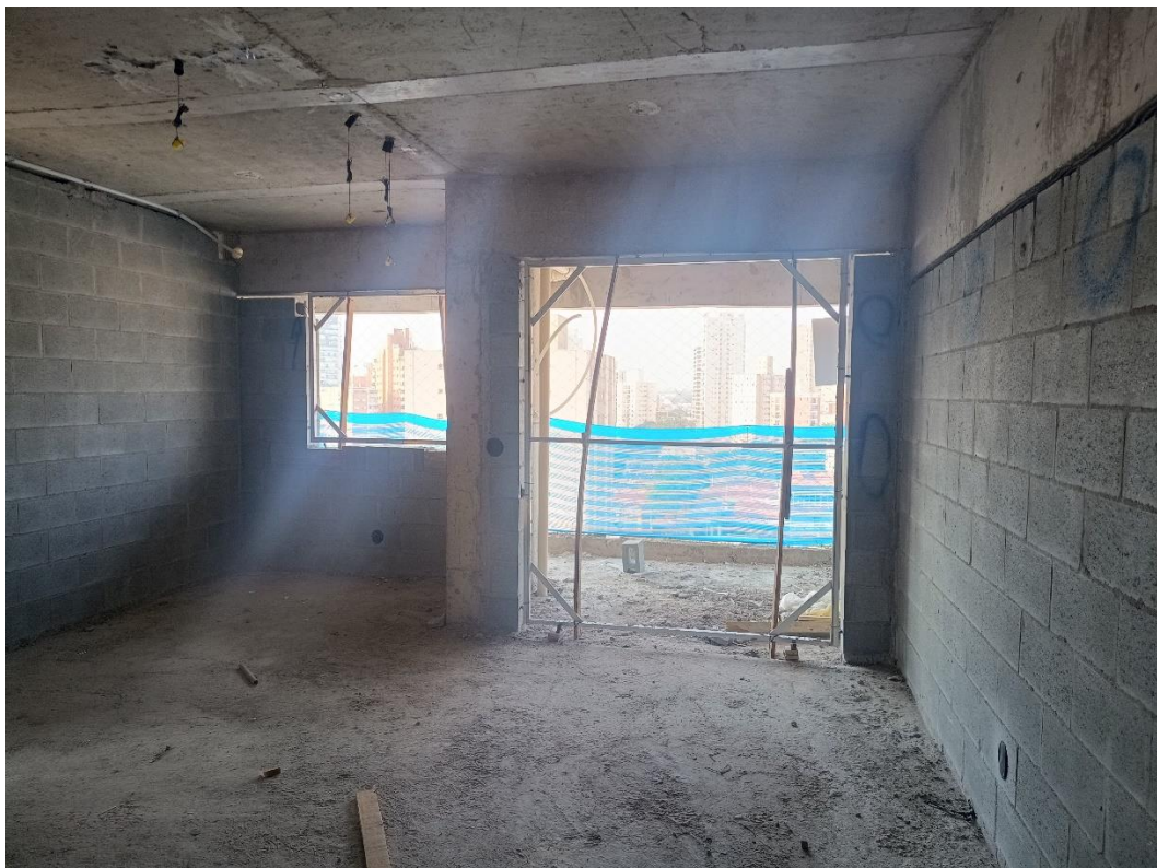
Foto 06 – 9º pavimento- contramarco instalado;
