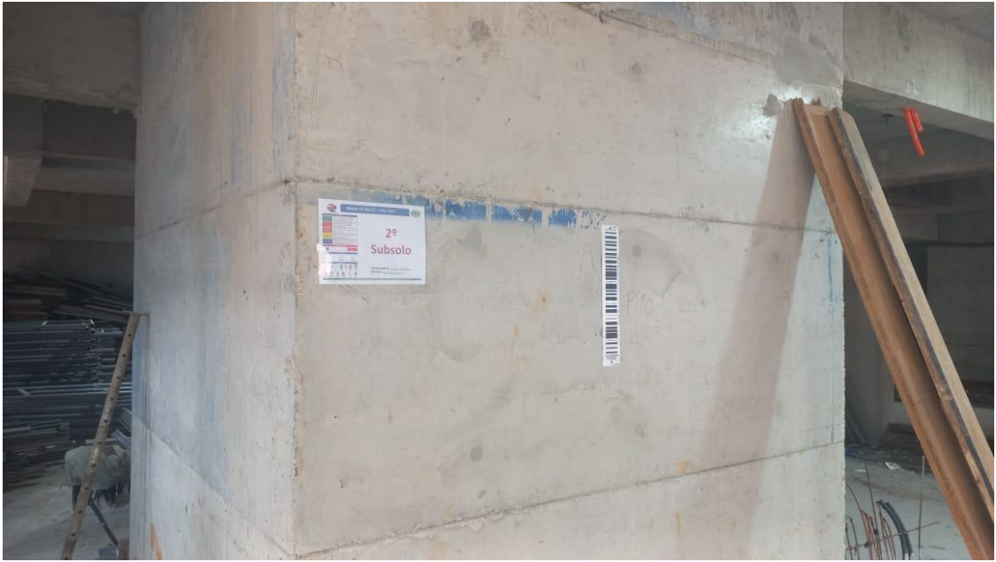
Foto 05 – Marcações de referência nível na obra;
