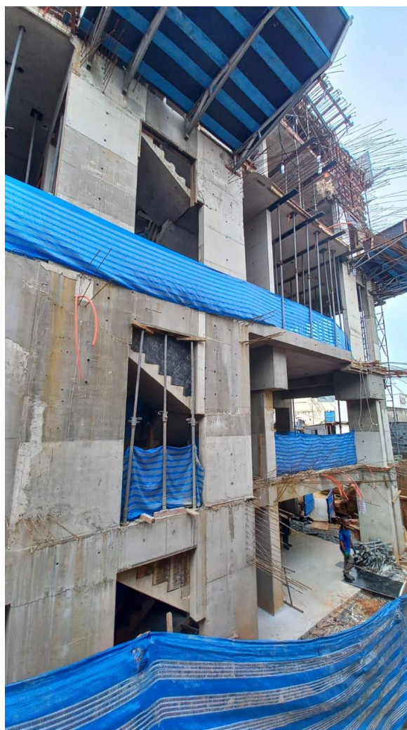
Foto 03 – Visão lateral direita da torre;
