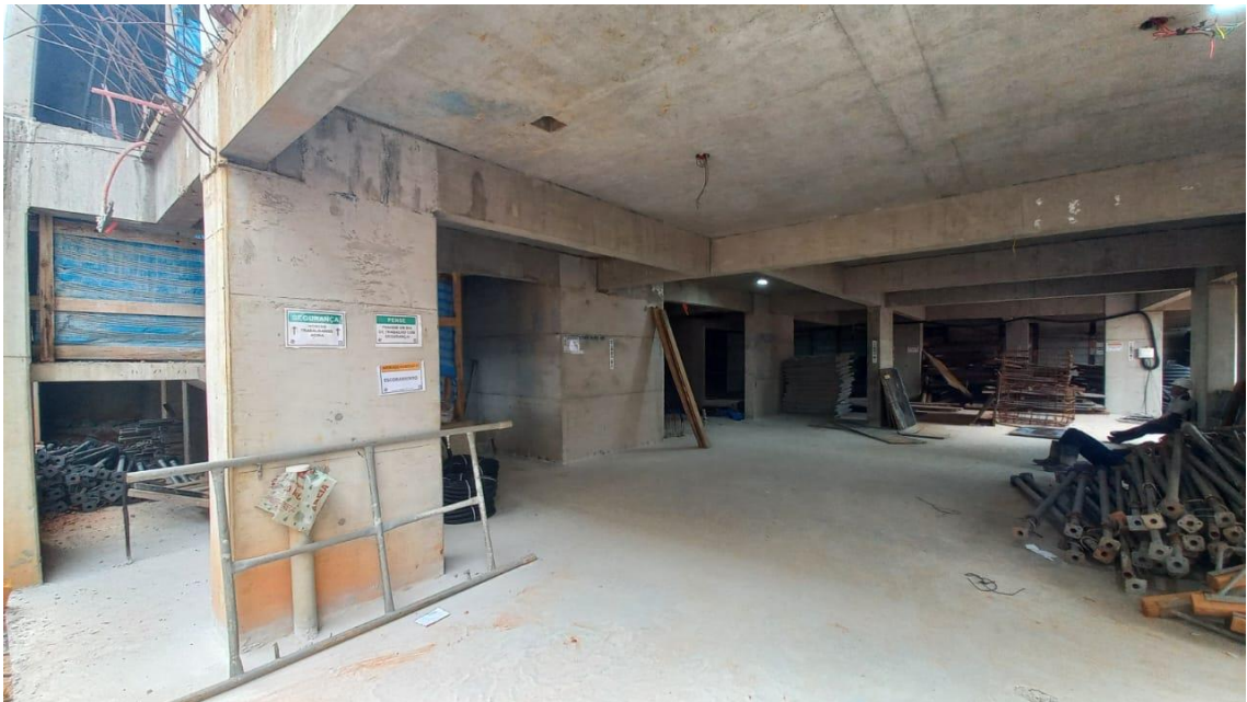
Foto 06 – Piso 2º subsolo concretado;
