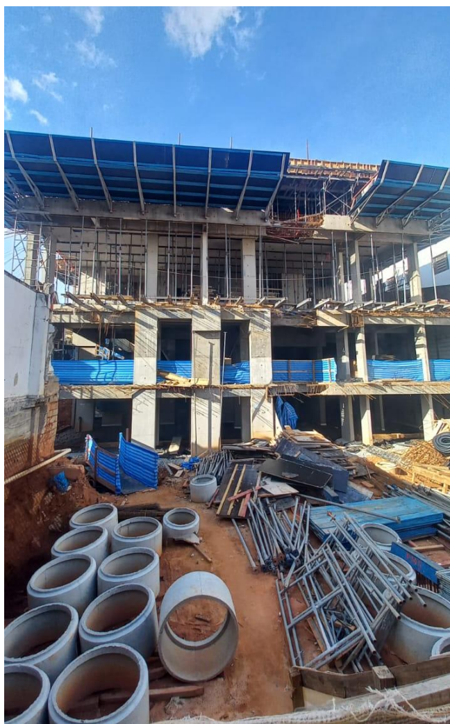
Foto 08 – Visão geral fundo da obra – piso 2º andar – notar bandeja e material drenagem.
