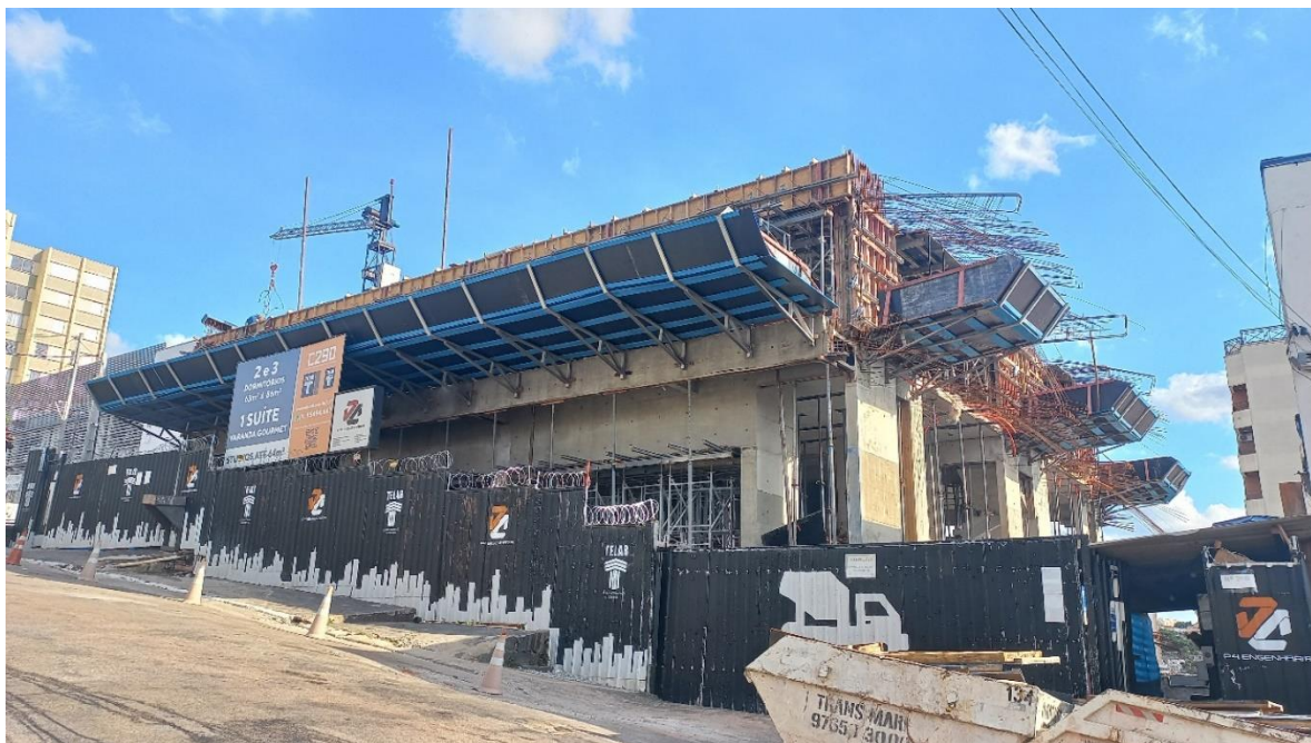
Foto 01 – vista geral frente da obra forma montagem 3º pavimento; observar bandeja
