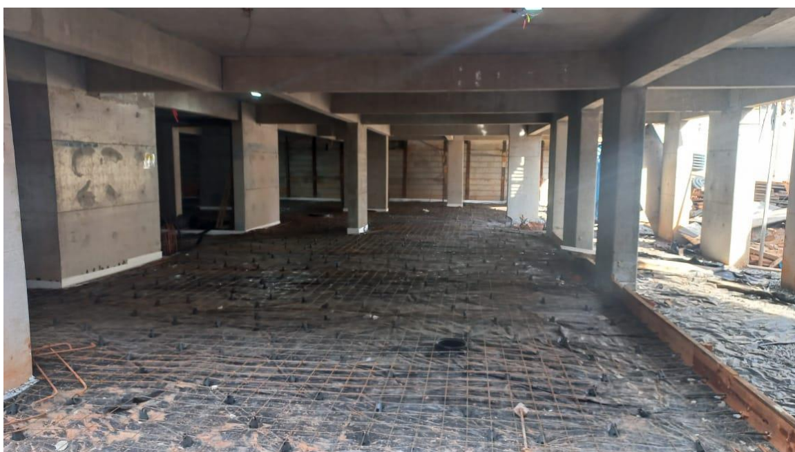
Foto 07 – Piso 2º subsolo armado para concretagem;
