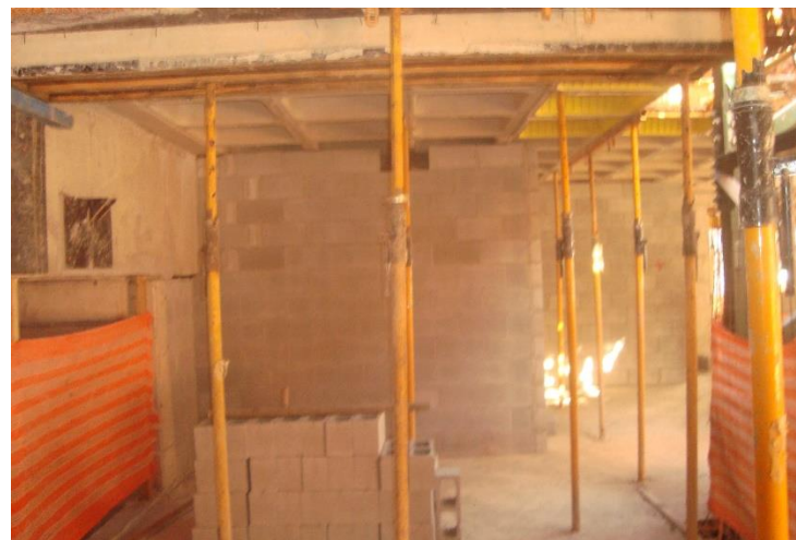
Alvenaria/ Vedação – 1º Pav
