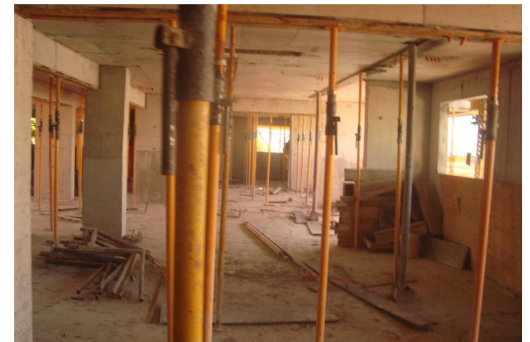
Escoramento – 3º pav
