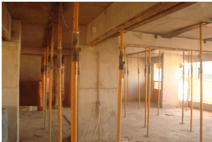
Vista Estrutura – 2º Pav
