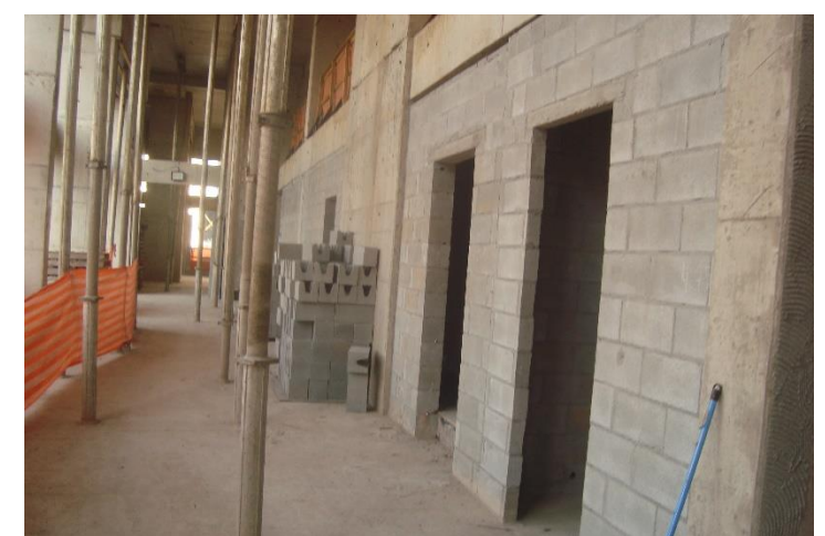
Alvenaria/ Vedação - Térreo
