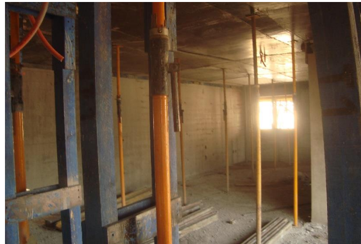
Escoramento – 4º pav
