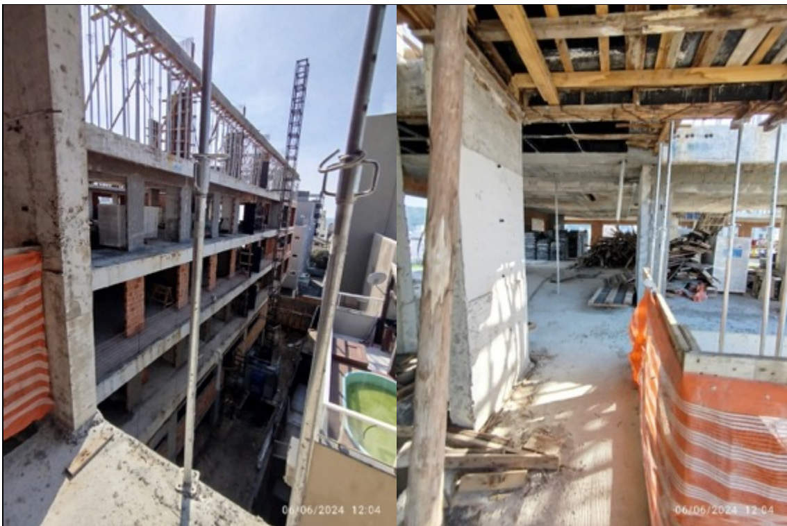
Foto 36 - Vista da estrutura da torre
