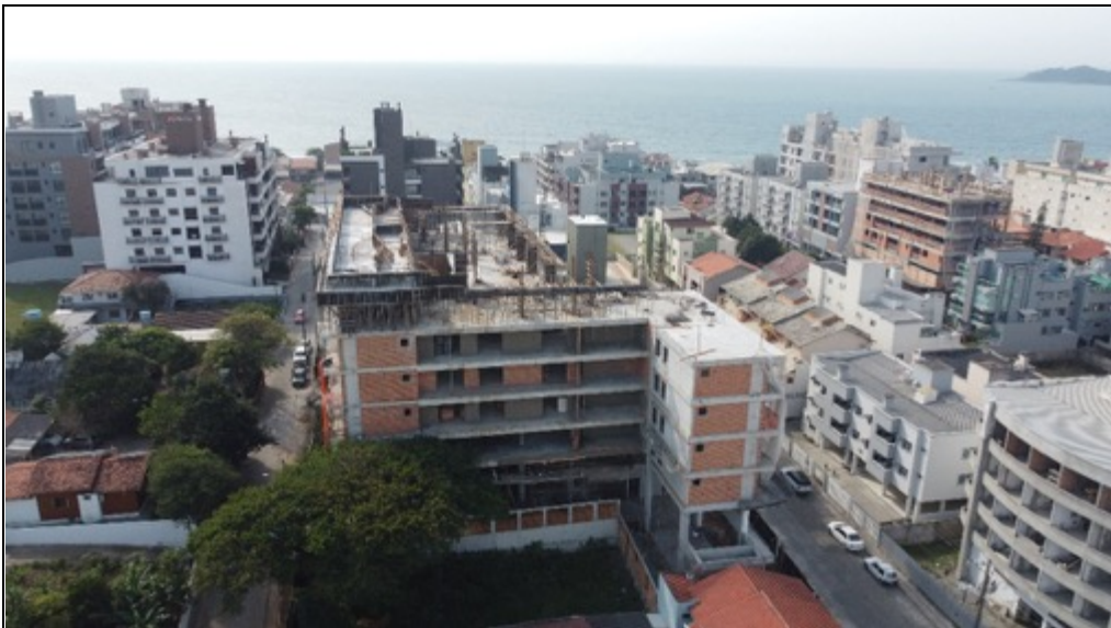
Foto 10 - Vista aérea do empreendimento
