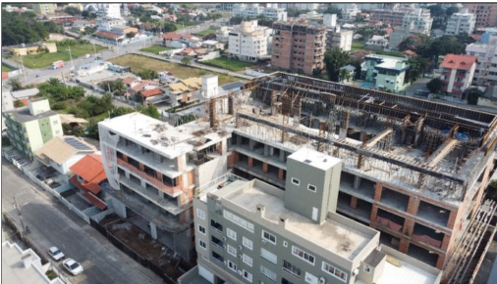
Foto 8 - Vista aérea do empreendimento
