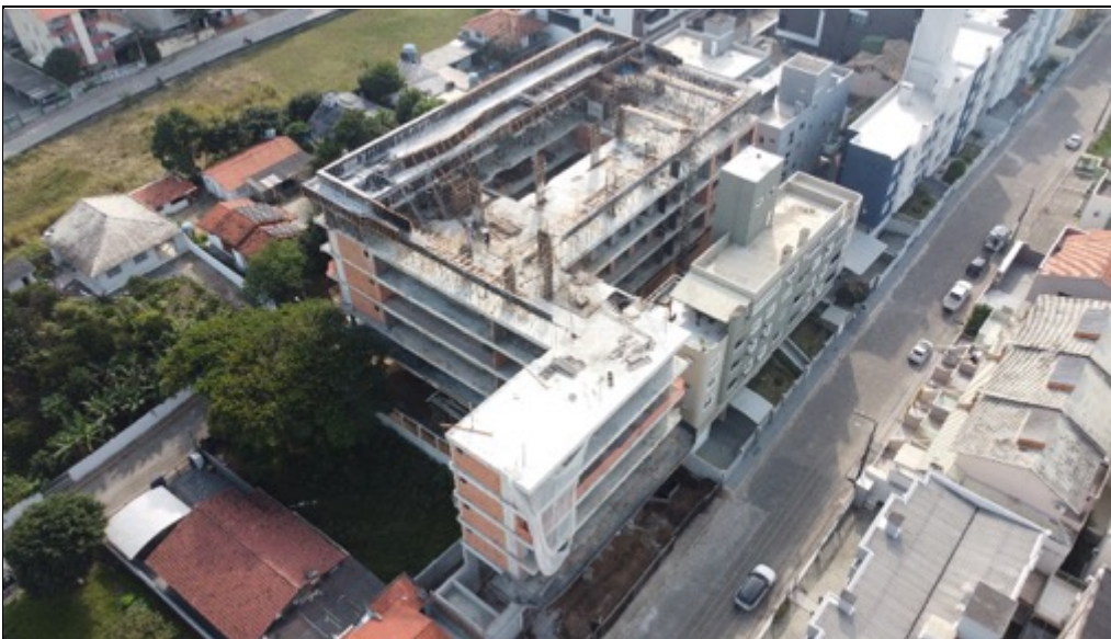
Foto 6 - Vista aérea do empreendimento
