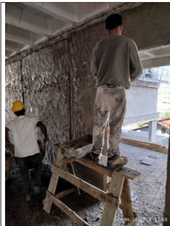
Foto 21 - Serviço de emboço interno
