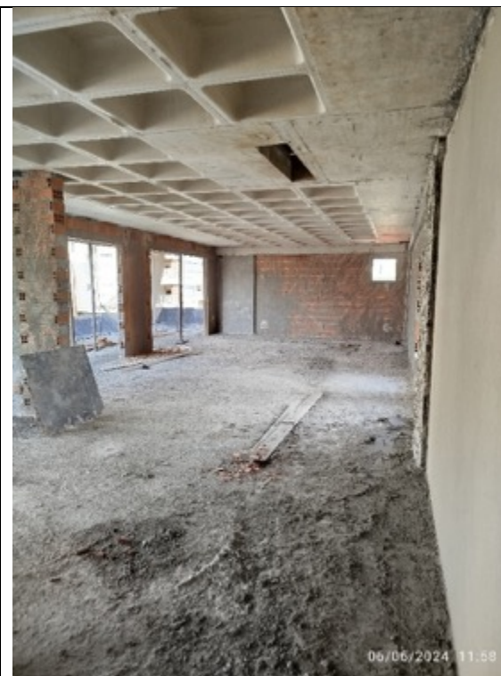
Foto 22 - Serviço de chapisco
