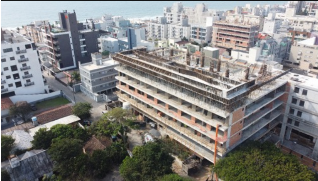
Foto 7 - Vista aérea do empreendimento
