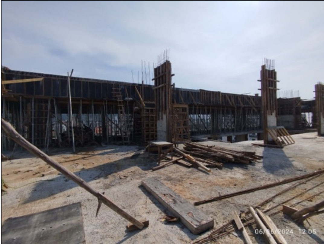
Foto 35 - Serviço de execução da estrutura
