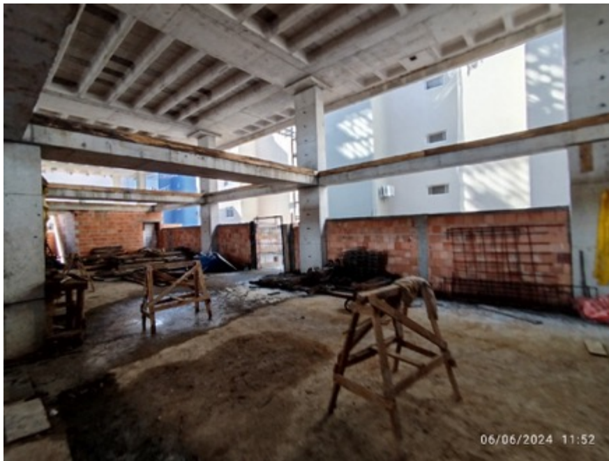
Foto 26 - Área de montagem das ferragens
