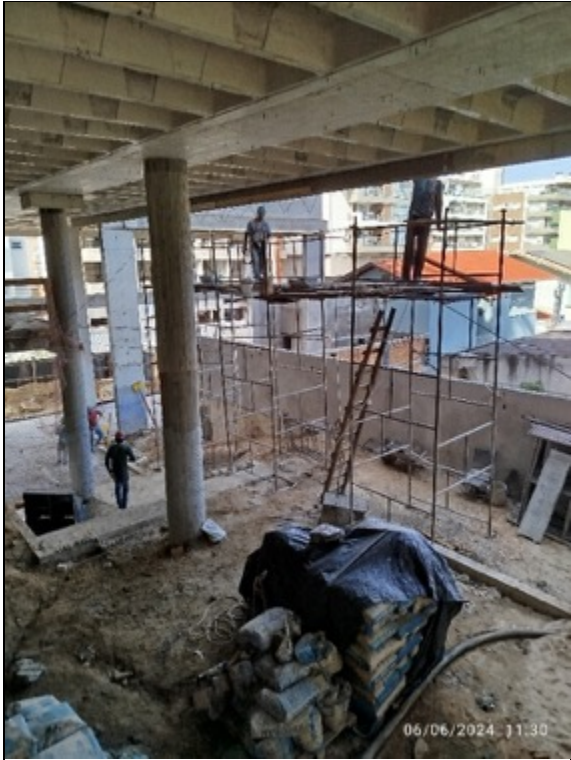
Foto 13 - Execução de reboco externo
