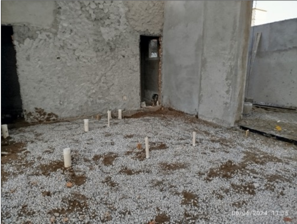
Foto 17 - Execução das infraestruturas enterradas no piso da recepção
