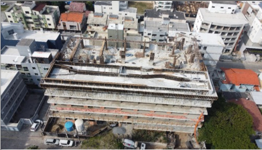
Foto 3 - Vista aérea do empreendimento
