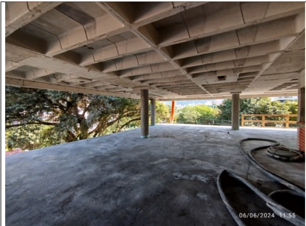
Foto 27 - Contra piso executado
