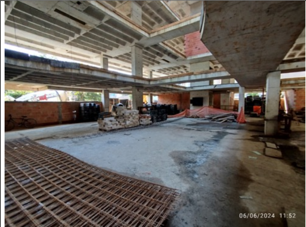
Foto 25 - Piso de garagem – armazenamento de material
