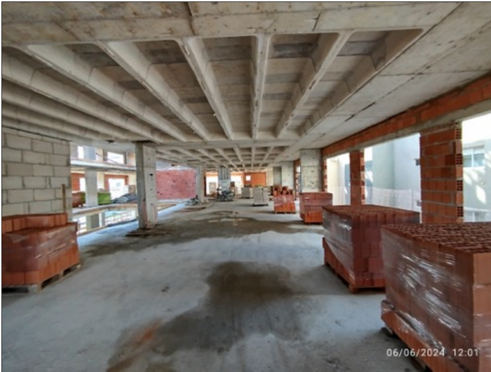
Foto 31 - Serviço de execução de alvenaria
