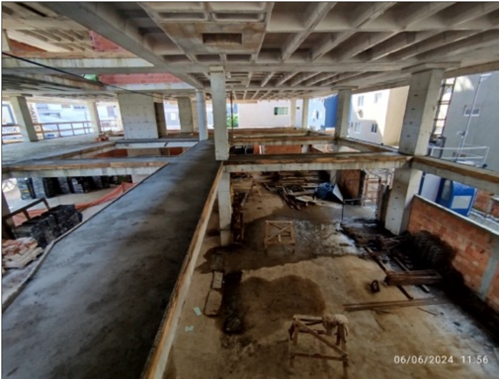
Foto 29 - Vista da estrutura
