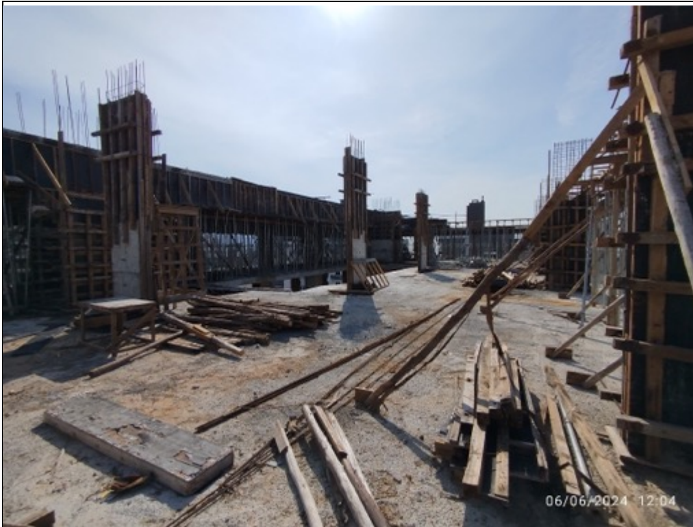
Foto 34 - Serviço de execução da estrutura
