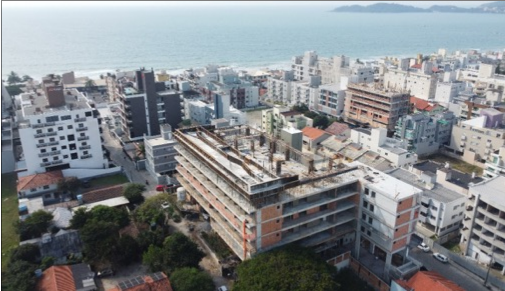
Foto 11 - Vista aérea do empreendimento
