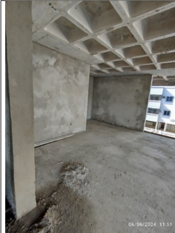
Foto 19 - Serviço de contrapiso + emboço
