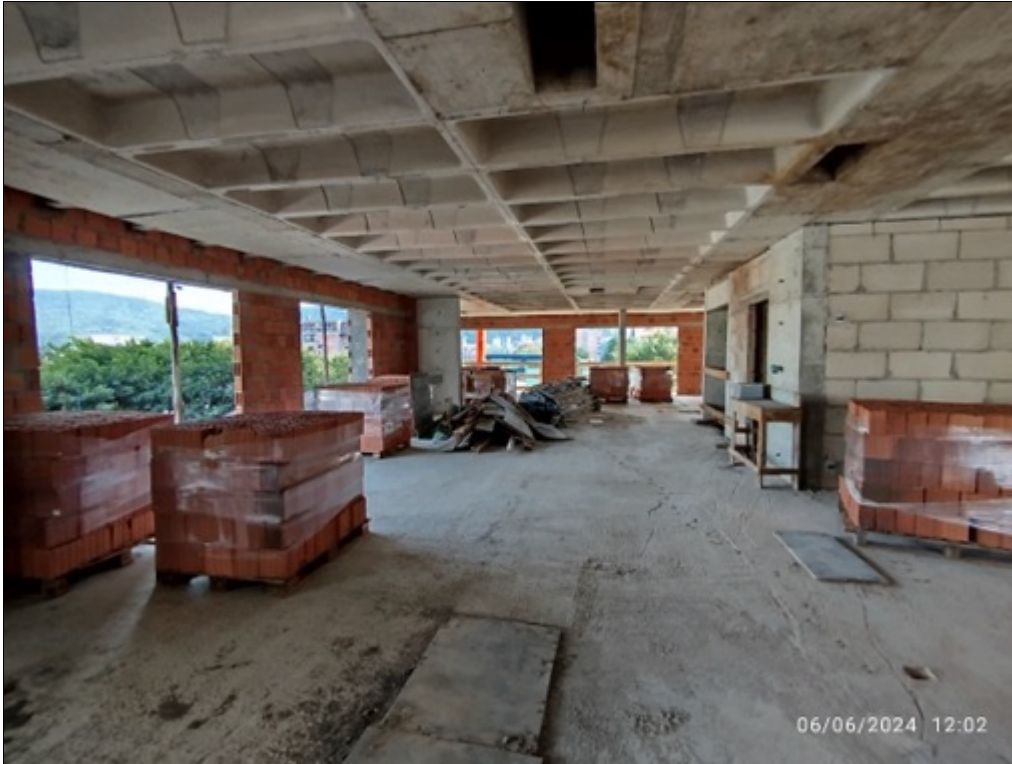
Foto 32 - Serviço de execução de alvenaria
