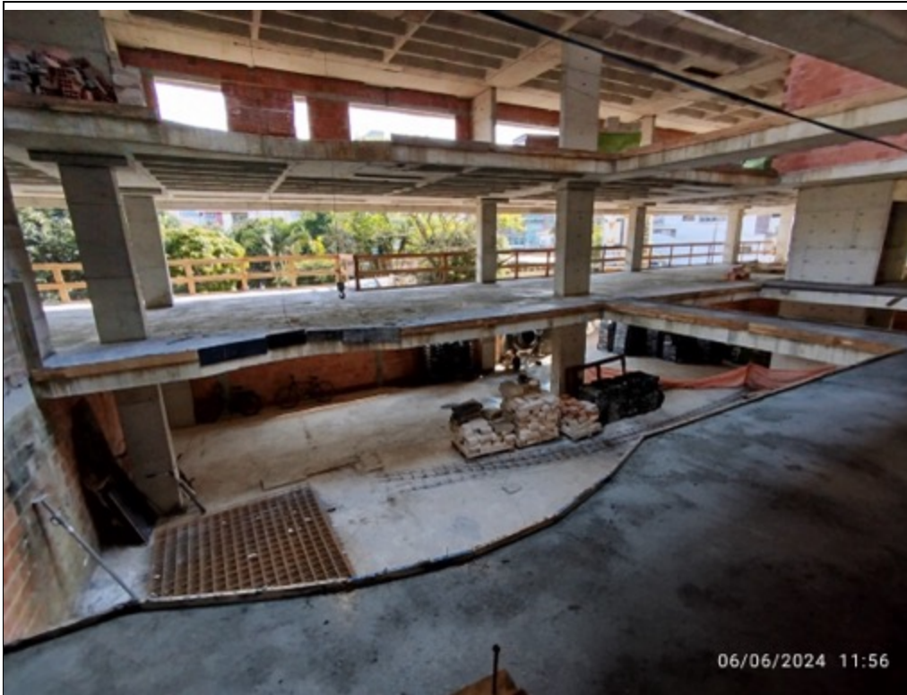
Foto 30 - Contra piso executado no andar
