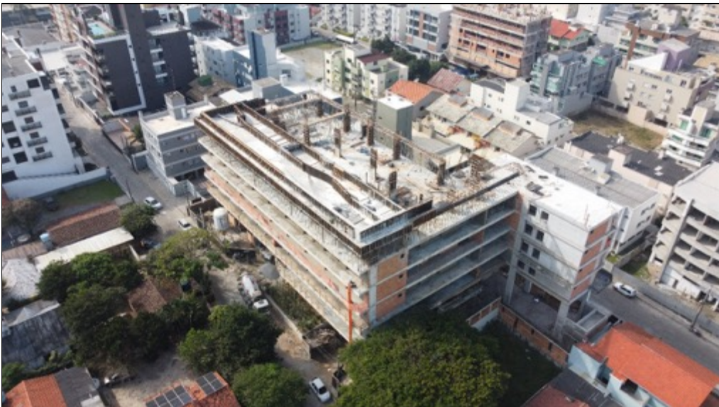
Foto 2 - Vista aérea do empreendimento
