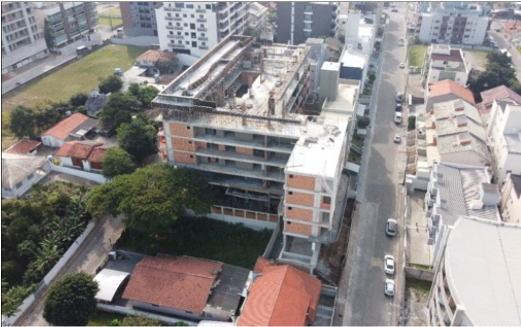
Foto 1 - Vista aérea do empreendimento
