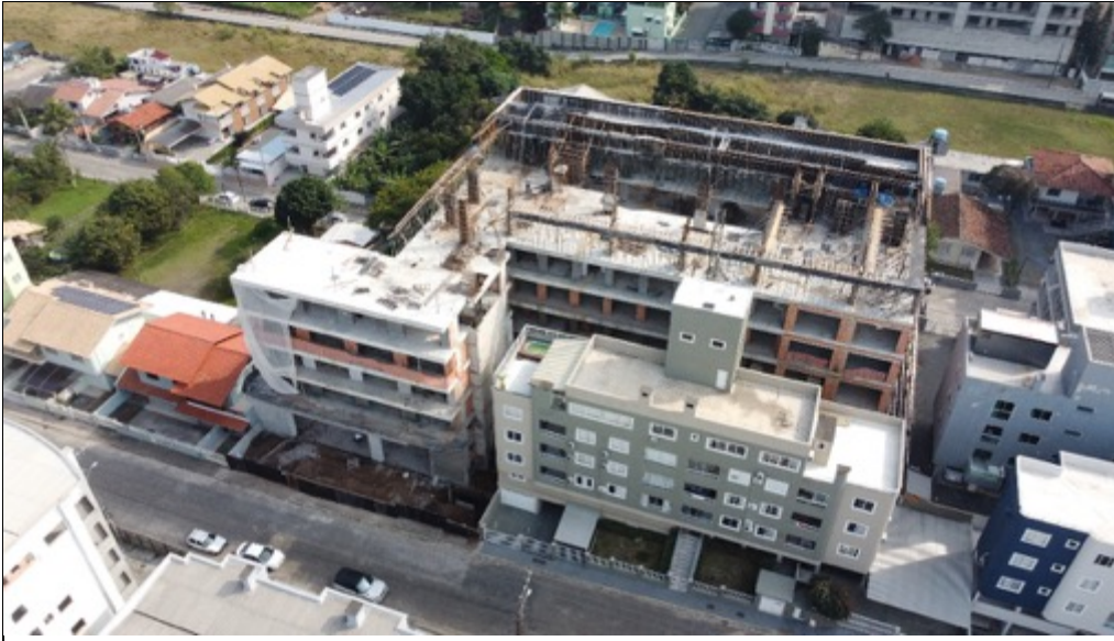
Foto 5 - Vista aérea do empreendimento
