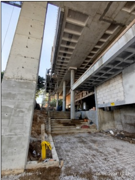
Foto 15 - Serviço de concretagem do piso
