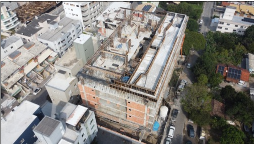
Foto 4 - Vista aérea do empreendimento
