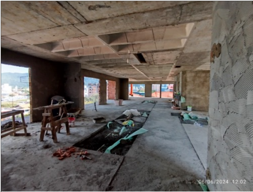
Foto 33 - Serviço de reboco interno
