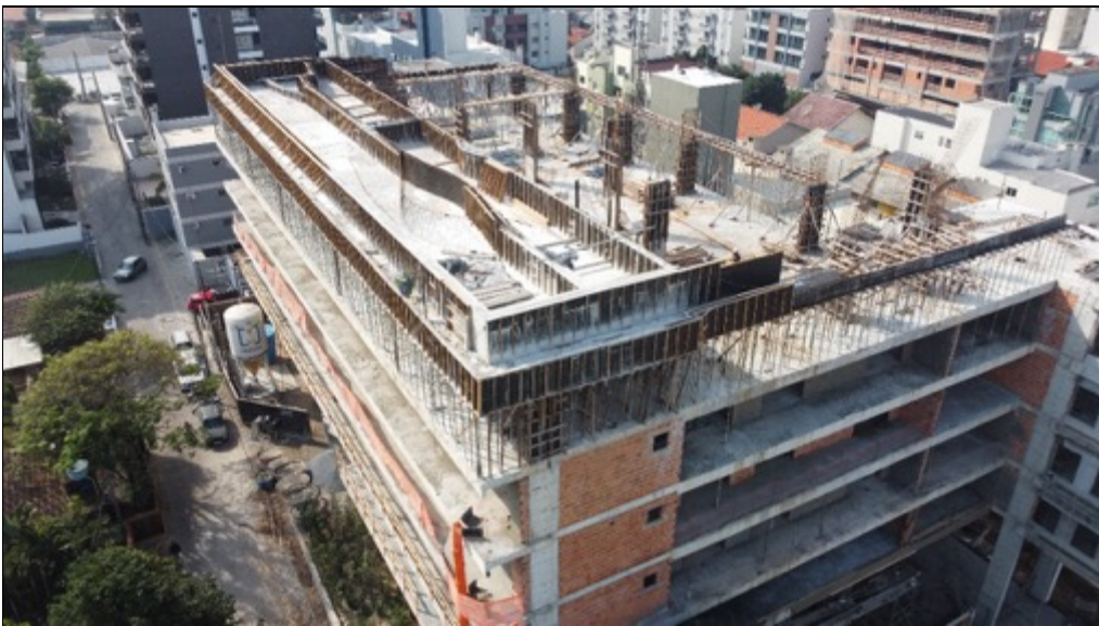
Foto 12 - Vista aérea do empreendimento
