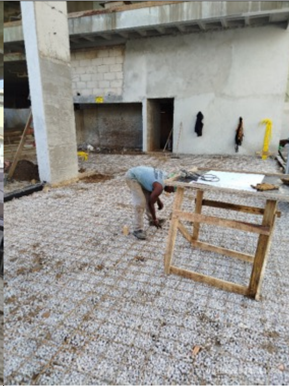
Foto 14 - Serviço de concretagem do piso
