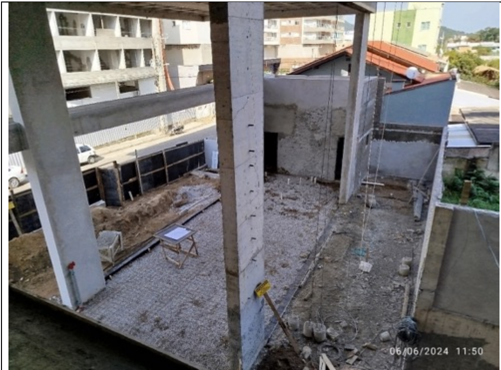
Foto 23 - Vista da recepção - estrutura
