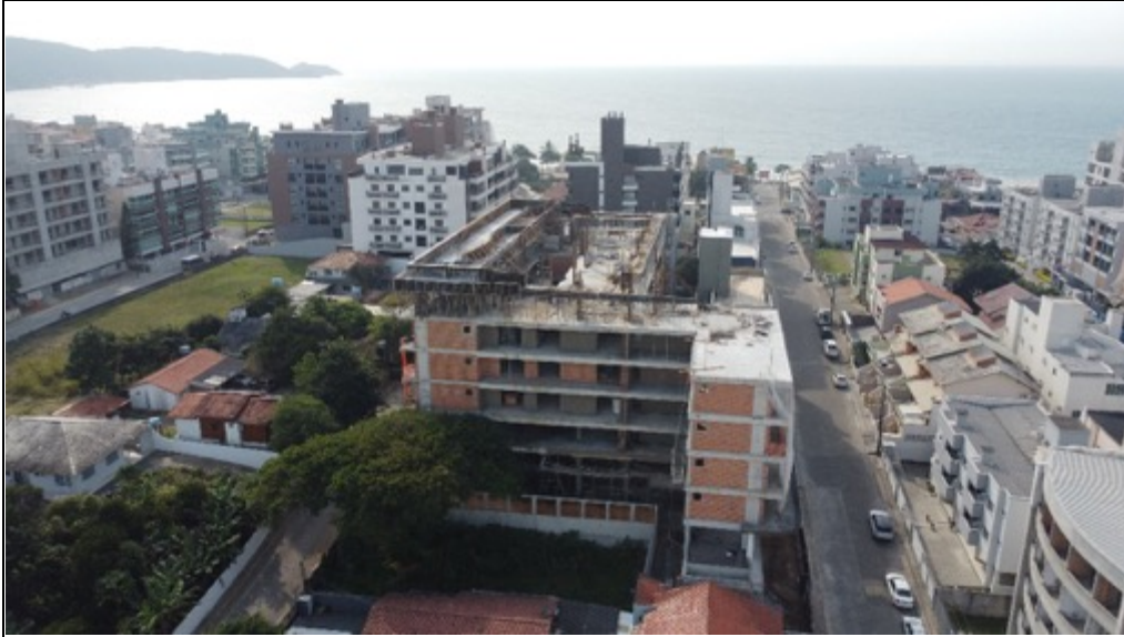
Foto 9 - Vista aérea do empreendimento
