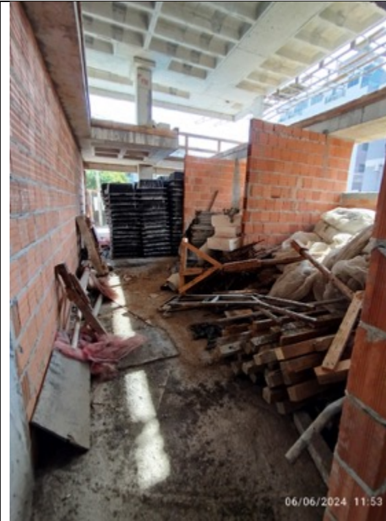
Foto 20 - Serviço alvenaria + estoque de forma
