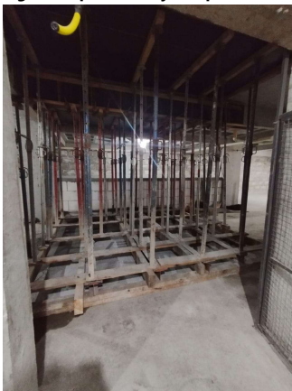
Foto 15 - Concretagem de parte da laje do pav lazer
