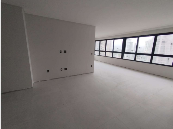
Foto 31 - Instalando tomadas e interruptores
