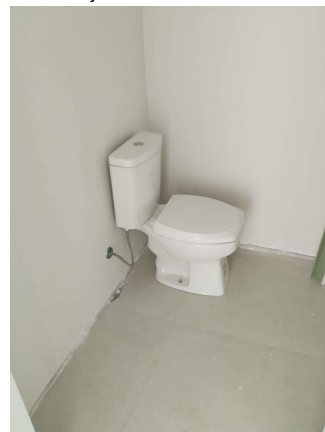
Foto 30 - Instalação das louças
