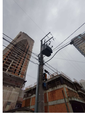
Foto 8 - Transformador Instalado
