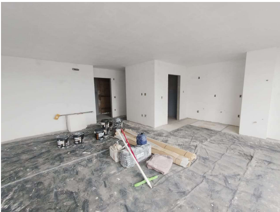
Foto 27 - Continuação do emassamento e pintura
