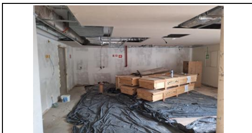
Colocação do forro em drywall
