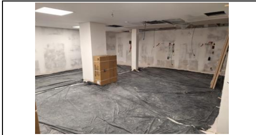
Pintura das paredes e instalação das luminárias
