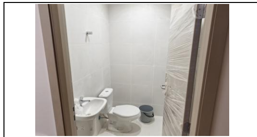
Banheiro masculino do 2º pavimento
