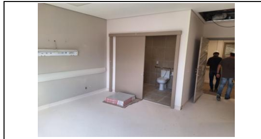
Leito com instalações semi-concluída
