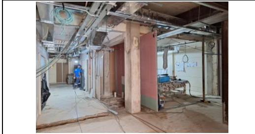
Estruturação das paredes de drywall e infraestrutura aérea
