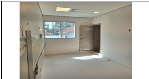
Leito com instalações semi-concluída
