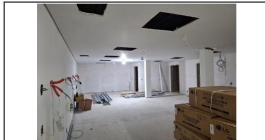
Pintura das paredes e instalação das luminárias
