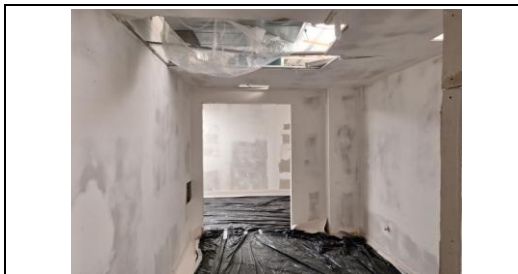
Pintura das paredes e instalação das luminárias
