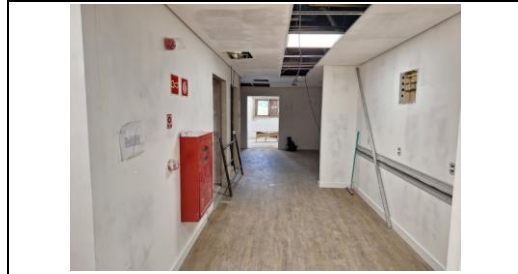
Corredor de acesso ao elevador externo
