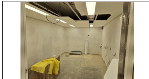
Colocação do forro em drywall
