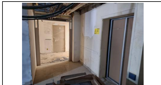
Hall de distribuição
