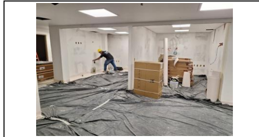
Pintura das paredes e instalação das luminárias
