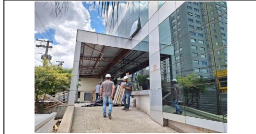
Cobertura da rampa e fachada pela Avenida Dom Pedro II
