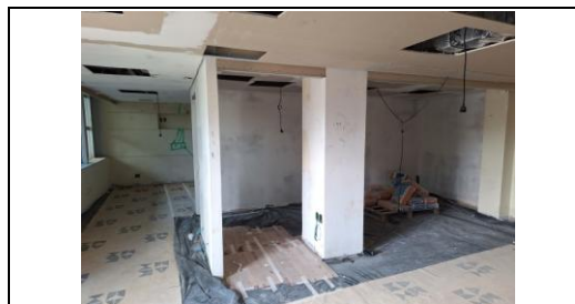
Colocação do forro em drywall
