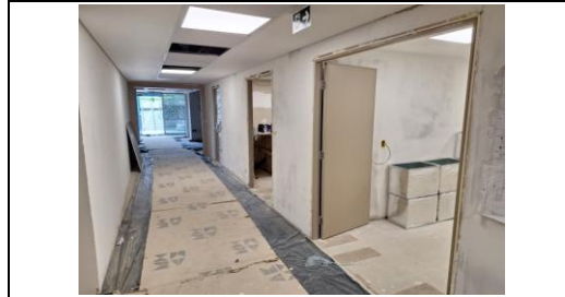
Corredor do piso térreo com piso vinílico e portas colocadas
