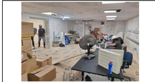
Pintura das paredes / Sala utilizada pelo escritório da obra
