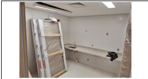
Sala com estoque de portas de madeira e pia instalada
