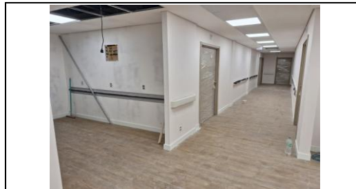
Corredor do 2º pavimento semi-concluído
