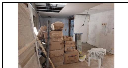
Colocação do forro de drywall e pintura das paredes
