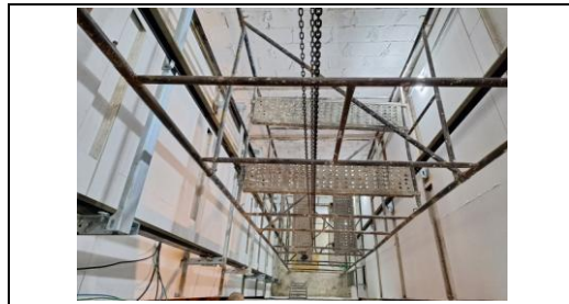
Poço do elevador externo
