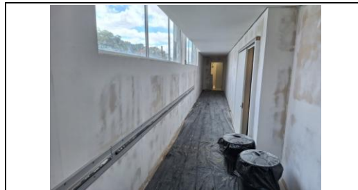
Corredor de acesso aos vestiários / Pintura das paredes
