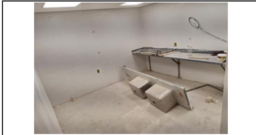
Pia de granito instalada e bancada de inox no chão
