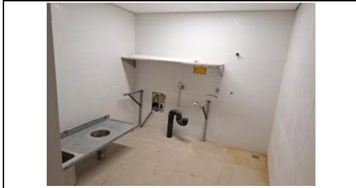
Sala com bancada removida para reparo na tubulação
