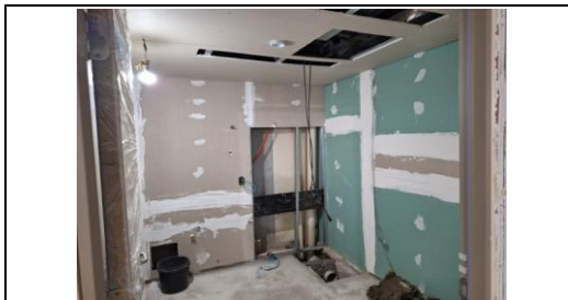
Instalação elétrica e massa corrida nas paredes de drywall
