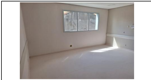
Leito com instalações semi-concluída
