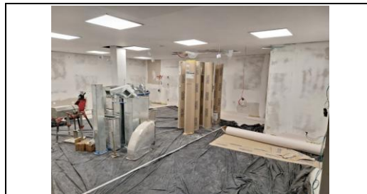
Pintura das paredes
