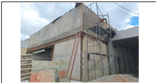
Reboco da fachada lateral direita do anexo
