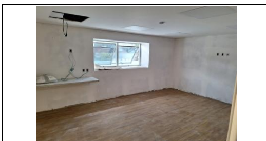
Instalação elétrica e pintura das paredes
