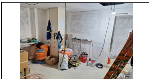
Pintura das paredes e instalação das luminárias
