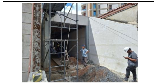
Rampa de acesso ao prédio e cobertura do corredor lateral
