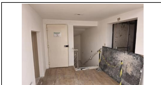
Hall da escadaria e elevador no 2º pavimento
