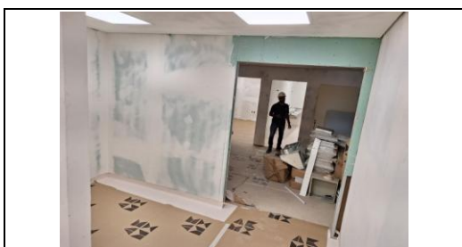
Pintura das paredes
