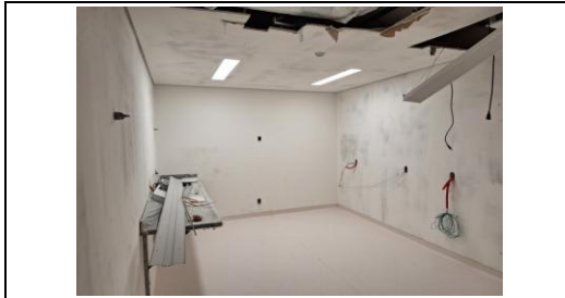
Reforma do forro em drywall e pintura das paredes
