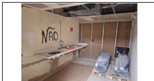
Colocação do forno em drywall e pia de granito instalada
