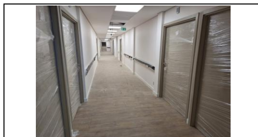
Corredor do 2º pavimento semi-concluído
