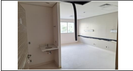
Leito com instalações semi-concluída
