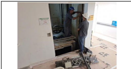
Retrofit do elevador interno (1º pavimento)
