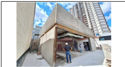
Fachada do anexo e reboco da lateral esquerda
