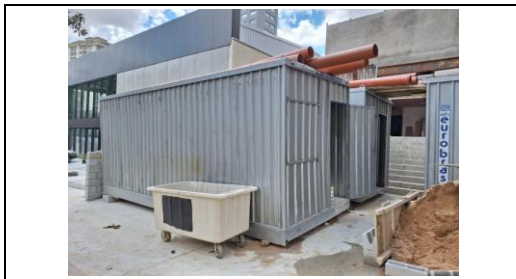
Containers de instalações da obra
