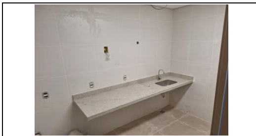
Pia de granito instalada com torneira cromada
