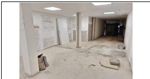
Pintura das paredes
