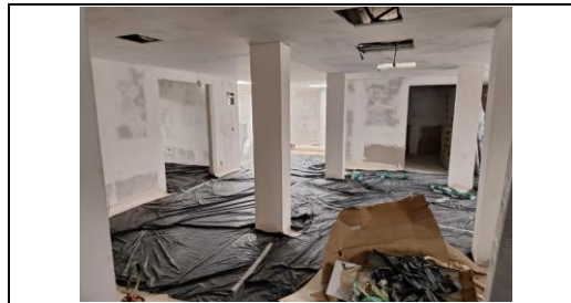
Pintura das paredes e instalação das luminárias
