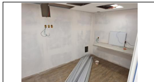
Instalação das luminárias e pintura das paredes
