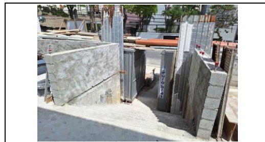
Escada de concreto de acesso ao prédio
