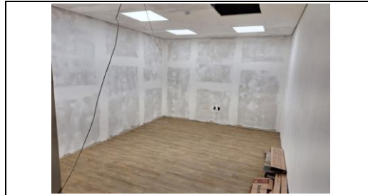
Pintura das paredes e instalação da luminárias
