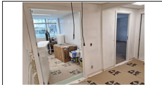
Portas de madeira e piso vinílico colocados
