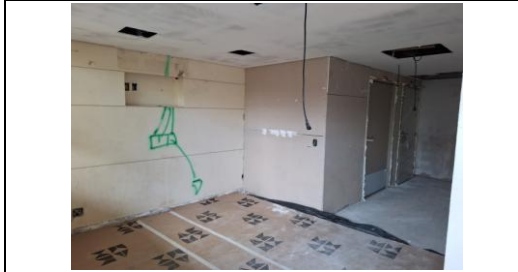
Aguardando pintura das paredes e instalação das luminárias
