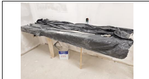
Pia de granito recém instalada
