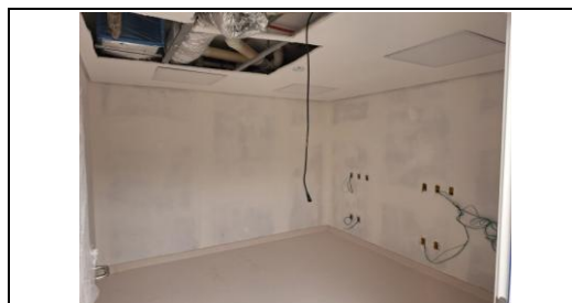
Instalação elétrica e pintura das paredes
