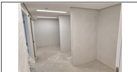
Hall dos banheiros e DML com azulejos assentados
