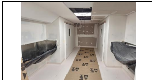
Corredor do 1º pavimento com lavatórios de inox
