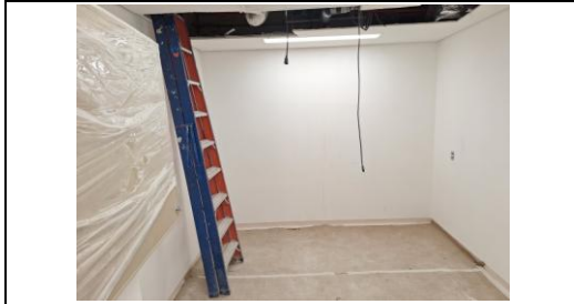
Reforma do forro em drywall
