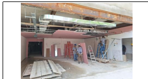
Instalação do forro anti-chama da área interna do anexo
