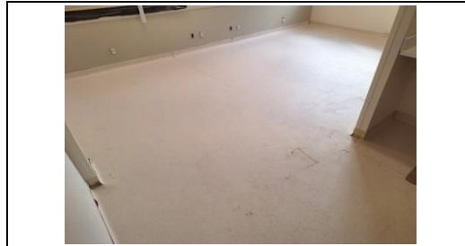
Piso vinílico do leito
