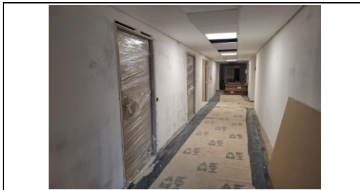
Corredor do piso térreo com piso vinílico e portas nas salas
