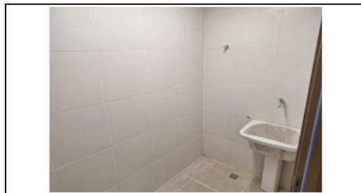
Depósito de material de limpeza (DML)
