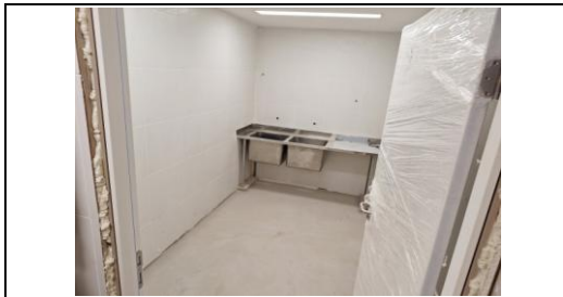
Sala semi concluída
