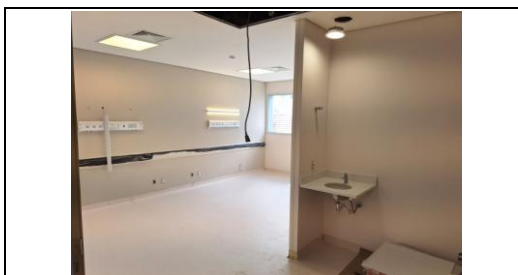
Leito com instalações semi-concluída
