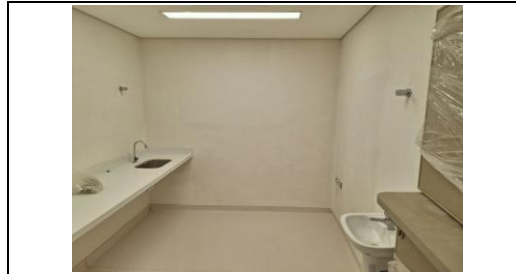
Sala semi concluída
