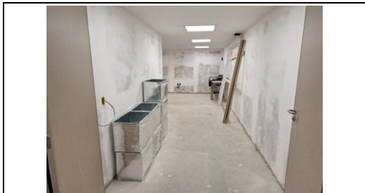
Pintura das paredes
