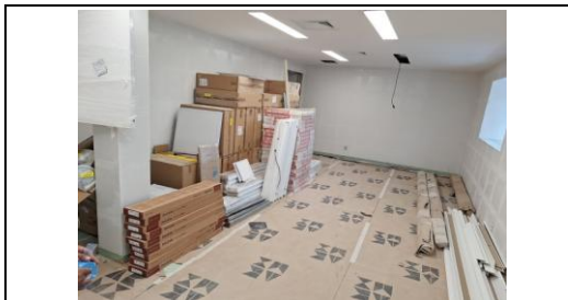
Sala semi concluída
