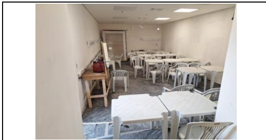
Pintura das paredes
