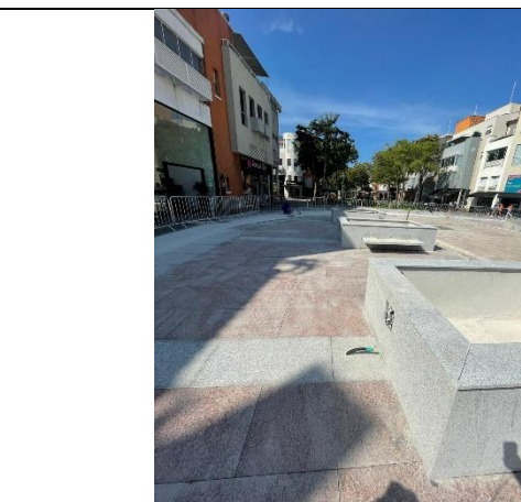
Vista do térreo sem tapume
