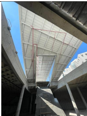
Vista da cobertura
