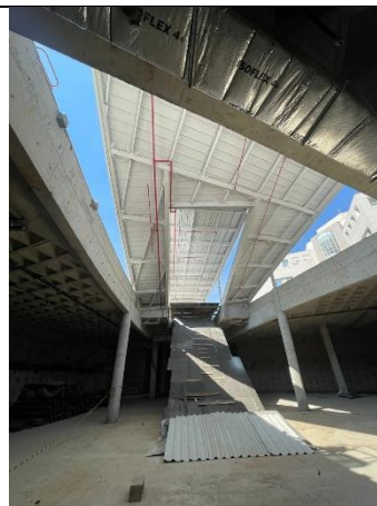
Vista da cobertura
