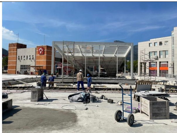
Detalhe da Cobertura
