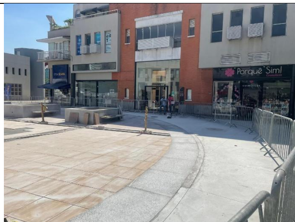
Vista do térreo sem tapume
