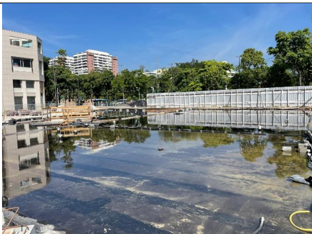
Teste de estanqueidade
