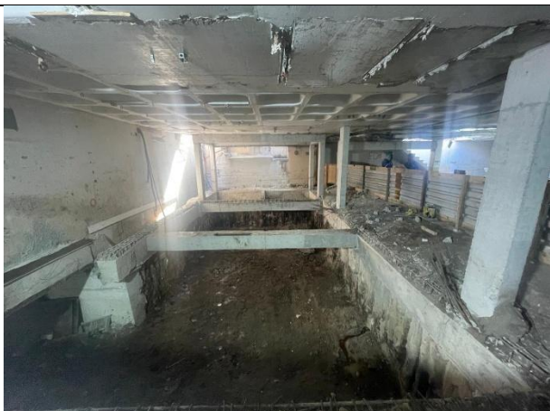
Rebaixamento Lençol Freático
