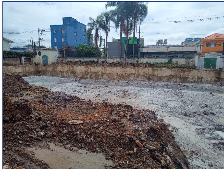
Foto 6 – Visão geral terreno - escavação
