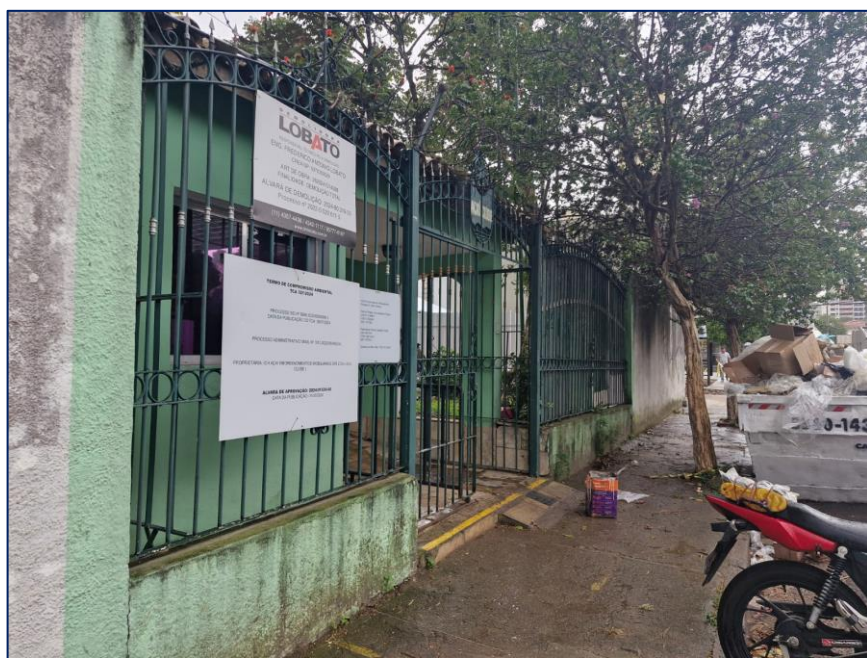
Foto 1 – Visão geral frente obra
