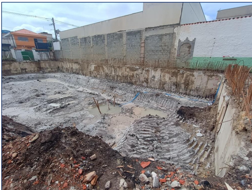
Foto 5 - Visão geral terreno - escavação
