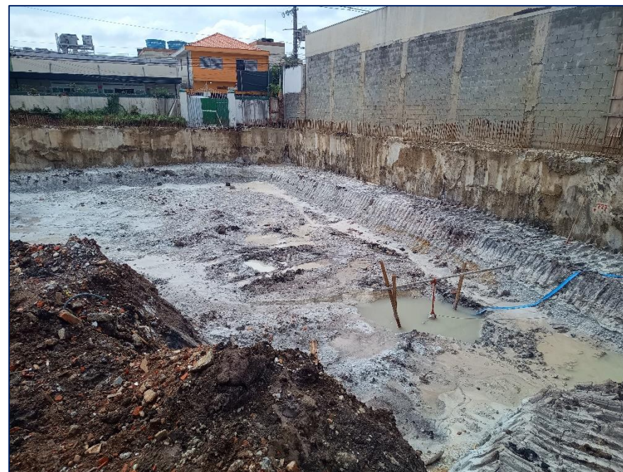
Foto 4 – Visão geral terreno – escavação
