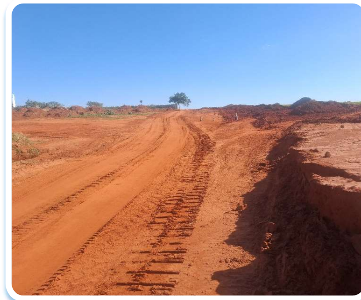
Foto 6 - Movimentação terra / regularização
