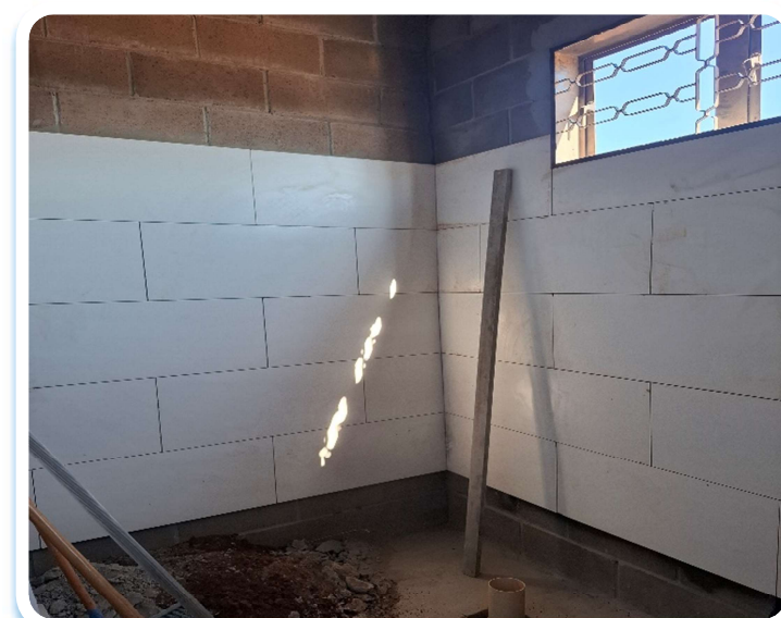
Foto 8 - Melhoria no canteiro de obra
