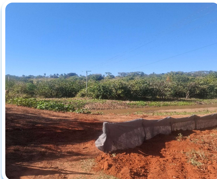
Foto 11 - Vazão no rio da Rede de águas pluvias / escada hidráulica
