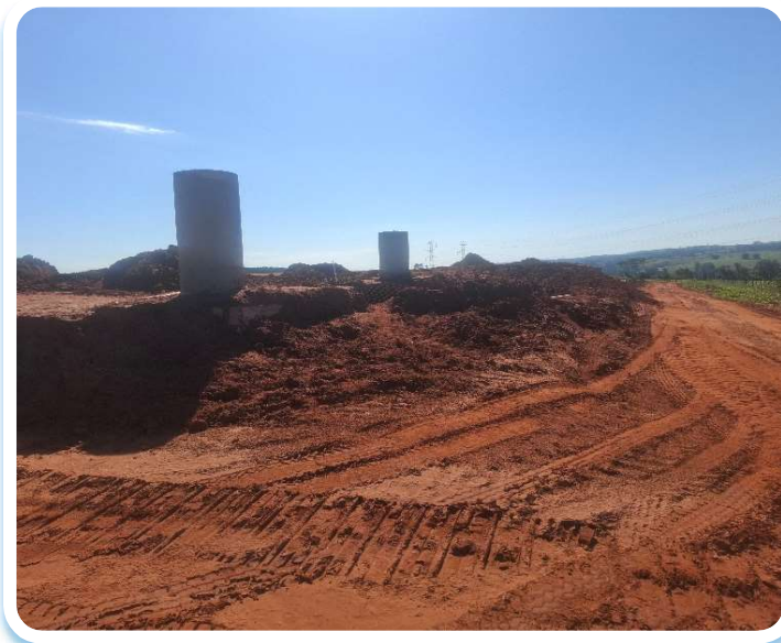
Foto 5 - Movimentação terra / regularização
