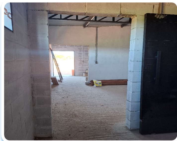
Foto 7 - Melhoria canteiro de obra
