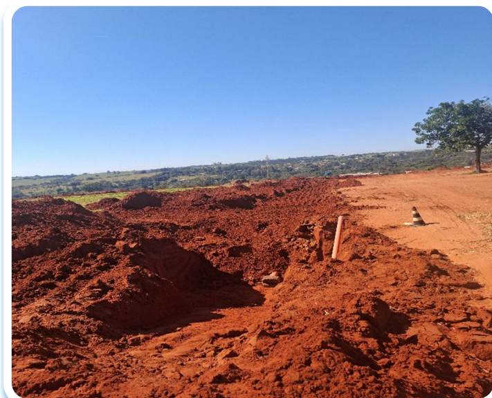
Foto 3 - Rede de esgoto
