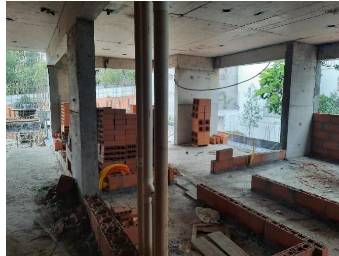
Marcação em Alvenaria – 4º Pav
