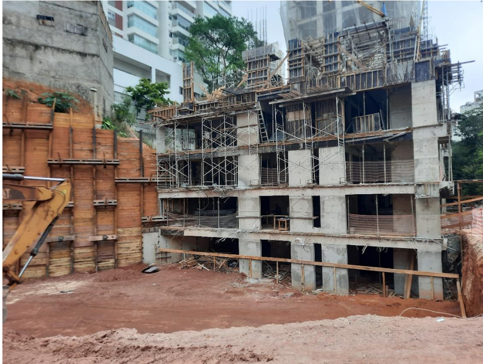
Vista da Estrutura
