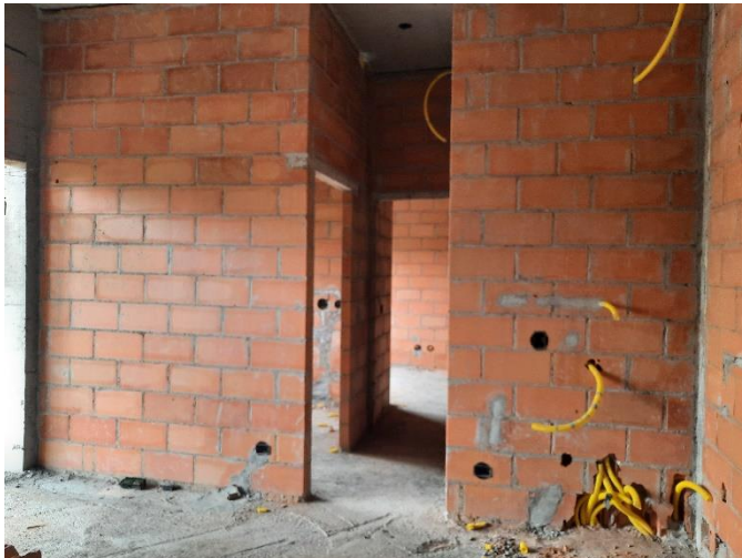
Embutido em Alvenaria – 2º Pav
