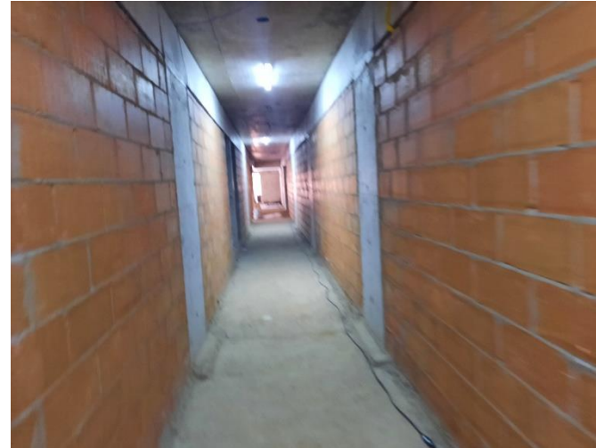
Alvenaria e Vedação – 1º Pav
