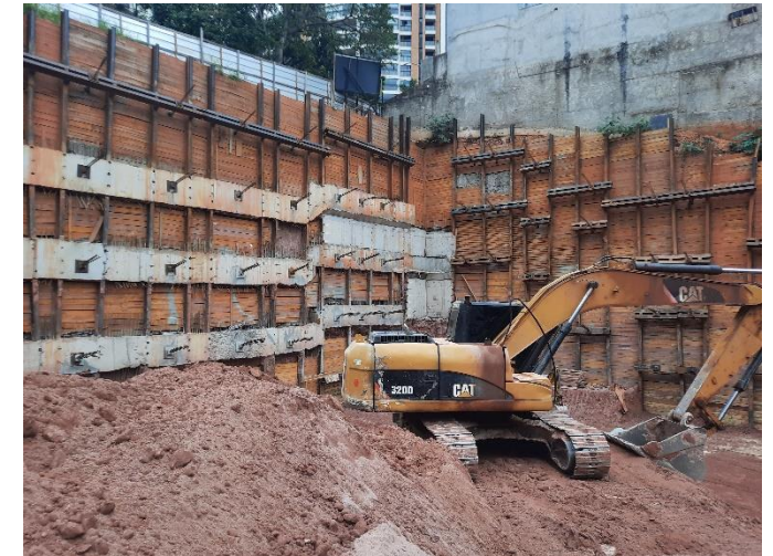
Cortina de Contenção
