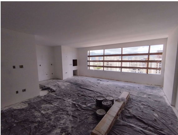
Foto 19 - Continuação da pintura
