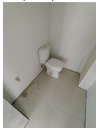
Foto 26 - Iniciada a instalação das louças
