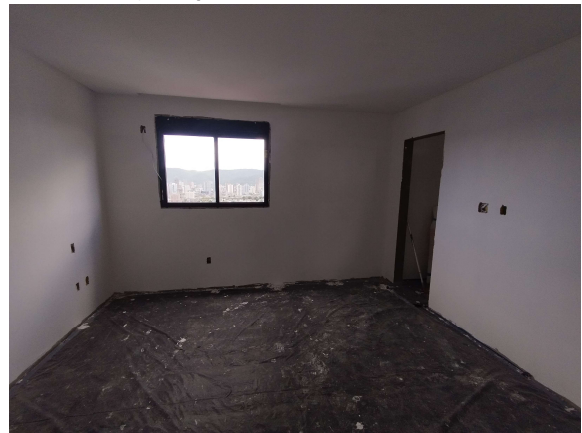
Foto 20 - Continuação da pintura
