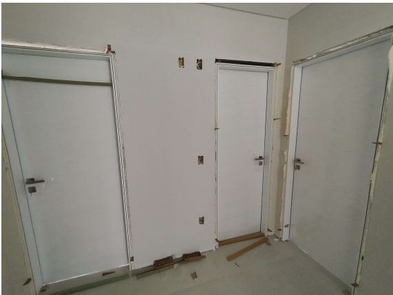
Foto 21 - Instalação das portas
