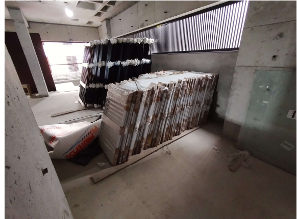
Foto 12 - Brises e exaustores
