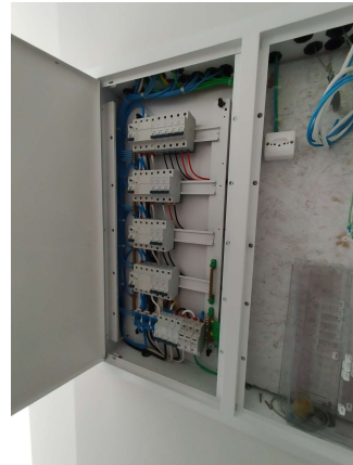
Foto 24 - Iniciada a montagem dos quadros
