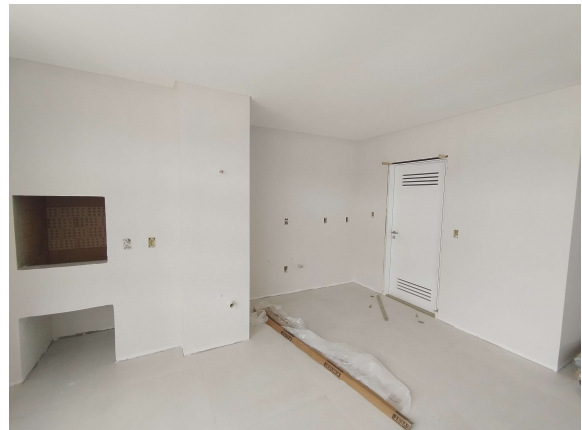
Foto 22 - Iniciada a instalação das portas
