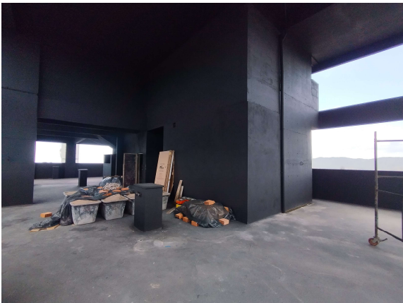
Foto 15 - Casa de Máquinas e Barrilete
