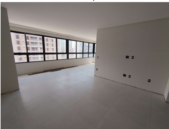
Foto 25 - Instalando tomadas e interruptores
