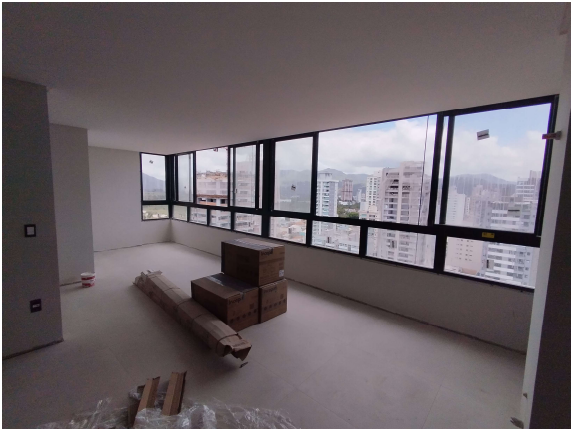
Foto 23 - Continuação da montagem das esquadrias de alumínio
