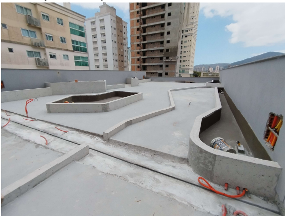
Foto 13 - Impermeabilização das floreiras
