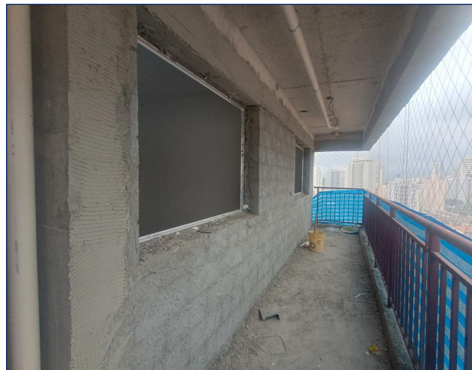
Foto 6 - Emboço área externa - varanda - 6º pavimento
