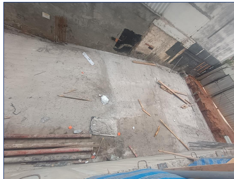
Foto 8 - Rampa de acesso subsolo
