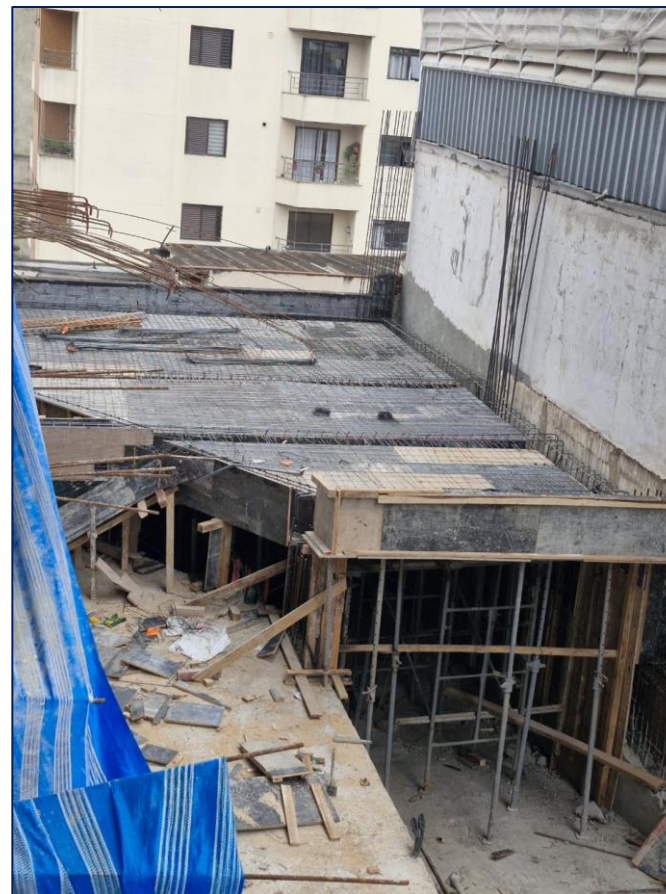
Foto 14 - Trecho a ser concretado - Rampa de acesso
