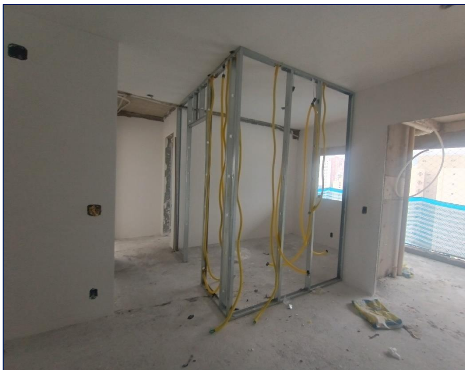
Foto 7 - Guias montagem - Drywall - 9º pavimento
