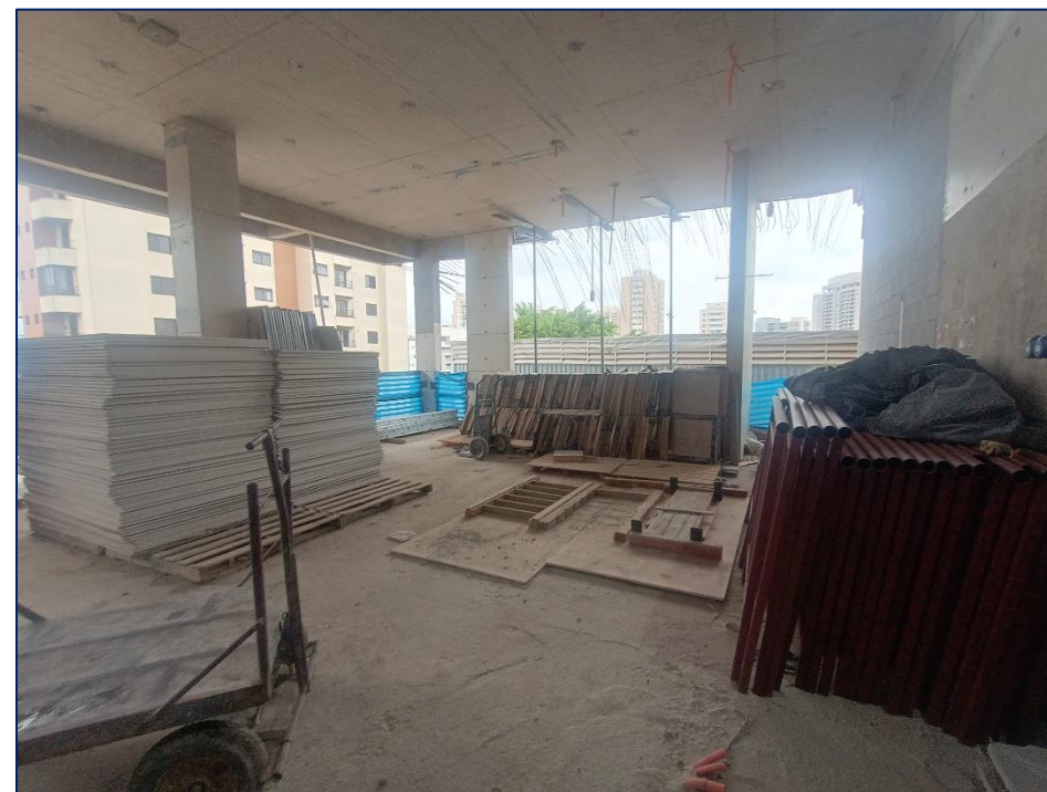
Foto 10 - Visão geral térreo - Materiais de serralheria e plaqueamento
