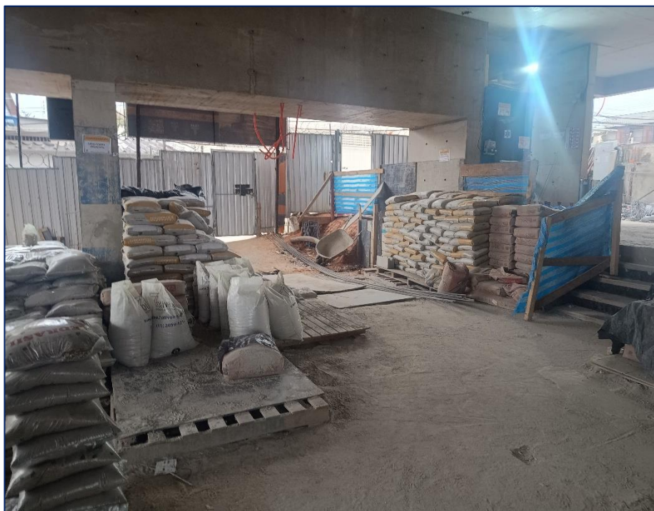
Foto 9 - Visão geral térreo - Materiais geral
