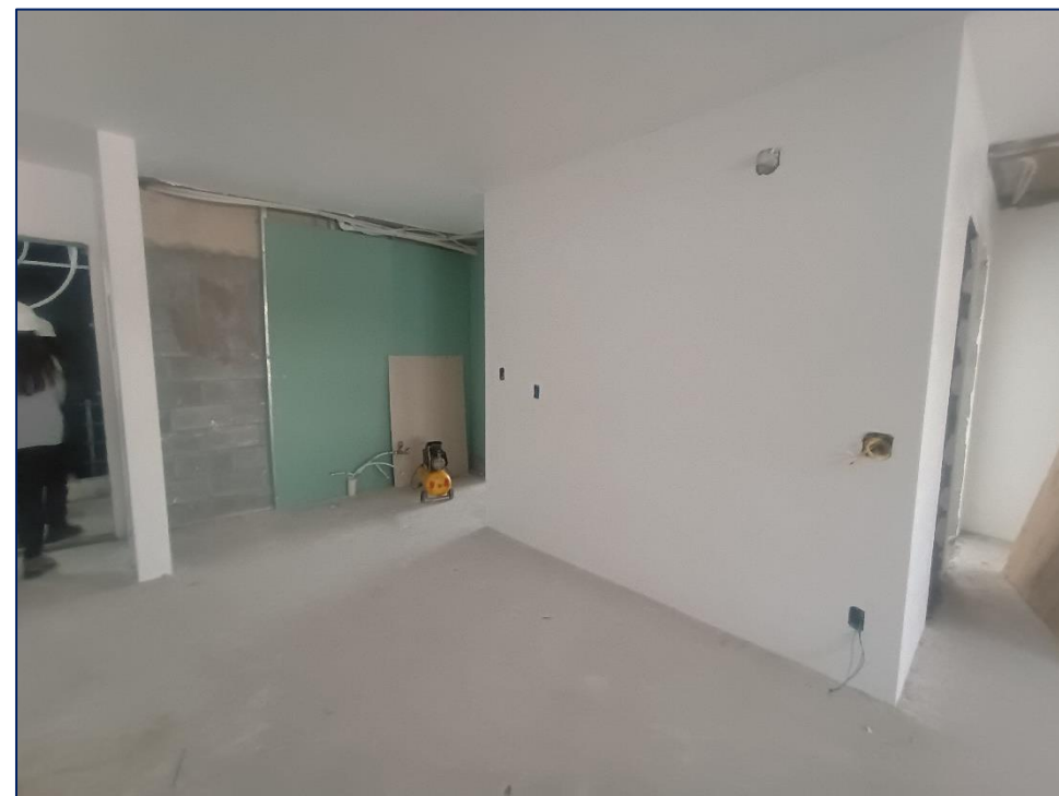
Foto 4 - Visão geral unidade - com plaqueamento (drywall) - 3º pavimento
