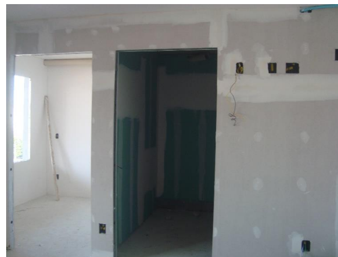
Parede Drywall – 2º Pav
