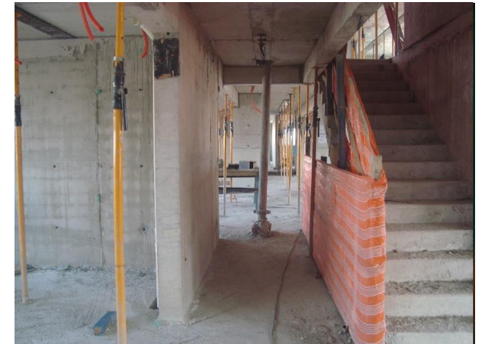
Proteção Perimetral Escadaria
