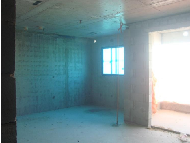
Vista Estrutura – 5º pav
