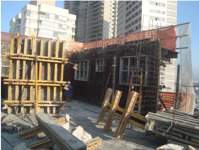
Armação Parede de Concreto – 14° pav
