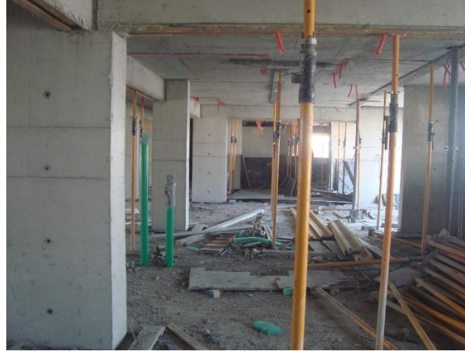
Vista Estrutura – 12° pav
