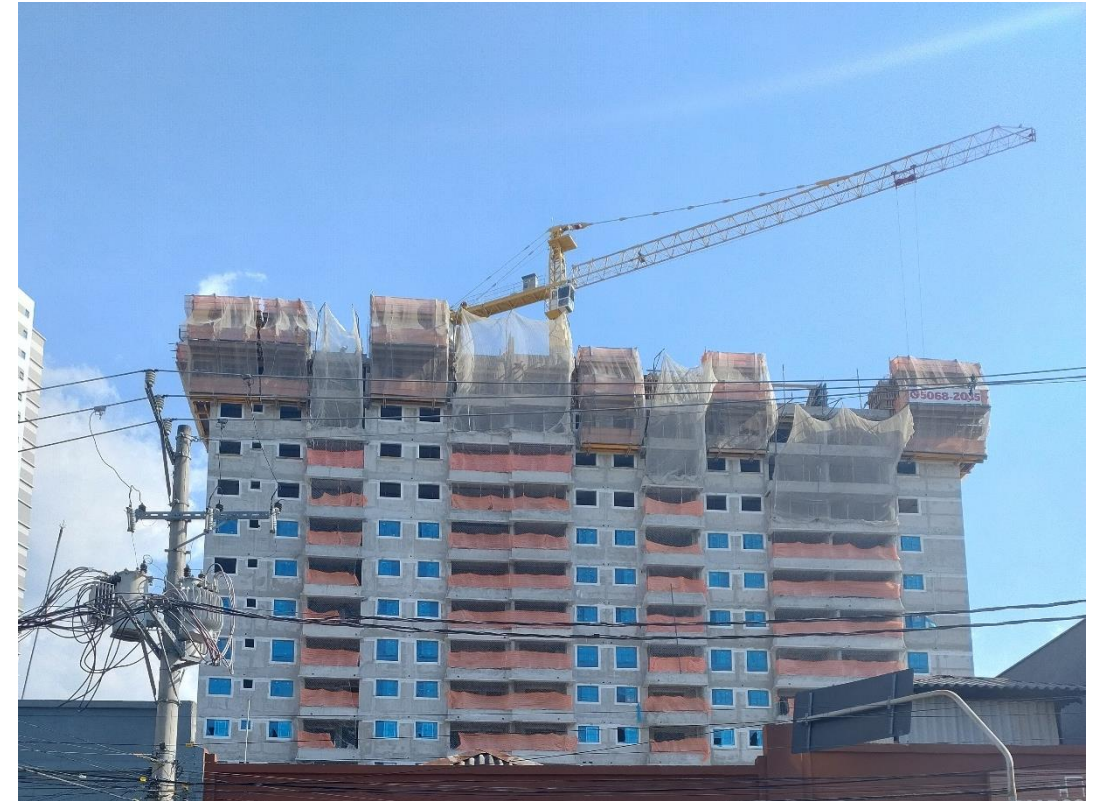
Vista Fachada Frontal
