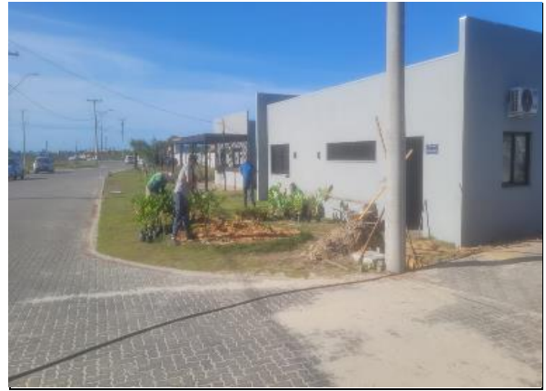
02 Execução de Paisagismo.
