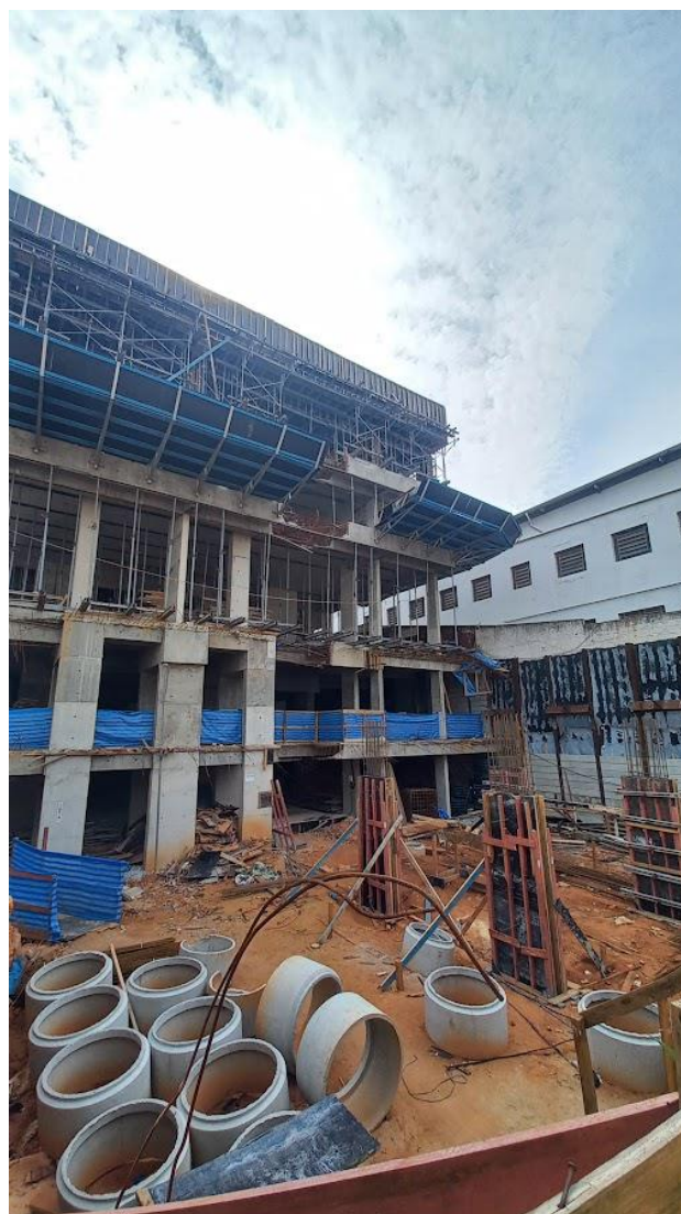
Foto 05 – Visão geral da torre (fundo) ;
