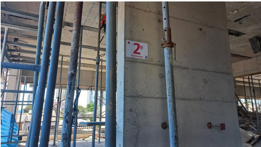
Foto 03 – Visão geral 2º pavimento (com escoramento);
