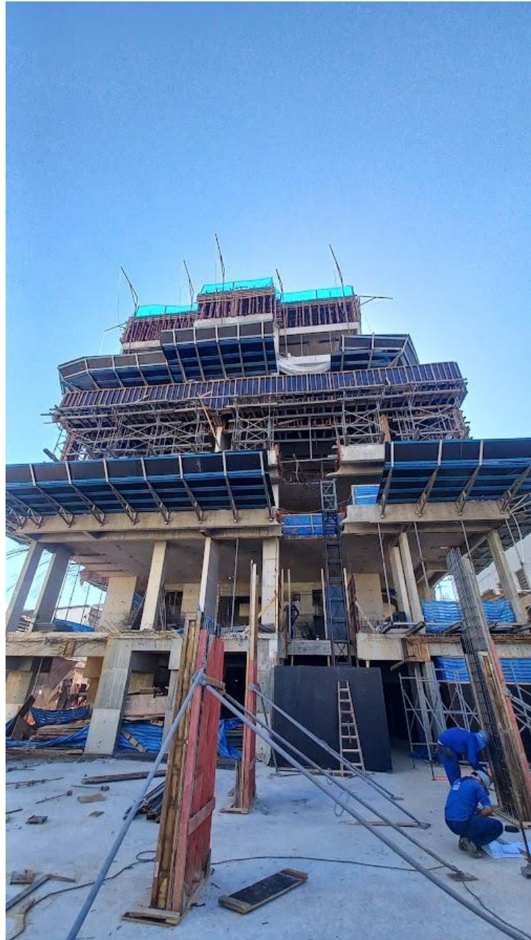
Foto 07 – Visão geral da torre (fundo);
