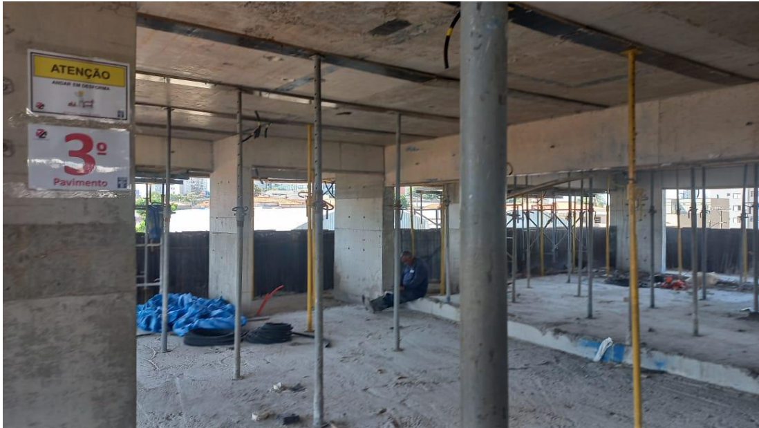
Foto 04 – Visão geral escoramento 3º pavimento;;
