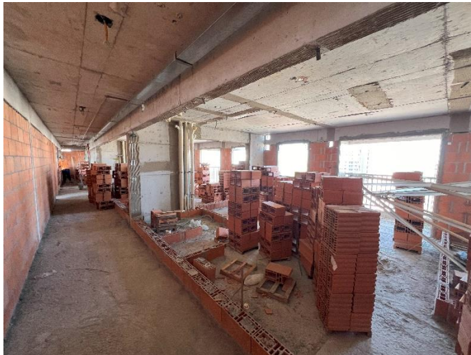
Eletrocalhas – 12º Pav
