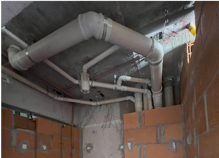
Ramais de Esgoto – 8º Pav
