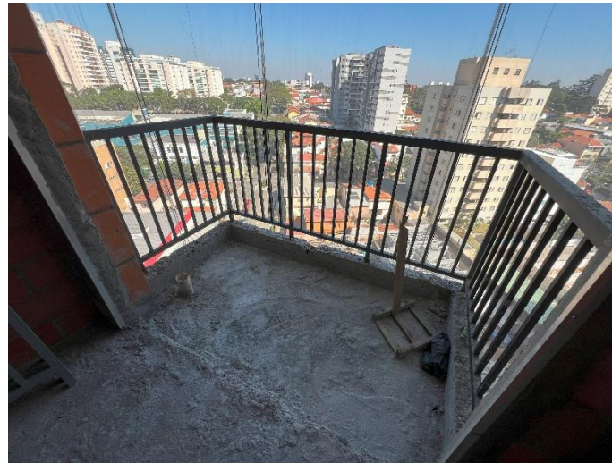
Gradil – 11º Pav
