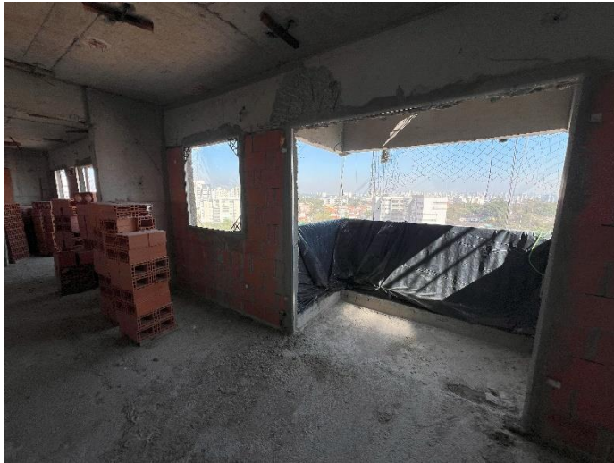
Alvenaria/ Vedação – 17º Pav
