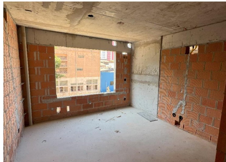
Alvenaria/ Vedação – 3º Pav
