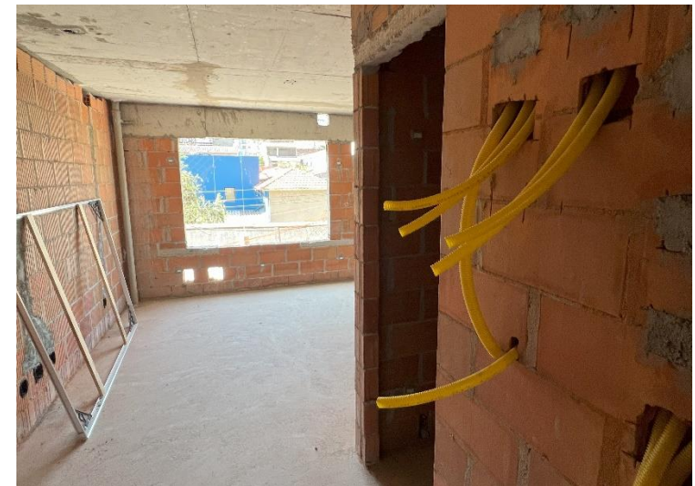
Embutidos em alvenaria – 2º Pav
