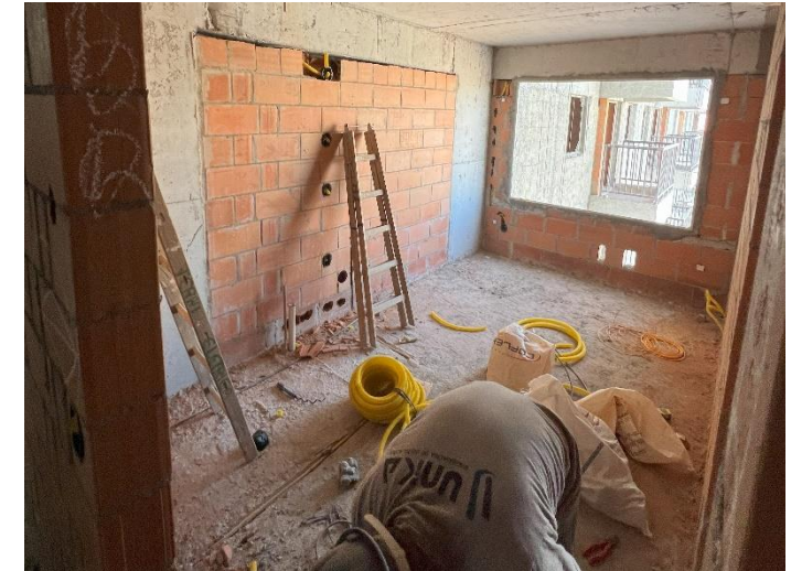
Embutidos em Alvenaria – 10º Pav
