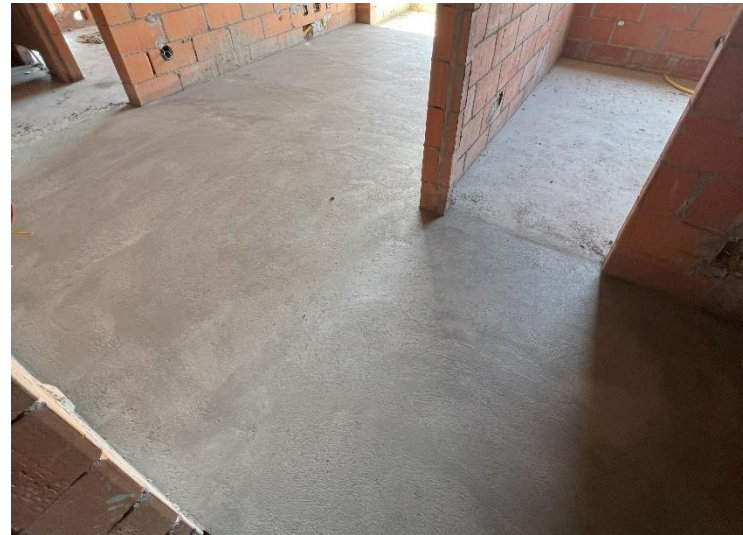
Contrapiso – 7º Pav
