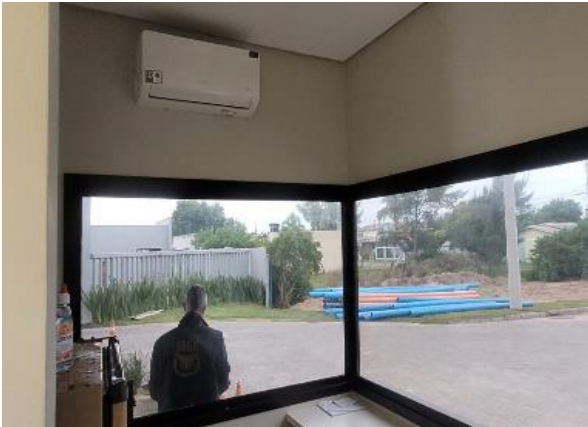
03 Ar Condicionado e Pintura - Guarita.
