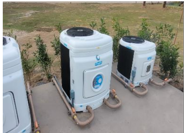
10 Bombas de Calor - Piscina.
