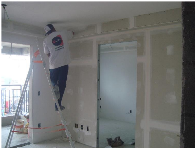
Parede Drywall – 4º pav
