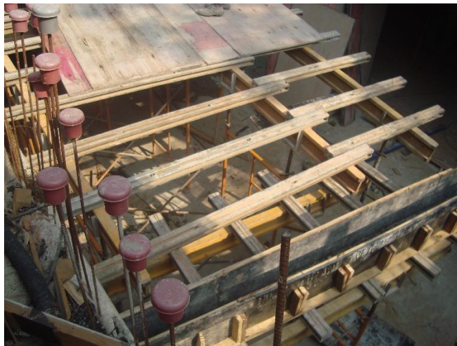
Escoramento Laje da Periferia – 1º SS
