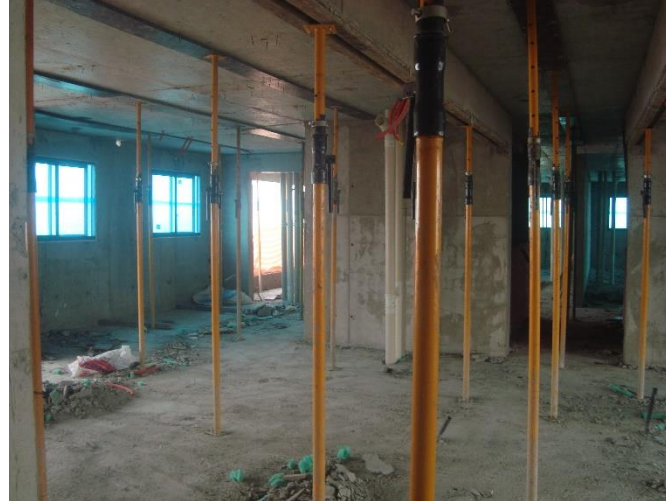
Vista Estrutura – 15° pav
