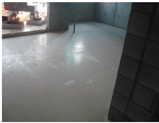
Contrapiso Autonivelante – 11° Pav
