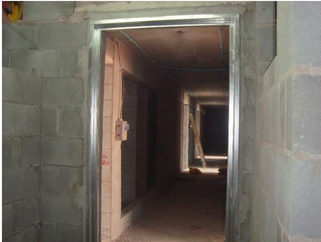
Batente Porta Corta Fogo – 8º pav
