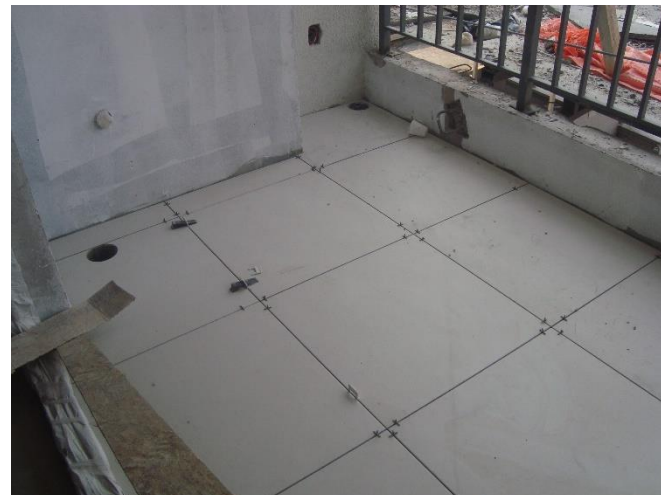
Revestimento Cerâmico – 3º Pav
