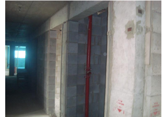
Prumada de Incêndio – 6º Pav
