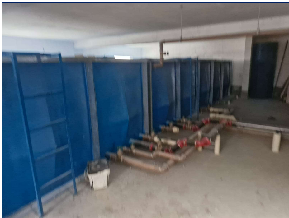
Foto 3 - Visão geral do barrilete e reservatórios montados
