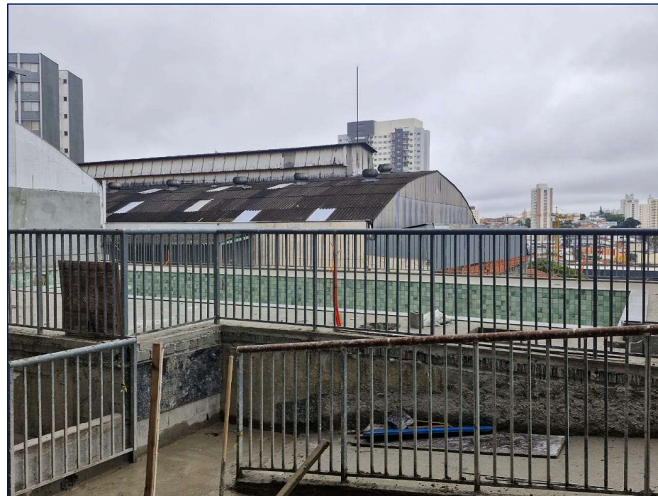
Foto 6 – Início revestimento piscina
