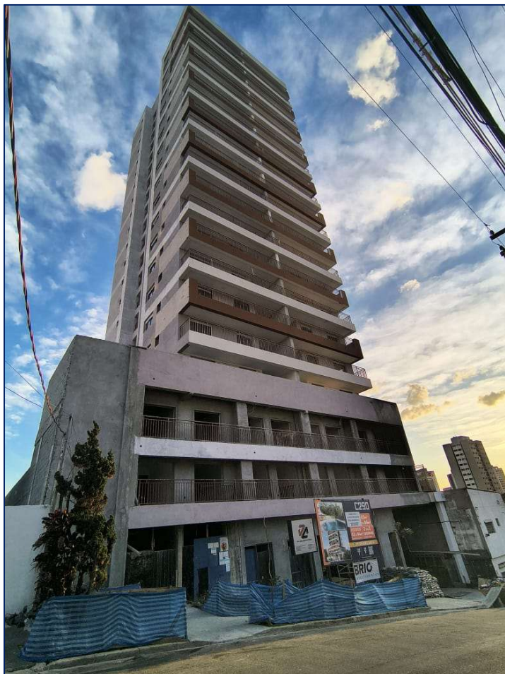
Foto 1 - Visão geral da fachada
