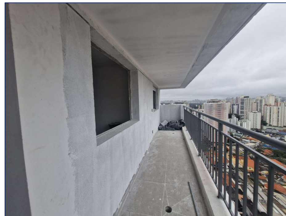
Foto 4 - Pintura forro da sacada e seladora - 21º pavimento
