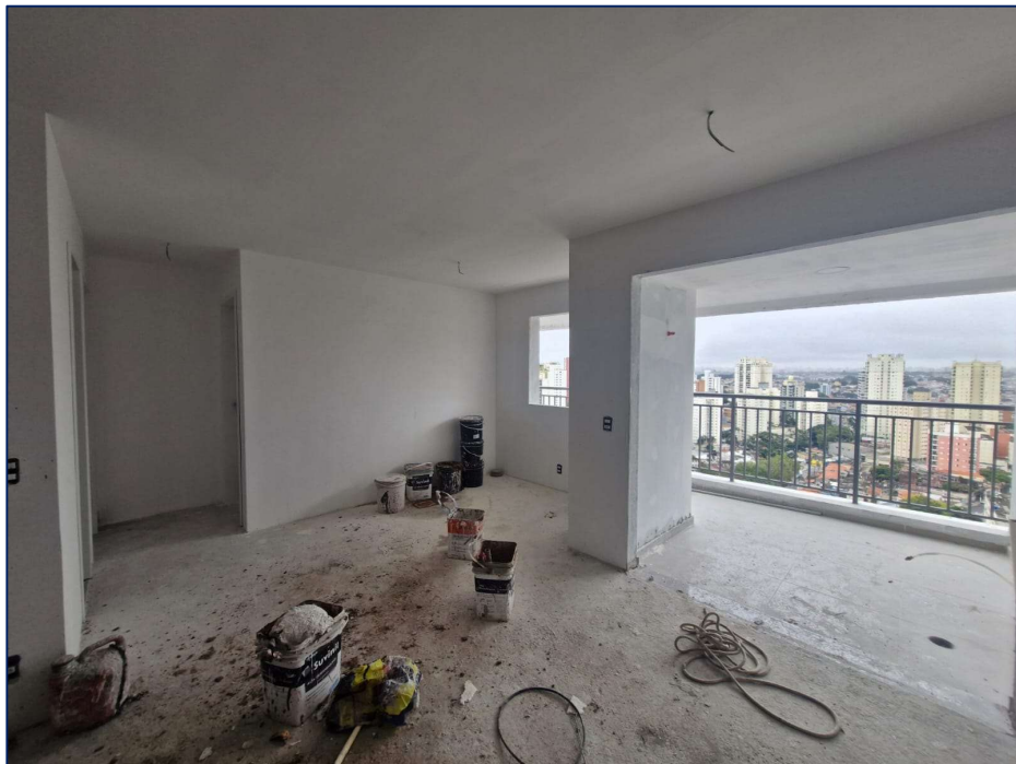
Foto 5 – Visão geral – 21º pavimento
