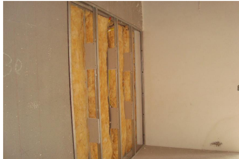
Estrutura Drywall – 5º Pav
