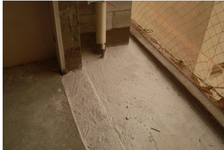
Impermeabilização – 9º Pav
