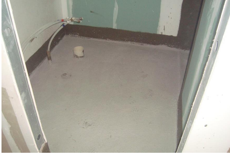
Impermeabilização – 2º Pav
