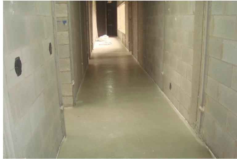
Piso Cimentício – 17º Pav
