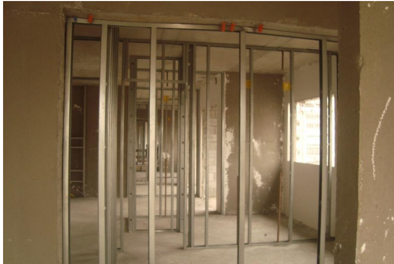
Estrutura Drywall – 14º Pav
