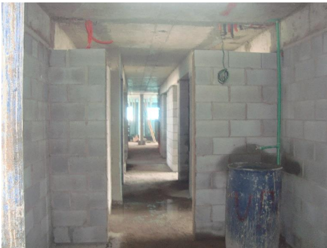
Alvenaria/ Vedação – 17° Pav
