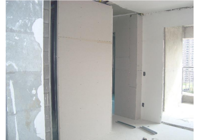
Alvenaria em Drywall – 10° Pav
