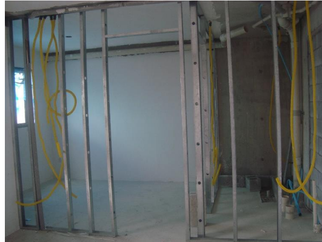
Estrutura Drywall – 11° pav
