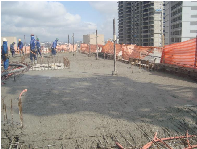
Concretagem de Laje – 24° pav
