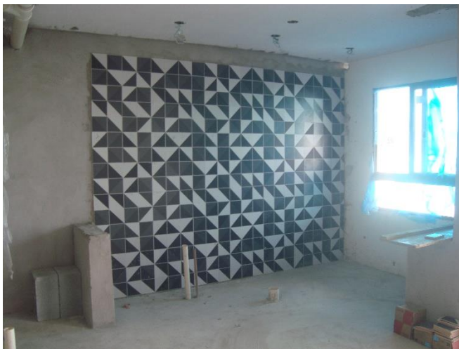
Revestimento Cerâmico – 3° pav
