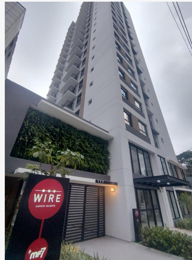
Vista da Fachada Frontal
